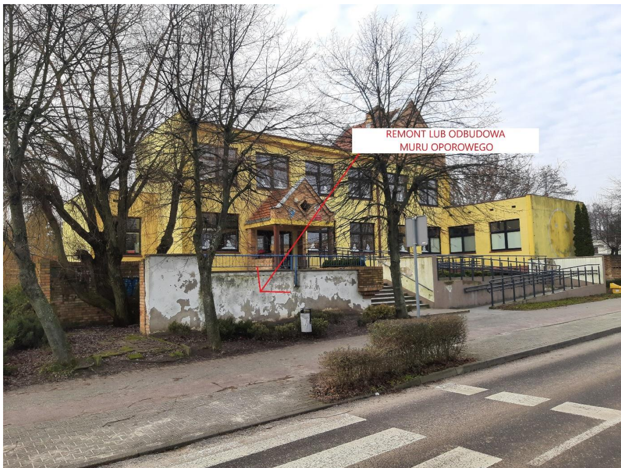
Zakres prac remontu lub rozbiórki z odbudową muru oporowego.
