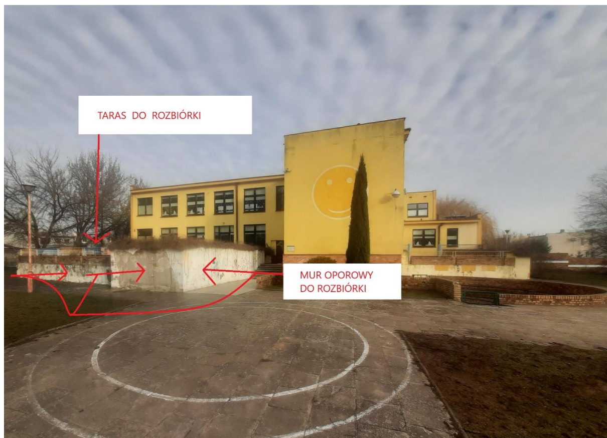
Zakres prac rozbiórkowych
