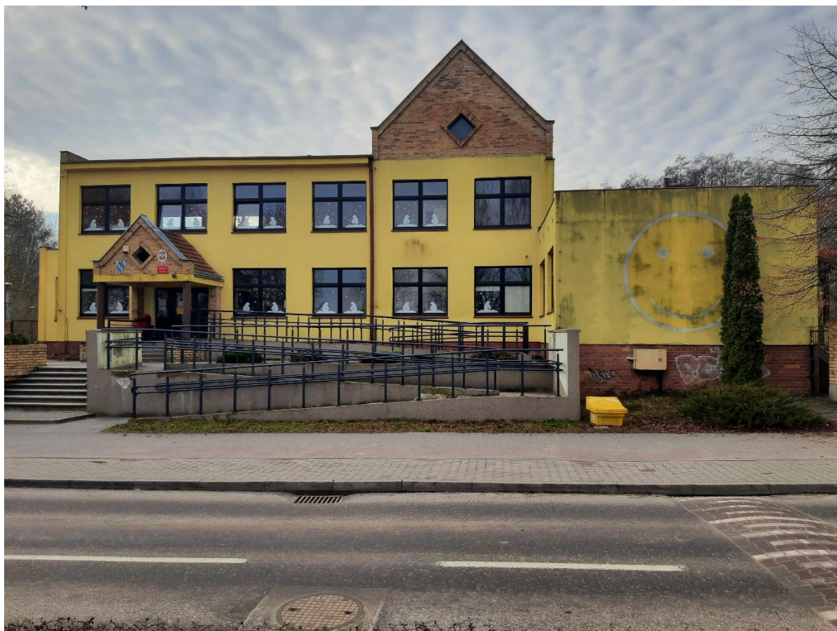
Widok budynku Przedszkola Słoneczko w miejscowości Murowana Goślina
