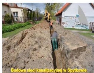
Budowa sieci kanalizacyjnej w Spytkowie
