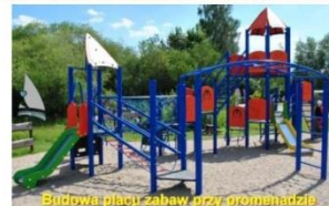
Budowa placu zabaw przy promenadzie
