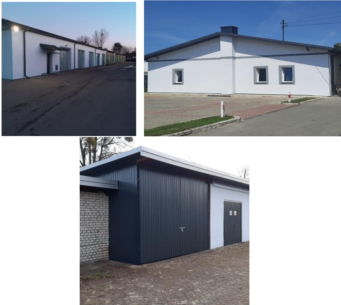
ZDJĘCIE 35 „REMONT ELEWACJI BUDYNKÓW ZLOKALIZOWANYCH NA BAZIE ZDP W KRASNYMSTAWIE”. ŹRÓDŁO: ZDP W KRASNYMSTAWIE.
