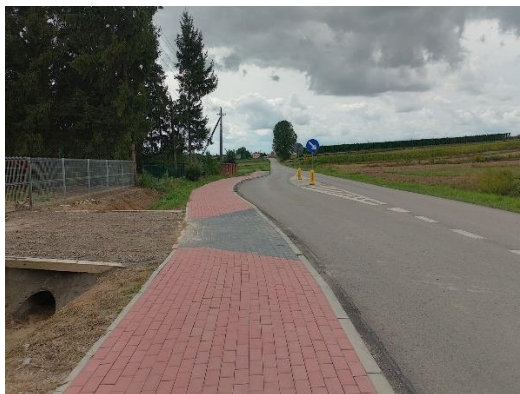
ZDJĘCIE 24 „ROZBUDOWA ODCINKA DROGI POWIATOWEJ NR 3113L, BUDOWA CHODNIKA W CIĄGU DROGI 3105L”.
