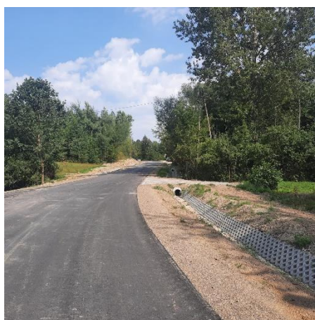
ZDJĘCIE 27 „ROZBUDOWA DROGI POWIATOWEJ NR 3112L SUSZEŃ-MAJDAN BOROWSKI PIERWSZY-SUCHE LIPIE OD KM 3+030 DO KM 3+763”. ŹRÓDŁO: ZDP W KRASNYMSTAWIE.
