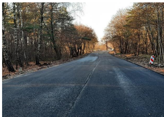
ZDJĘCIE 34 „ROZBUDOWA DROGI POWIATOWEJ NR 3128L BZITE – ZOSINEK OD KM 3+558 DO KM 5+733”. ŹRÓDŁO: ZDP W KRASNYMSTAWIE.
