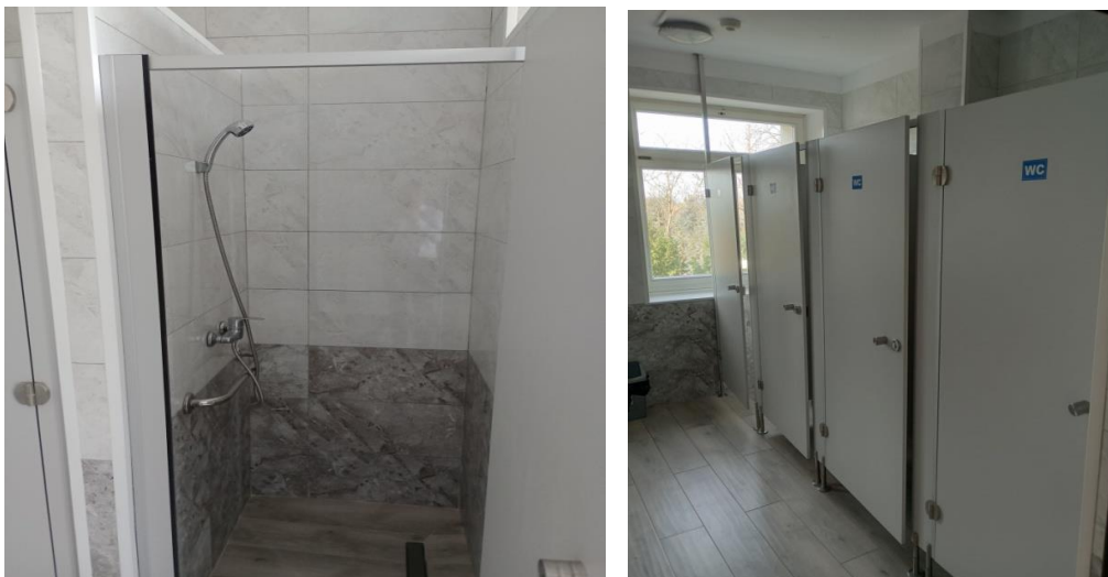
ZDJĘCIE 11 REMONT ŁAZIENEK NA 1 PIĘTRZE W DPS KRASNYSTAW. ŹRÓDŁO: DPS W KRASNYMSTAWIE.
