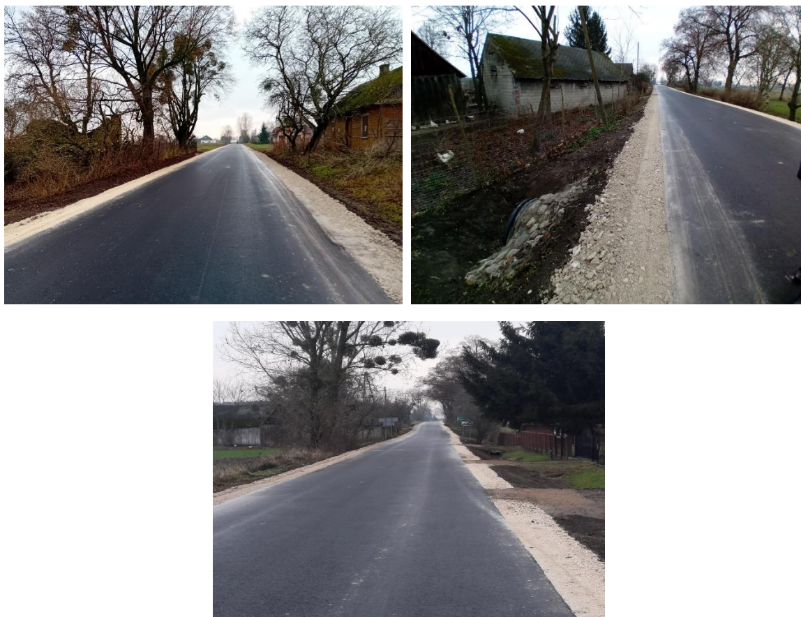
ZDJĘCIE 31 „REMONT DROGI POWIATOWEJ NR 3125L STĘŻYCA – STĘŻYCA NADWIEPRZAŃSKA OD KM 3+300 DO KM 4+032 DŁ. 0,732 KM”. ŹRÓDŁO: ZDP W KRASNYMSTAWIE.
