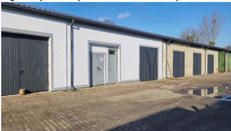
ZDJĘCIE 36 „ZAKUP BRAM GARAŻOWYCH DO BUDYNKÓW NA BAZIE ZDP W KRASNYMSTAWIE”. ŹRÓDŁO: ZDP W KRASNYMSTAWIE.
