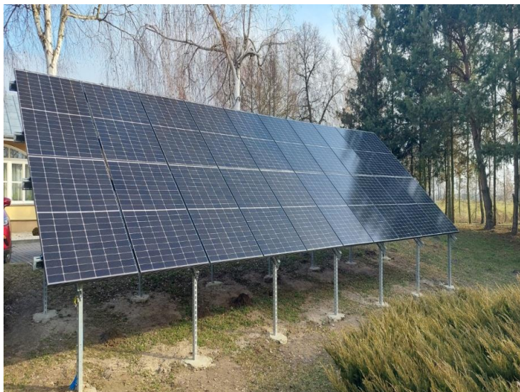
ZDJĘCIE 17 MONTAŻ INSTALACJI FOTOWOLTAICZNEJ. ŹRÓDŁO: DPS KRASNYSTAW.
