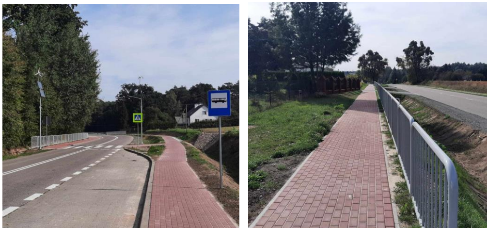
ZDJĘCIE 23 „BUDOWA CHODNIKA ORAZ PRZEJŚCIA DLA PIESZYCH W CIĄGU DROGI POWIATOWEJ NR 3135L KRASNYSTAW UL. WITOSA - SIENNICA RÓŻANA OD KM 3+954 DO KM 5+478”. ŹRÓDŁO: ZDP W KRASNYMSTAWIE.
