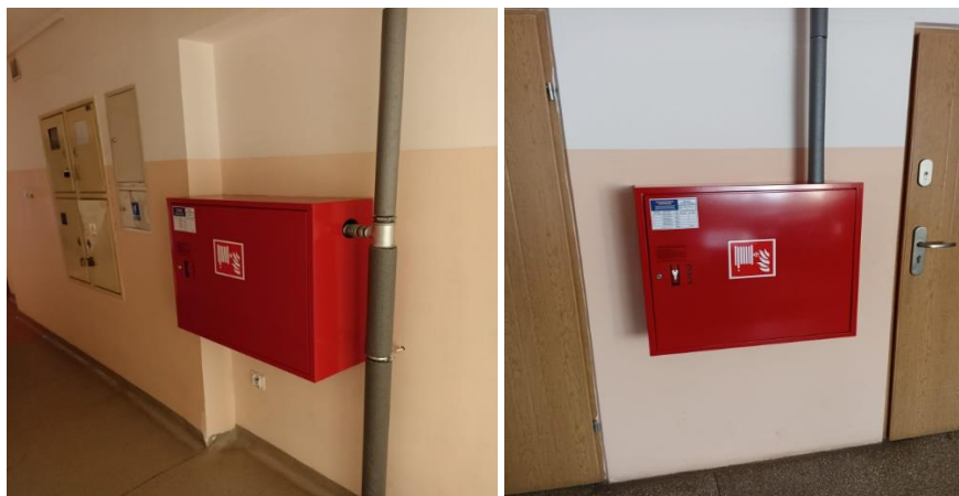
ZDJĘCIE 20 MODERNIZACJA INSTALACJI WODNEJ I HYDRANTOWEJ. ŹRÓDŁO: CAPOW W KRASNYMSTAWIE.
