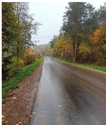
ZDJĘCIE 29 „ROZBUDOWA ODCINKA DROGI POWIATOWEJ NR 3128L BZITE – ZOSINEK” TJ. OD KM 5+733 DO KM 5+858 I OD KM 5+858 DO KM 6+689. ŹRÓDŁO: ZDP W KRASNYMSTAWIE.
