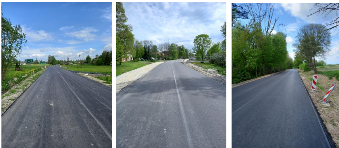
ZDJĘCIE 31 „ROZBUDOWA DROGI POWIATOWEJ NR 3114L CHORUPNIK – PIASKI SZLACHECKIE – IŻBICA OD KM 0+980 DO KM 5+838 O DŁ. 4,858 KM” - W TRAKCIE PRAC ŹRÓDŁO: ZDP W KRASNYMSTAWIE.
