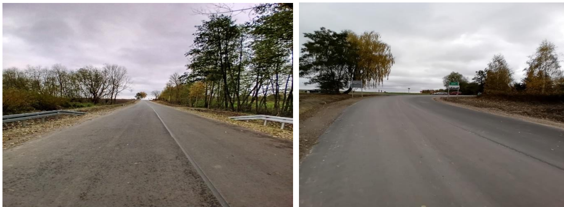
ZDJĘCIE 25 „ROZBUDOWA I PRZEBUDOWA DRÓG POWIATOWYCH NR 2118L, NR 3112L I NR 3122L W CELU POPRAWY BEZPIECZEŃSTWA RUCHU DROGOWEGO” W ZAKRESIE PRZEBUDOWY DROGI POWIATOWEJ NR 3122L ŁOPIENNIK – ŻULIN – REJOWIEC O DŁ. 0,286 KM ŹRÓDŁO: ZDP W KRASNYMSTAWIE.
