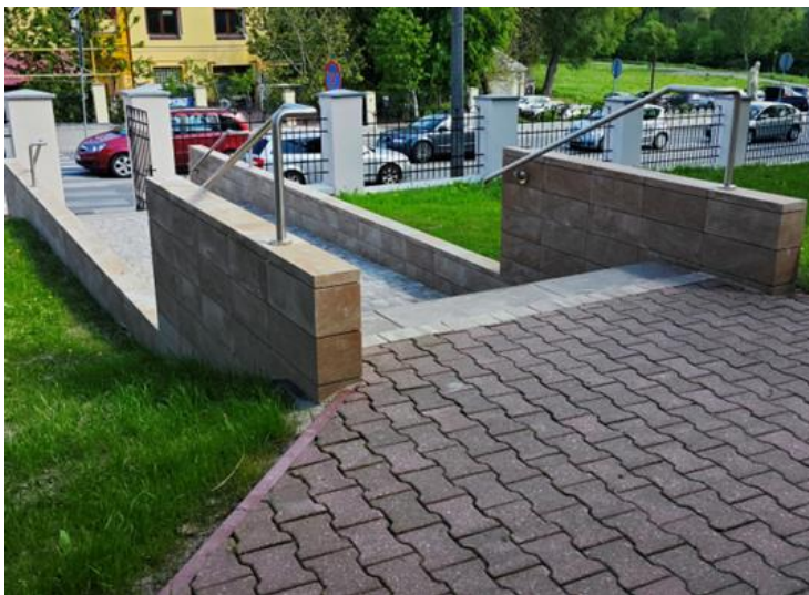
ZDJĘCIE 32 WYREMONTOWANE SCHODY W PUP W KRASNYMSTAWIE. ŹRÓDŁO: OPRACOWANIE PUP W KRASNYMSTAWIE
