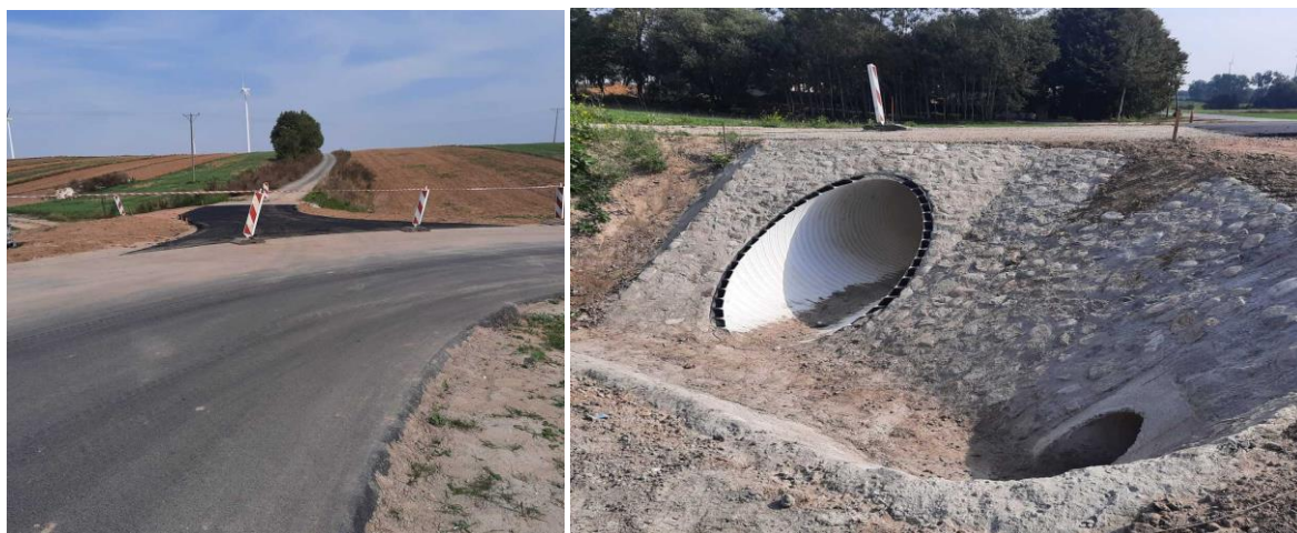
ZDJĘCIE 22 „ROZBUDOWA DROGI POWIATOWEJ NR 3103L ŻÓŁKIEWKA – CELIN OD KM 0+470 DO KM 1+350 I PRZEBUDOWA DROGI POWIATOWEJ NR 3103L ŻÓŁKIEWKA – CELIN OD KM 1+350 DO KM 1+700 ORAZ PRZEBUDOWA PRZEPUSTU W KM 1+368”. ŹRÓDŁO: ZDP W KRASNYMSTAWIE.
