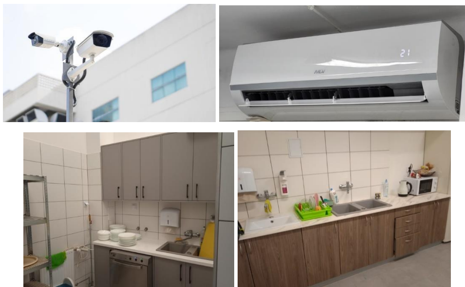
ZDJĘCIE 9 OD LEWEJ GÓRY: SYSTEM MONITORINGU, KLIMATYZACJA, MEBLE. ŹRÓDŁO: SPZOZ W KRASNYMSTAWIE.
