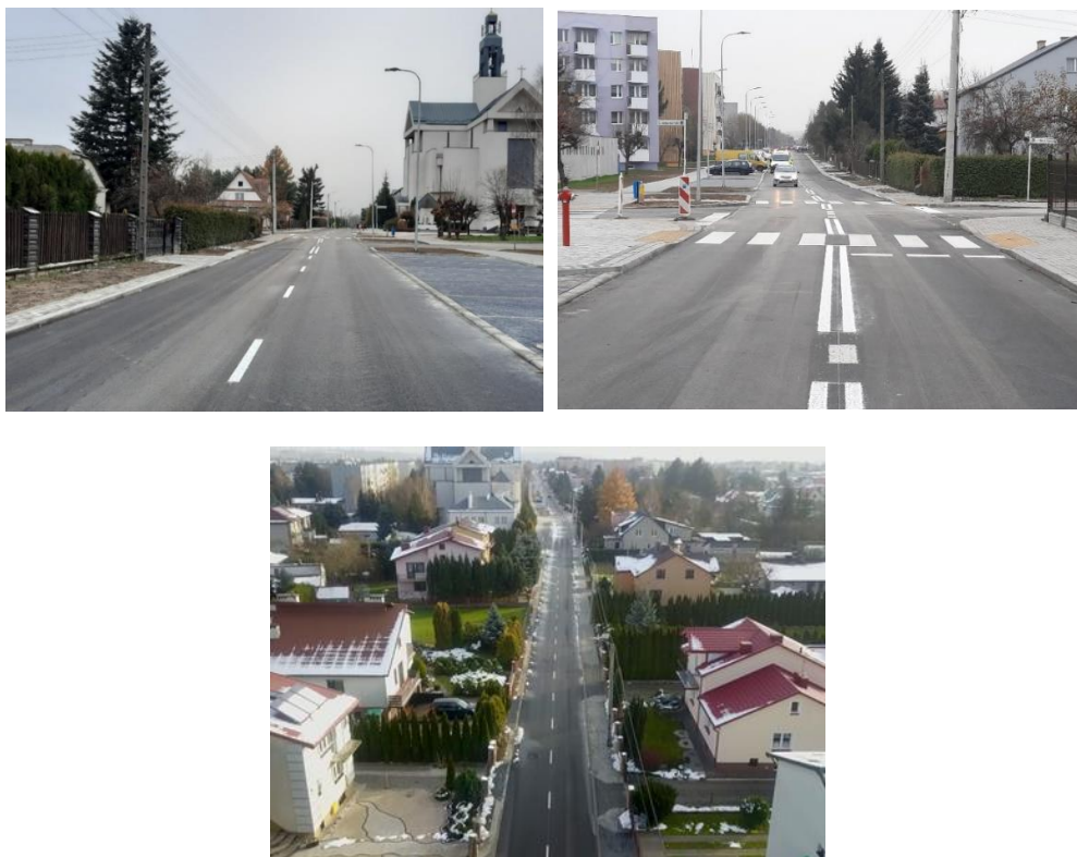
ZDJĘCIE 29 ROZBUDOWA DROGI POWIATOWEJ NR 3162L UL. SOBIESKIEGO NA ODCINKU OD UL. CHMIELNEJ DO UL. BOJARCZUKA W KRASNYMSTAWIE. ŹRÓDŁO: ZDP W KRASNYMSTAWIE.
