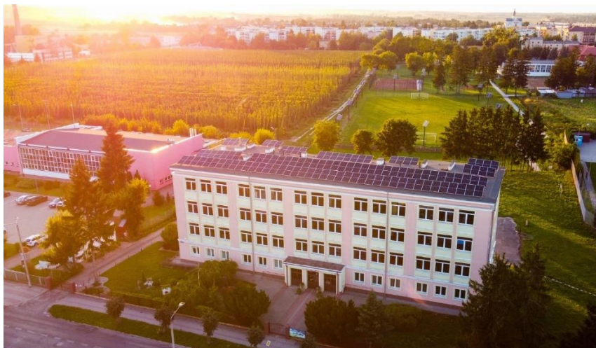
ZDJĘCIE 20 PANELE FOTOWOLTAICZNE NA BUDYNKU I LO IM. WŁ. JAGIEŁŁY W KRASNYMSTAWIE. ŹRÓDŁO: ZASOBY WŁASNE.
