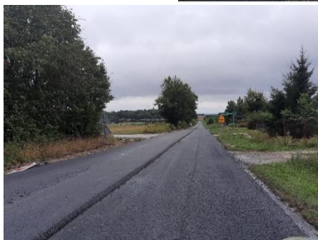
ZDJĘCIE 31 POPRAWA BEZPIECZEŃSTWA RUCHU DROGOWEGO POPRZECZ ROZBUDOWĘ DROGI POWIATOWEJ NR 3110L CHORUPNIK – RUDNIK – MOŚCISKA – W TRAKCIE PRAC. ŹRÓDŁO: ZDP W KRASNYMSTAWIE.
