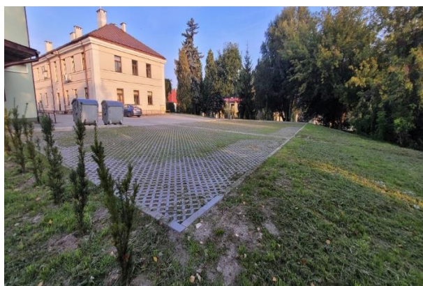
Zdjęcie 43 Utwardzenie terenu przy PUP w Krasnymstawie płytami ażurowymi. Źródło: PUP w Krasnymstawie
