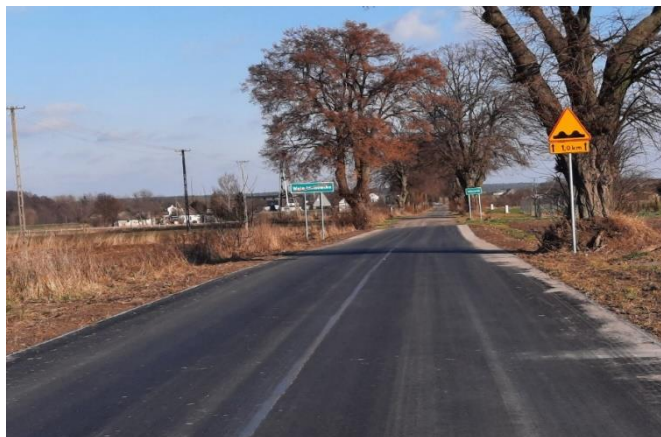
Zdjęcie 39 „Remont drogi powiatowej Nr 2121L Fajstławice – Wola Idzikowska – Oleśniki o łącznej dł. 0,458 km”. Źródło: ZDP w Krasnymstawie.
