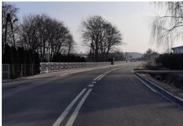
Zdjęcie 36 „Rozbudowa drogi powiatowej nr 1836L Wierchowiny – droga powiatowa nr 1835L o dł. 0,515 km”. Źródło: ZDP w Krasnymstawie
