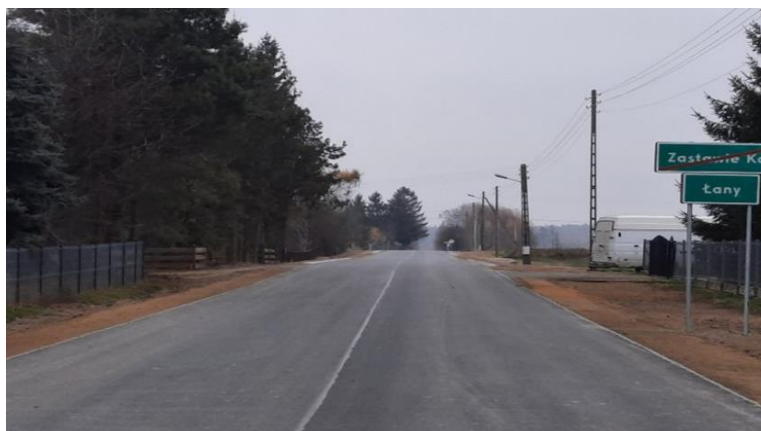
Zdjęcie 33 „Rozbudowa drogi powiatowej nr 3137L Krasnystaw - Łany - Kolonia Chełmiec w m. Łany na odc. 2,122km.
