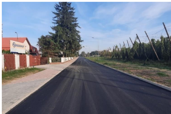
Zdjęcie 40 „Przebudowa ulicy Granicznej w Krasnymstawie o dł. 0,677 km”. Źródło: ZDP w Krasnymstawie.
