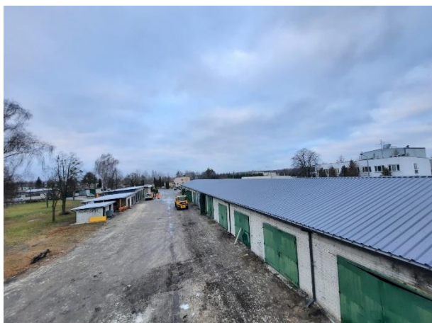
Zdjęcie 42 „Modernizacja zaplecza technicznego Zamawiającego polegająca na wymianie pokrycia dachu na budynku garażowo – magazynowym. Źródło: ZDP w Krasnymstawie.
