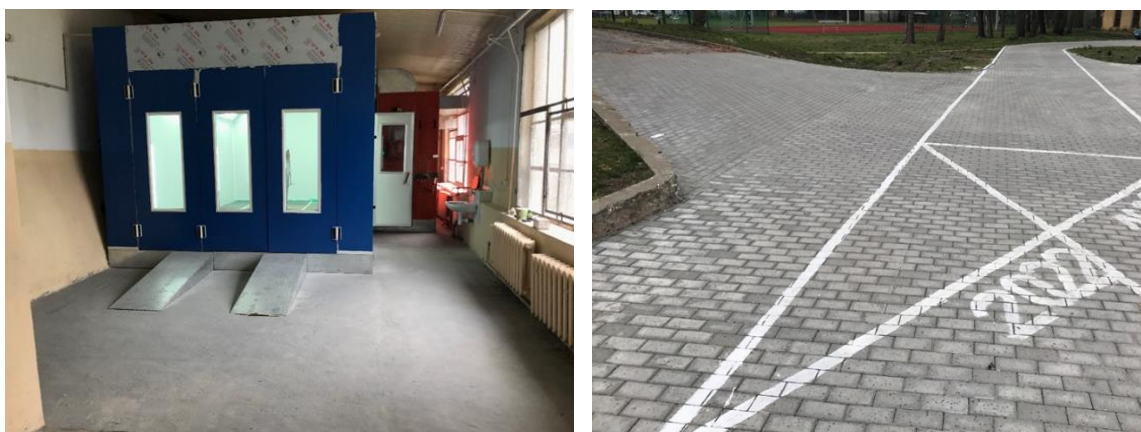
Zdjęcie 17 Pomieszczenie do montażu kabiny lakierniczej oraz kostka brukowa przed budynkiem warsztatów mechanicznych w ZS Nr 1 w Krasnymstawie. Źródło: ZS Nr 1 w Krasnymstawie.
