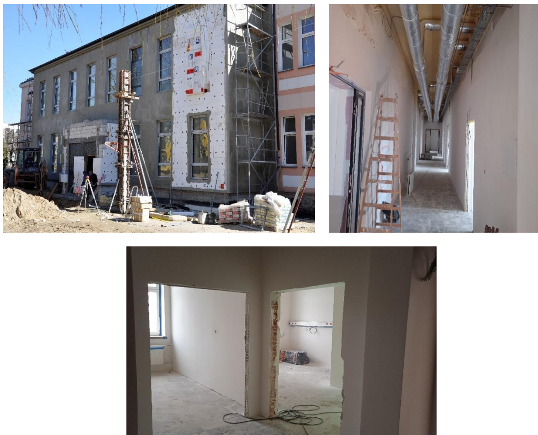
Zdjęcie 5 Dostosowanie budynku pulmonologii na potrzeby Zakładu Opiekuńczo Leczniczego roboty przeprowadzone w 2021 r. Źródło: SP ZOZ w Krasnymstawie.
