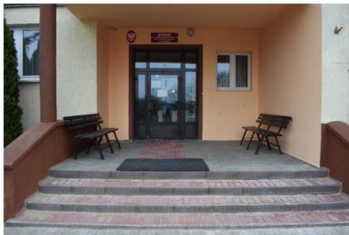
Zdjęcie 14 Wyremontowane schody i drzwi aluminiowe w wejściu do internatu przy I LO. Źródło: I LO w Krasnymstawie
