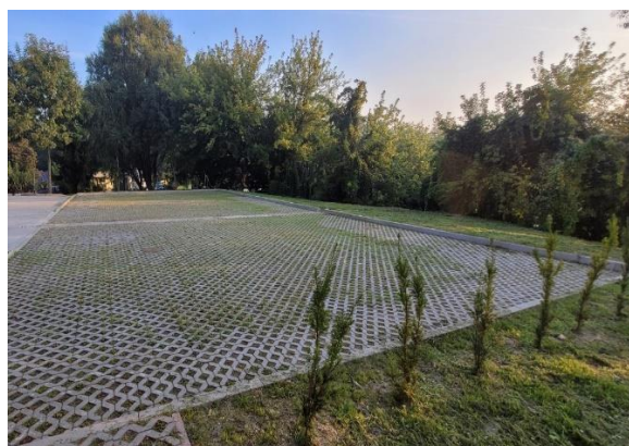
Zdjęcie 43 Utwardzenie terenu przy PUP w Krasnymstawie płytami ażurowymi. Źródło: PUP w Krasnymstawie
