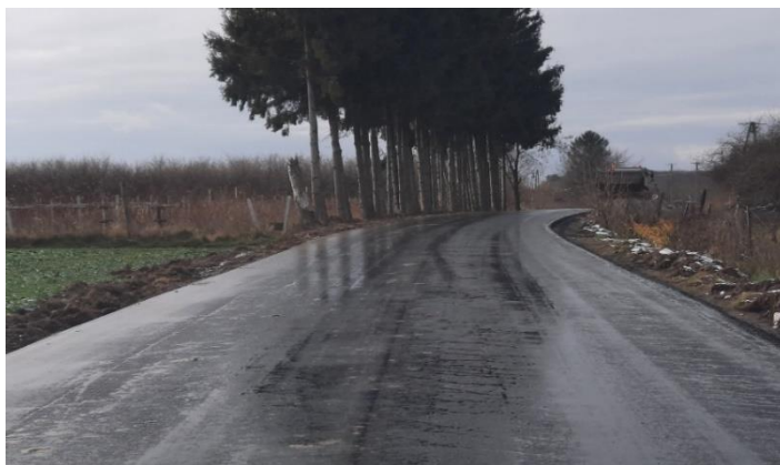
Zdjęcie 38 „Przebudowa drogi powiatowej nr 3118L Felicjan – Bobrowe – Wielobycz o dł. 0,726 km”. Źródło: ZDP w Krasnymstawie
