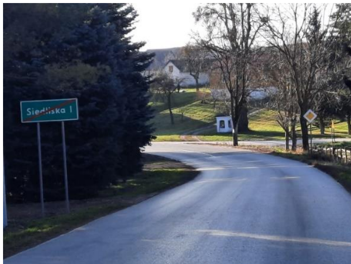
Zdjęcie 41, „Przebudowa drogi powiatowej nr 3124L Suchodoły - Siedliska - Ksawerówka o dł. 1,825,50 km”. Źródło: ZDP w Krasnymstawie.
