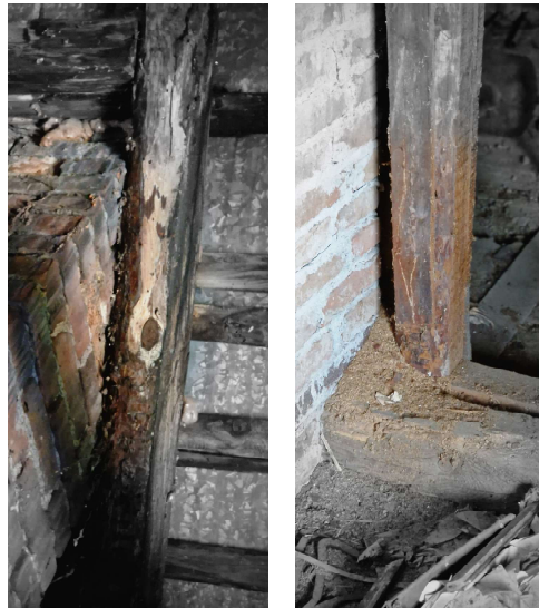
ZNISZCZONE ELEMENTY WIEŻBY DACHOWEJ
