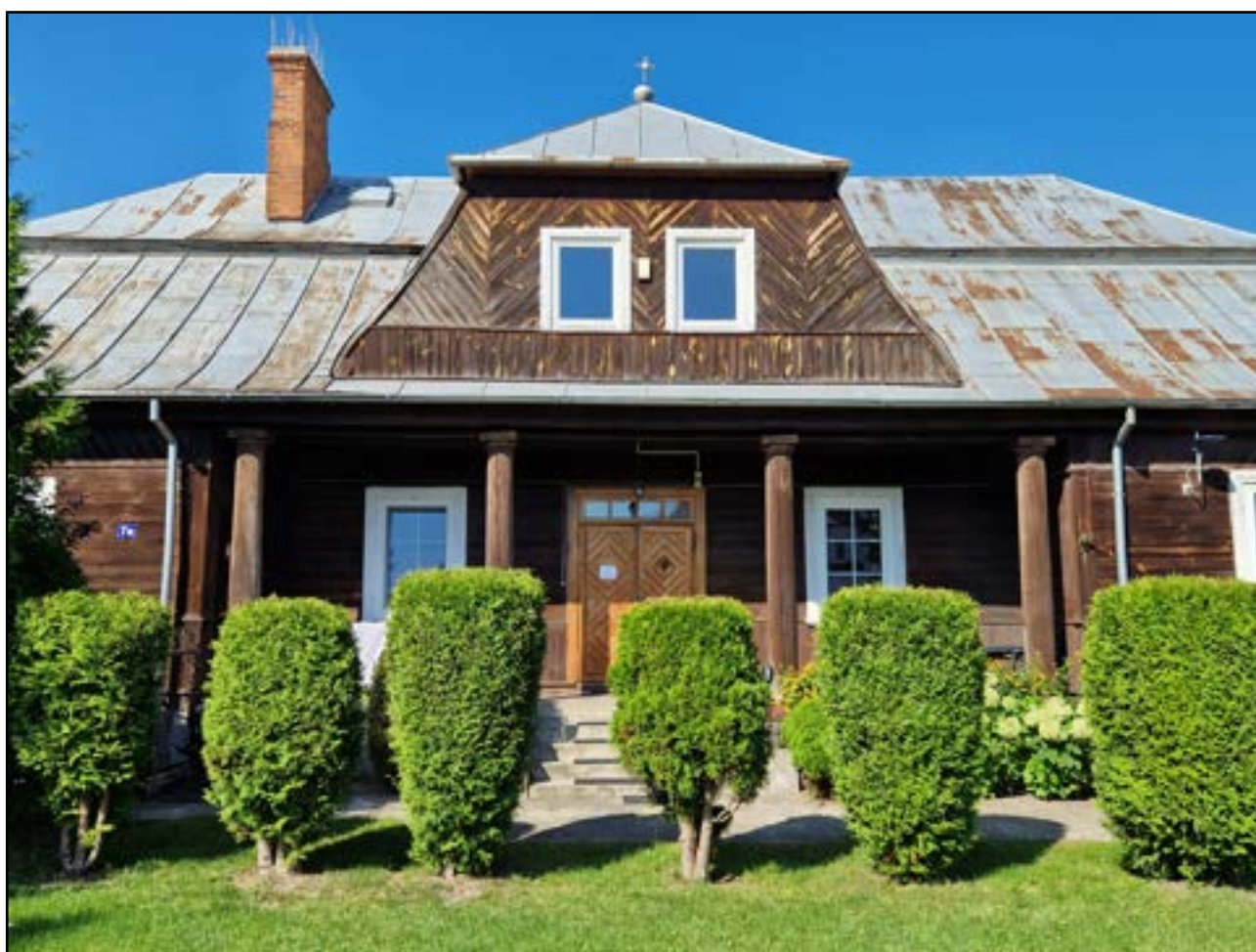
Fot 1: Plebania, Parafia Rzymskokatolicka pw. Św. Jana Apostoła w Nurze; stan obiektu przed konserwacją.
