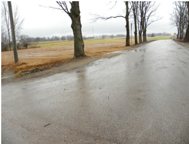
Ul. Cmentarna – wjazd na parking od strony skrzyżowania z ulicą Brokowską
