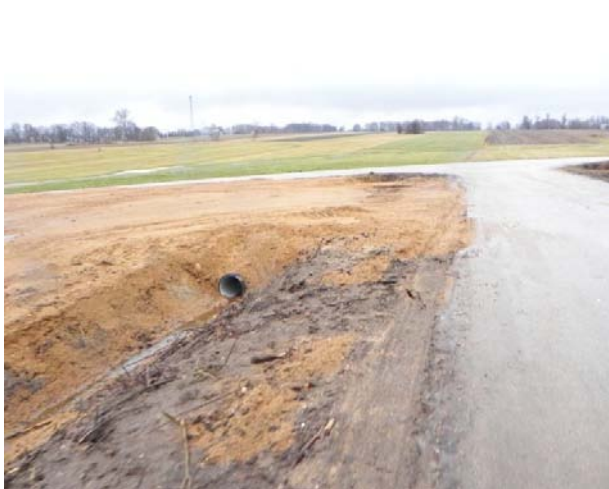
Ul. Cmentarna – wjazd na parking w rejonie skrzyżowania z ulicą Ogrodową
