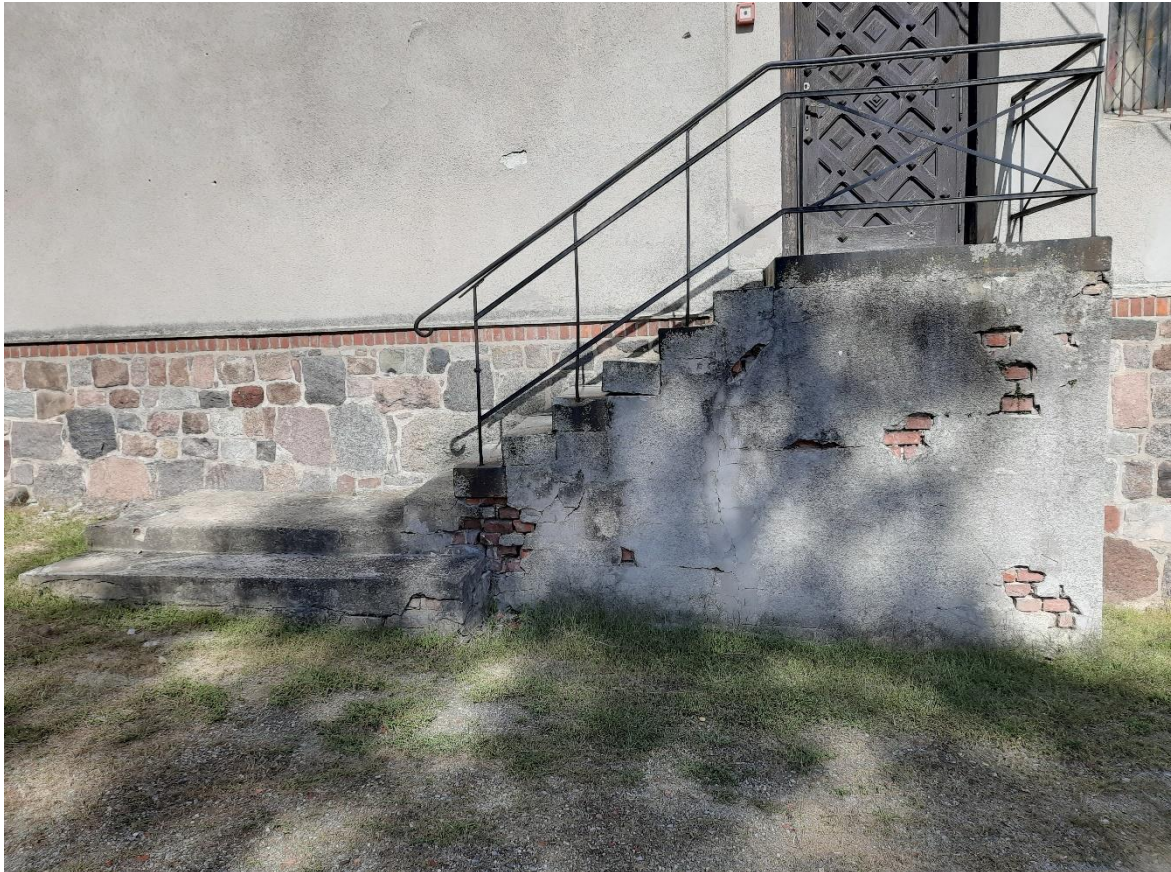
Schody do zakrystii
