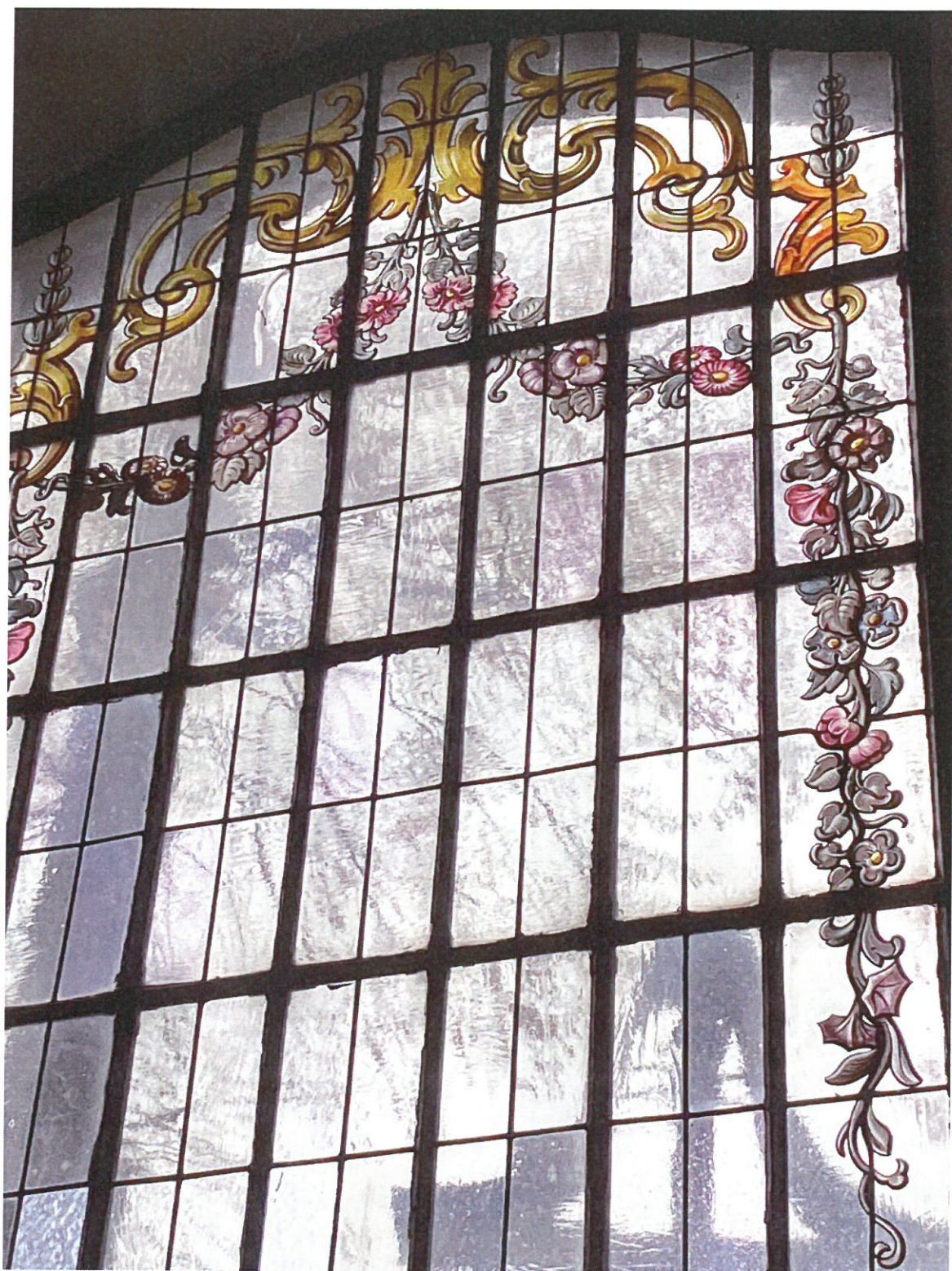
Fot. 8. Detal witraża – charakterystyczne szkła antyczne oraz subtelnie opracowane warstwy malarskie. Widoczne zabrudzenia powierzchni pochodzące od licznych warstw farby na metalowych ramach
