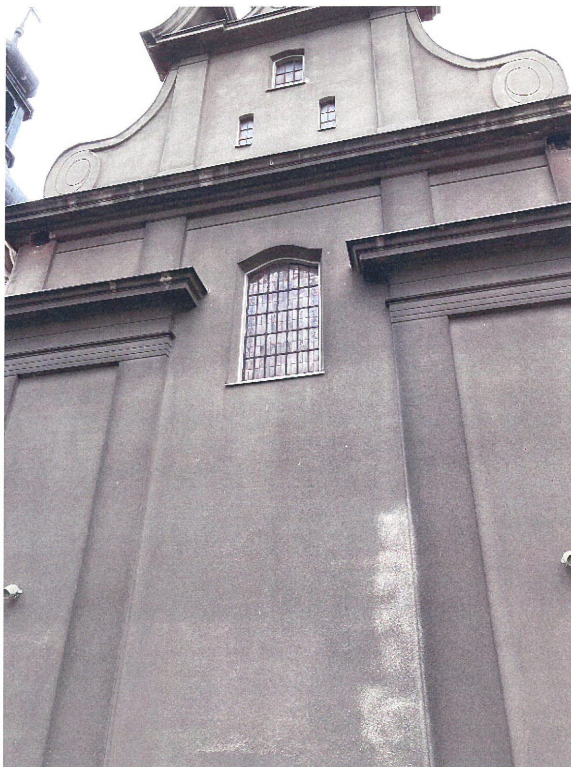
Fot.7. Przeszklenie techniczno-architektoniczne przed konserwacją i restauracją – brak przeszklenia zabezpieczającego
