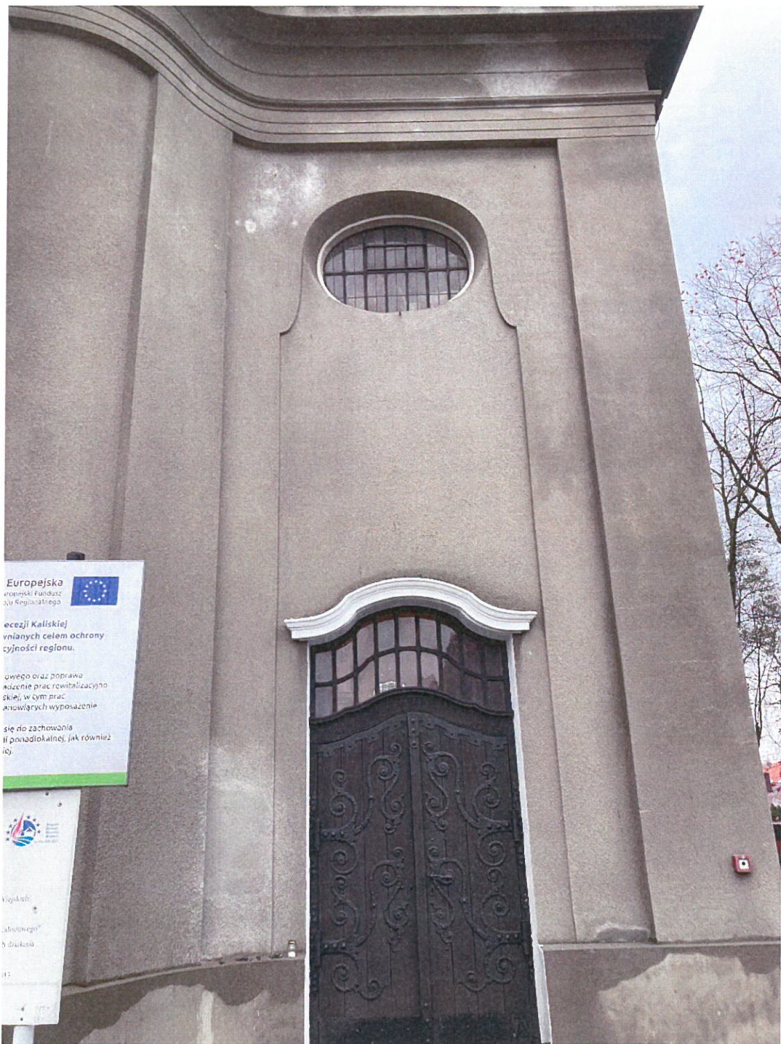
Fot.6. Przeszklenia barokowe nie wchodzące w zakres prac konserwatorsko-restauratorskich
