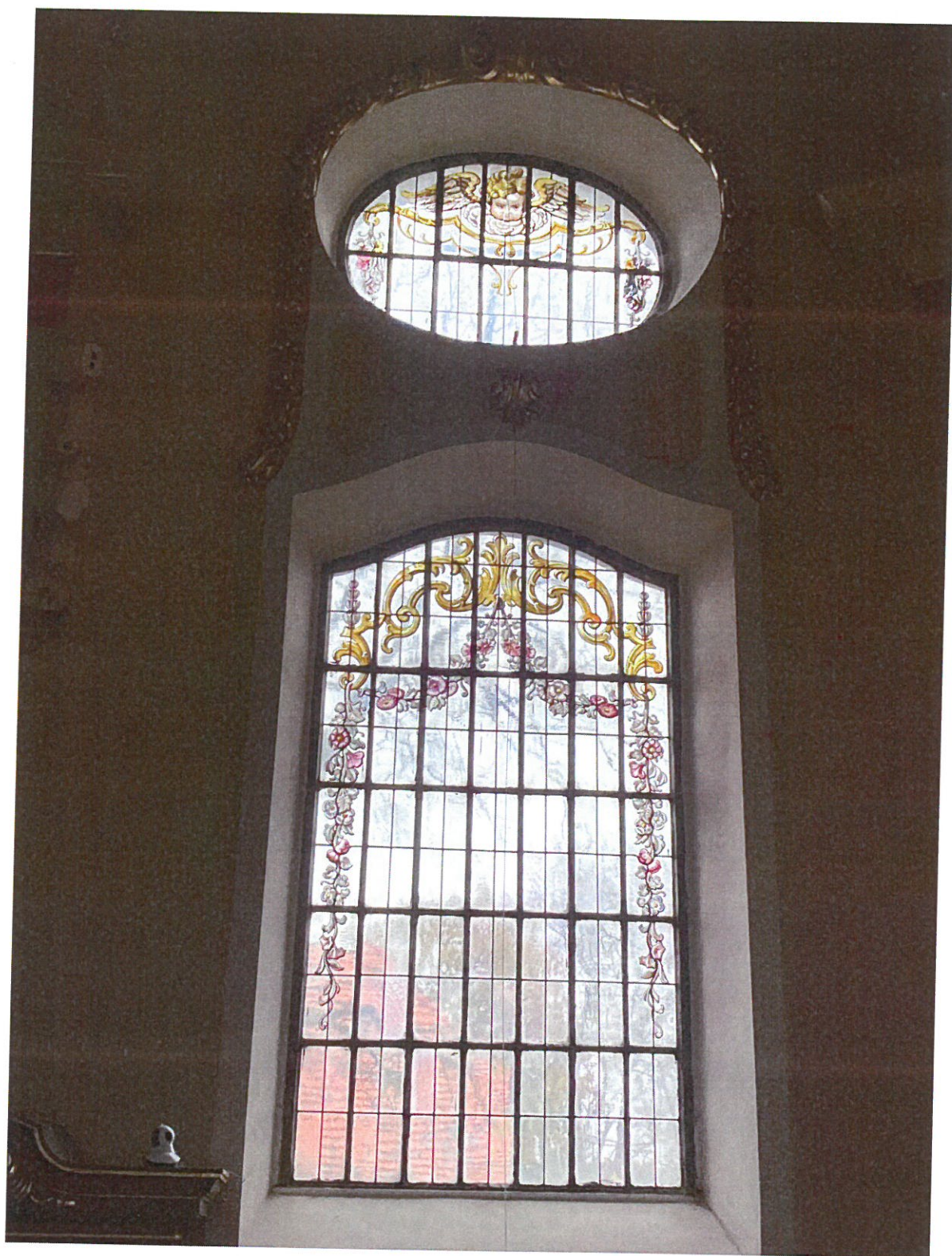
Fot.4. Okno nawy bocznej z dekoracyjnymi przeszklzeniami techniczno-architektonicznymi – widok przed konserwacją i restauracją w świetle przechodzącym, od wnętrza kościoła
