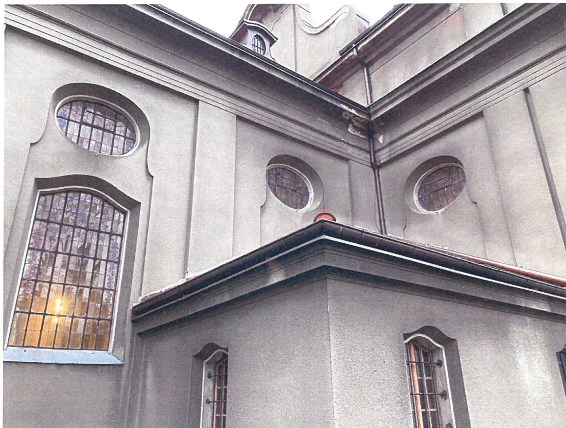
Fot.1. Widok od strony północno-zachodniej
