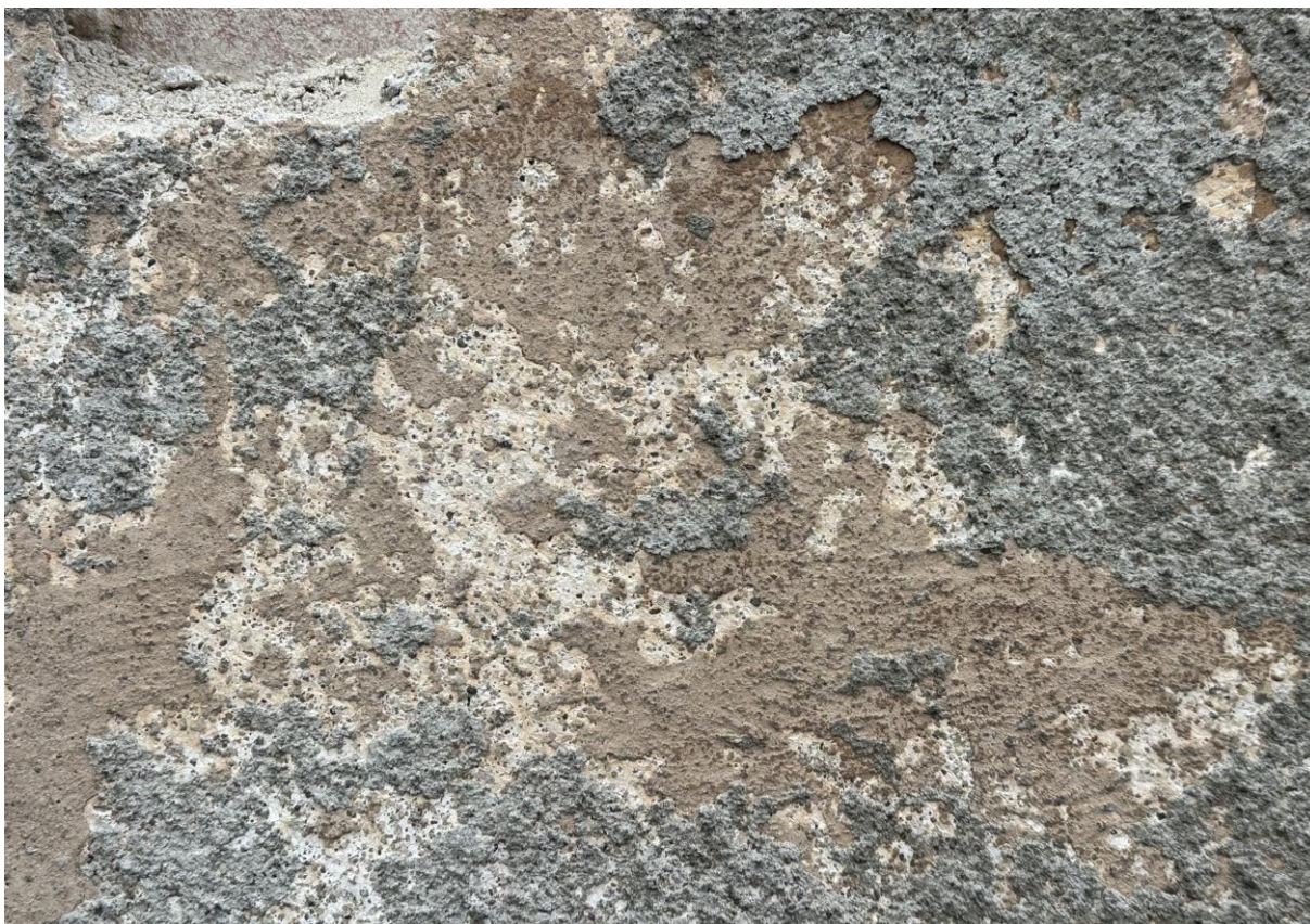
Fot. 15. Odkrywka naturalna nr 7 na fragmencie elewacji wschodniej w partii szczytowej, widoczna stratygrafia warstw z fragmentami oryginalnej, ugrowo-beżowej warstwy polichromii, drugiej chronologicznej warstwy polichromii w ciemniejszym odcieniu oraz wtórnej, szarej obrzutki cementowej.
