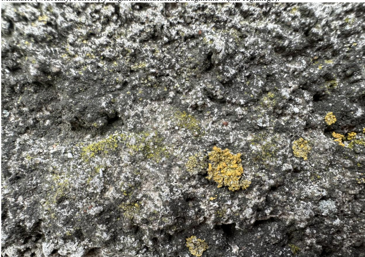
Fot. 20. Fragment partii przycokołowej elewacji północnej budynku przy ul. Grabowskiej 1 w Mikstacie, widoczne zawilgocenia powierzchni cementowego tynku z widoczną „korozją biologiczną” (pleśń, grzyby, porosty, mech), stan obecny.
