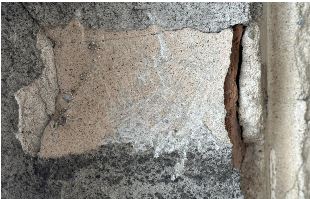
Fot. 11 Odkrywka nr 5 na fragmencie elewacji północnej w partii gzymsu, widoczna stratygrafia warstw z fragmentami oryginalnej j ugrowo-beżowej warstwy polichromii oraz wtórnej, szarej obrzutki cementowej.
