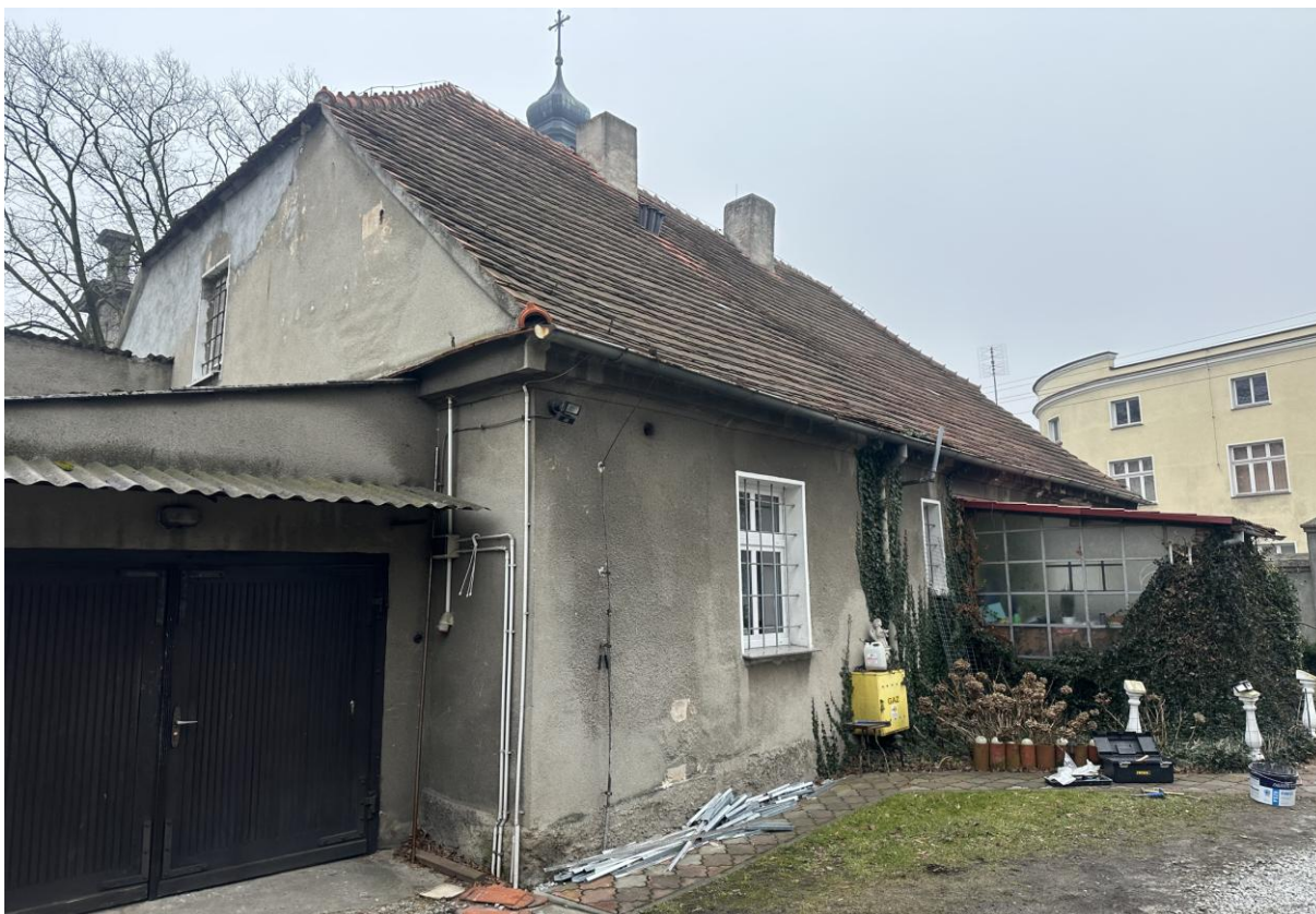
Fot. 5. Widok budynku plebani przy ul. Grabowskiej 1 w Mikstacie od strony północno-wschodniej, widoczne naprawy zniszczonego tynku w partii ściany szczytowej wskutek wadliwego systemu odprowadzania wody, stan obecny.
