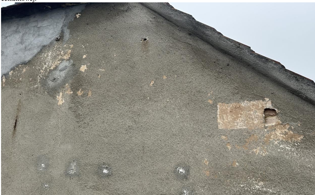
Fot. 14. Widok elewacji wschodniej (ściana szczytowa) budynku przy ul. Grabowskiej 1 w Mikstacie, fragment, widoczne odkrywki ze śladami oryginalnej polichromii w kolorze ugrowobeżowym oraz wtórne warstwy: szarej obrzutki cementowej oraz gładkie, późniejsze, szare wyprawki cementowe, stan obecny.
