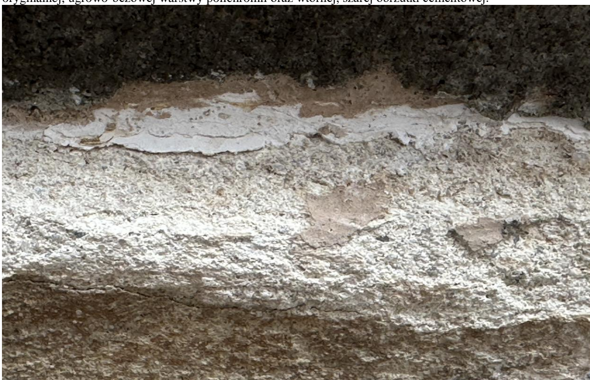
Fot. 10 Odkrywka nr 4 na fragmencie elewacji północnej w partii gzymsu, widoczna stratygrafia warstw z fragmentami oryginalnej i chronologicznie drugiej ugrowo-beżowej warstwy polichromii oraz wtórnej, szarej obrzutki cementowej.
