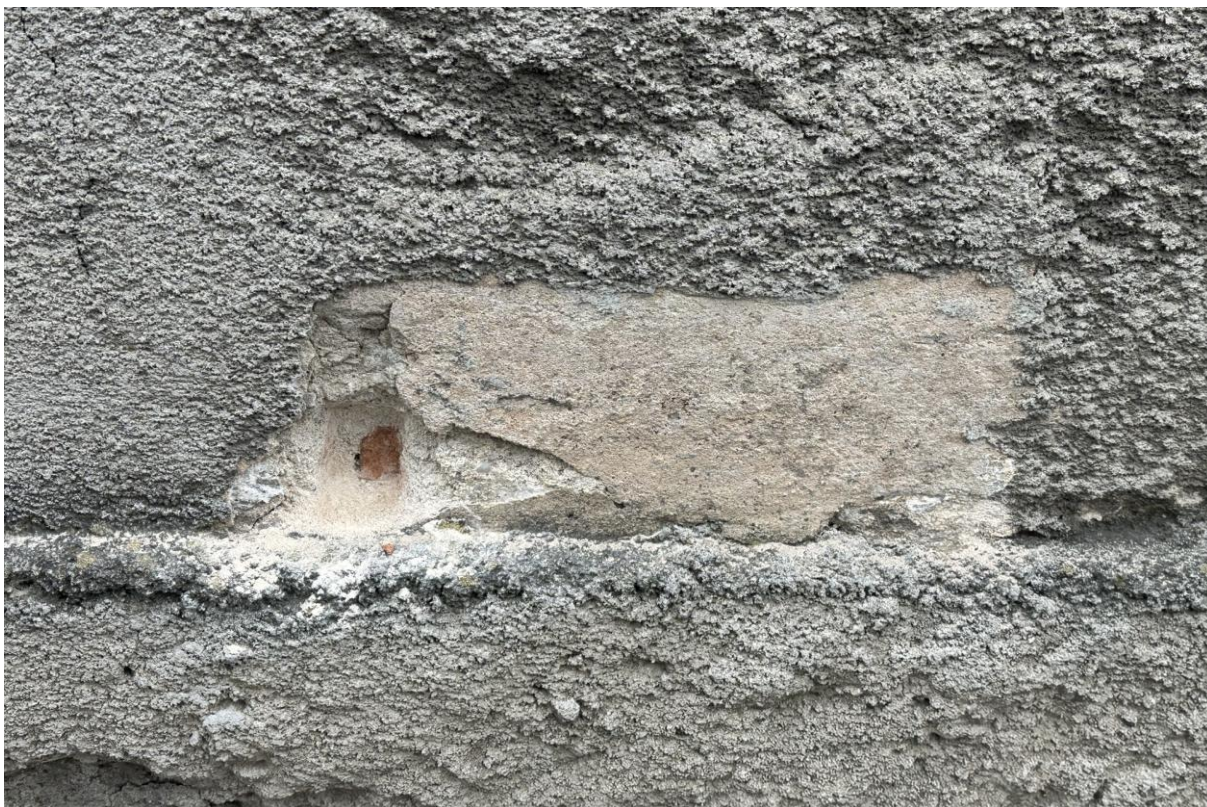
Fot. 13. Odkrywka nr 6 na fragmencie elewacji północnej w partii przycokołowje, widoczna stratygrafia warstw z fragmentami oryginalnej ugrowo-beżowej warstwy polichromii oraz wtórnej, szarej obrzutki cementowej.
