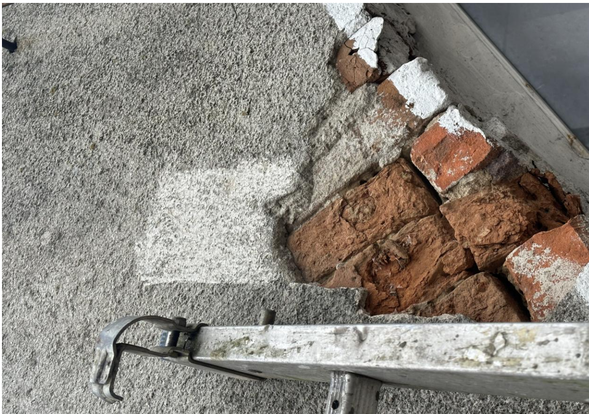
Fot. 19. Widok spękaną, zniszczoną część szczytowej elewacji zachodniej budynku przy ul. Grabowskiej 1 w Mikstacie (widoczny, odsłonięty fragment zniszczonego fragmentu wątku ceglanego).
