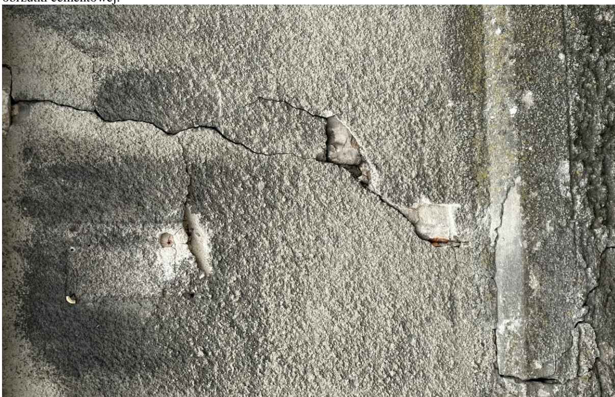
Fot. 18. Fragment spękanej, zniszczonej elewacji zachodniej budynku plebani przy ul. Grabowskiej 1 w Mikstacie, widoczne spękania muru oraz wtórnej, szarej obrzutki cementowej.
