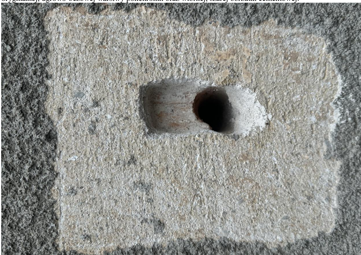
Fot. 8 Odkrywka nr 2 na fragmencie elewacji północnej, widoczna stratygrafia warstw z fragmentami oryginalnej, ugrowo-beżowej warstwy polichromii oraz wtórnej, szarej obrzutki cementowej.
