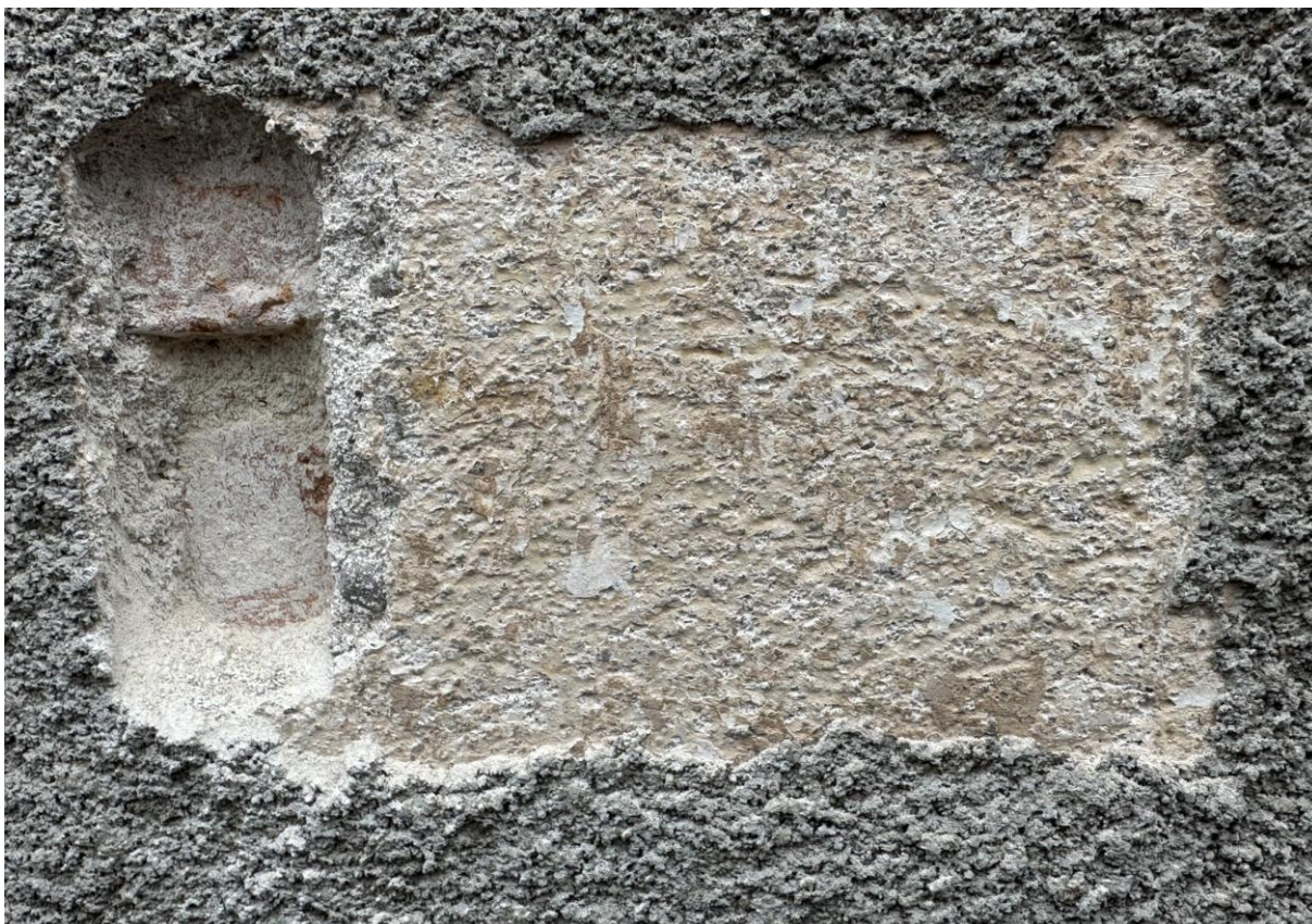
Fot. 7. Odkrywka nr 1 na fragmencie elewacji północnej, widoczna stratygrafia warstw z fragmentami oryginalnej, ugrowo-beżowej warstwy polichromii oraz wtórnej, szarej obrzutki cementowej.
