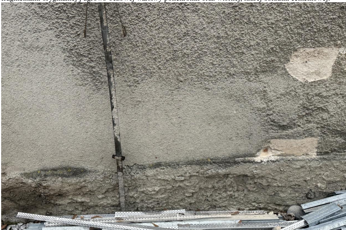
Fot. 12. Widok elewacji północnej (strona wschodnia) budynku przy ul. Grabowskiej 1 w Mikstacie, fragment, widoczne odkrywki ze śladami oryginalnej polichromii w kolorze ugrowo-beżowym, stan obecny.
