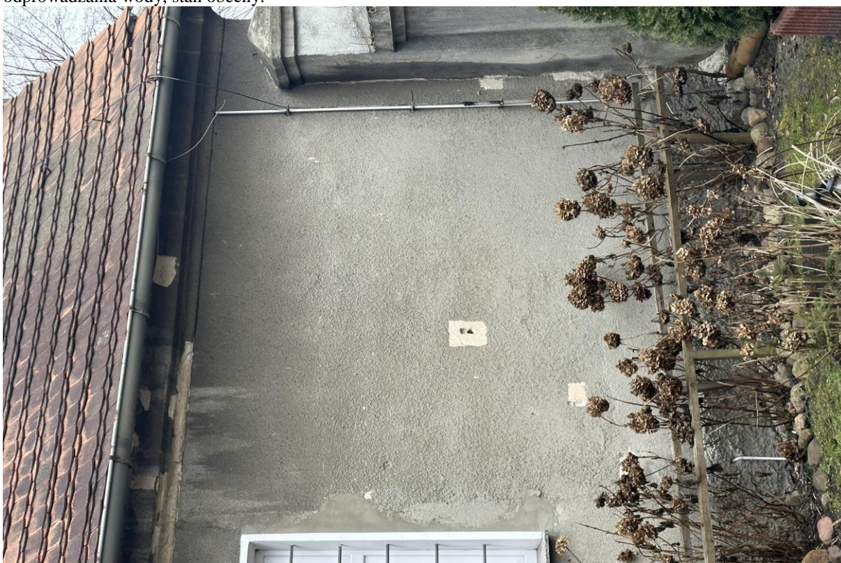
Fot. 6. Widok elewacji północnej budynku przy ul. Grabowskiej 1 w Mikstacie, fragment, widoczne odkrywki ze śladami oryginalnej polichromii w kolorze ugrowobeżowym, stan obecny.
