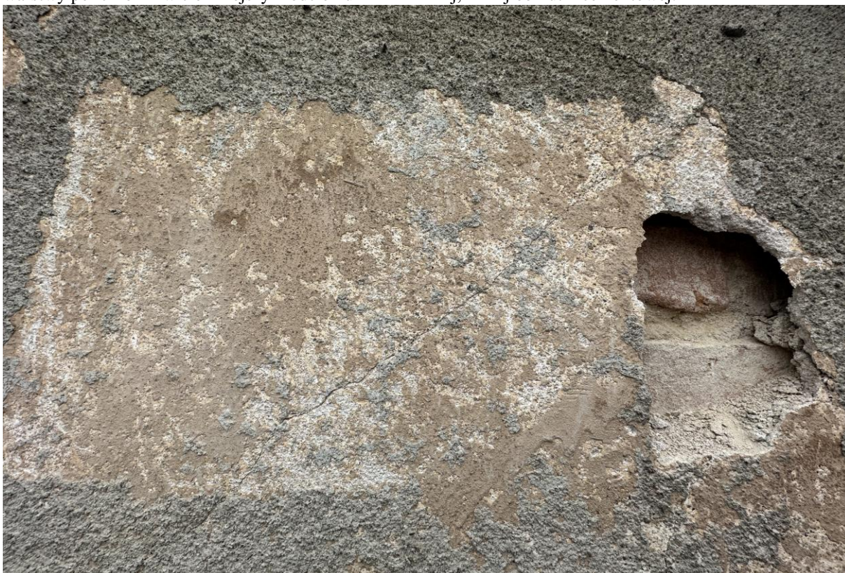
Fot. 16. Odkrywka naturalna nr 8 na fragmencie elewacji wschodniej w partii szczytowej, widoczna stratygrafia warstw z fragmentami oryginalnej ugrowo-beżowej warstwy polichromii oraz drugiej chronologicznej warstwy ugrowo-beżowej (ciemniejszej) i wtórnej, szarej obrzutki cementowej.
