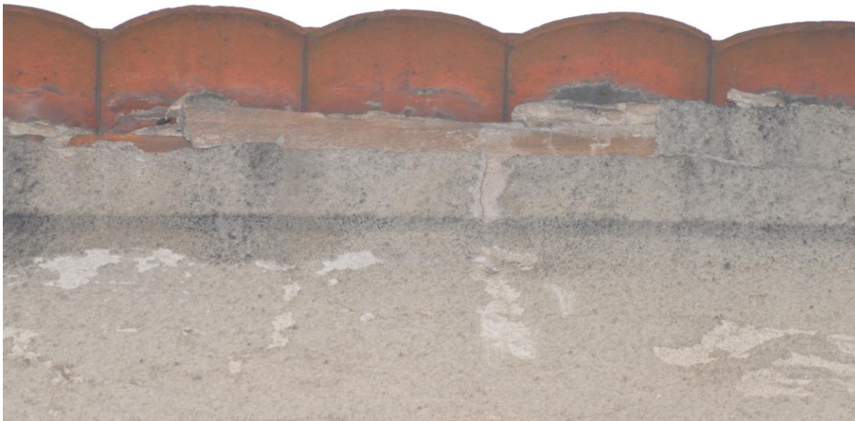
Fot. 17. Odkrywka naturalna nr 9 na fragmencie elewacji zachodniej w partii szczytowej, przygzymsowej, widoczna stratygrafia warstw z fragmentami oryginalnej ugrowo-beżowej warstwy polichromii i wtórnej, szarej obrzutki cementowej.
