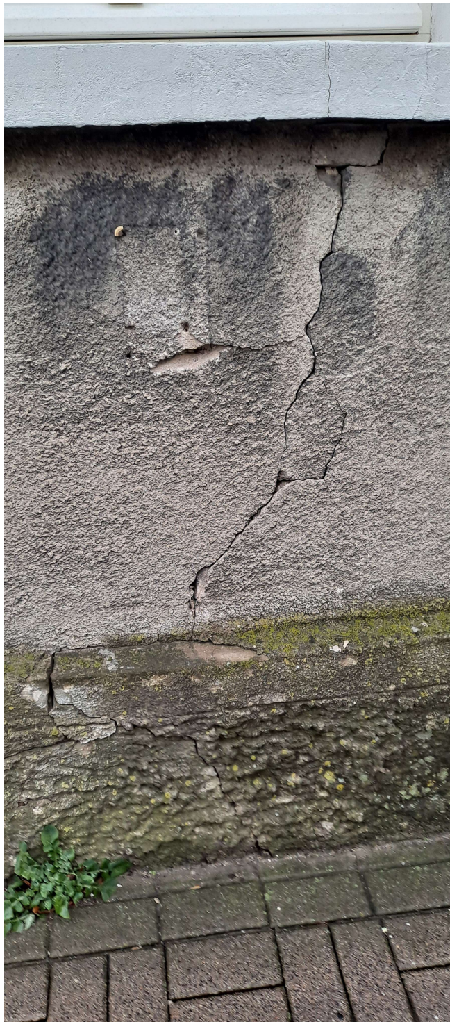
Nr 5. Widok ściany fundamentowe – widoczne pęknięcia
