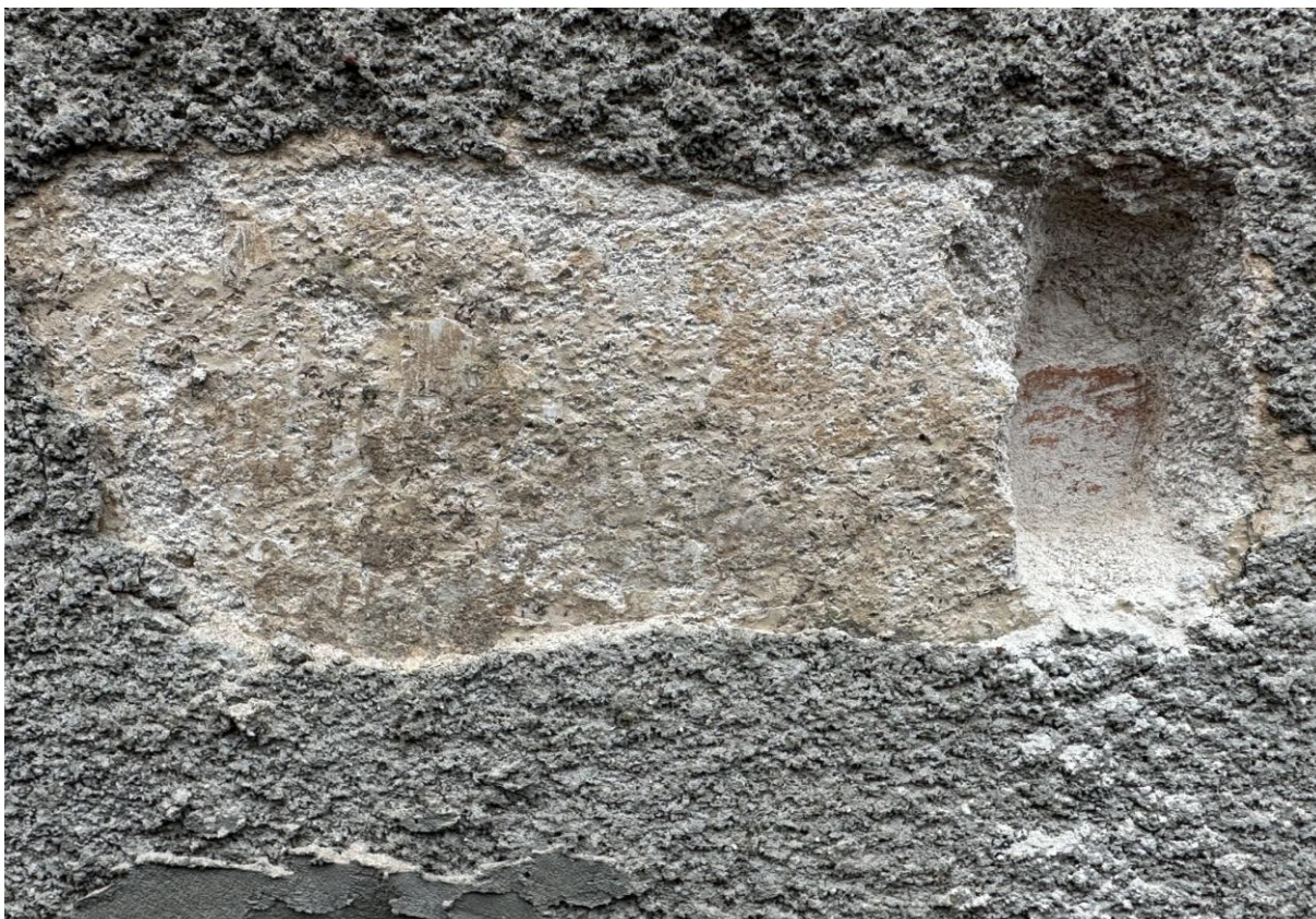
Fot. 9 Odkrywka nr 3 na fragmencie elewacji północnej, widoczna stratygrafia warstw z fragmentami oryginalnej, ugrowo-beżowej warstwy polichromii oraz wtórnej, szarej obrzutki cementowej.
