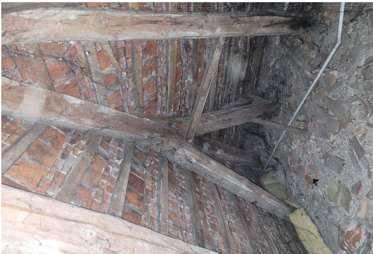
Fot. 7. Widok południowo-zachodniego fragmentu więźby dachowej plebani (część naczółkowa dachu, widoczne zniszczenia krokwi powstałe w wyniku oddziaływania wilgoci przez nieszczelności w poszyciu dachu, stan obecny.
