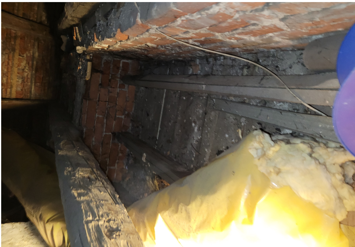
Fot. 11. Widok fragmentu więźby dachowej oraz uszkodzonych elementów wstępu ceglanego w partii ścian, widoczne zniszczenia powstałe w wyniku oddziaływania wilgoci przez duże nieszczelności w dachu, stan obecny.
