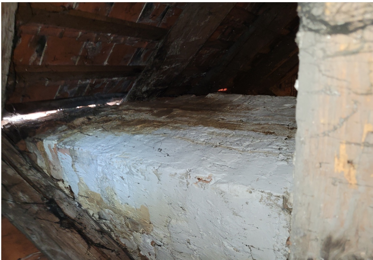
Fot. 9 Widok fragmentu więźby dachowej i poszycia dachu w partii przykominowej, widoczne zniszczenia powstałe w wyniku zalania przez duże nieszczelności w dachu, stan obecny.
