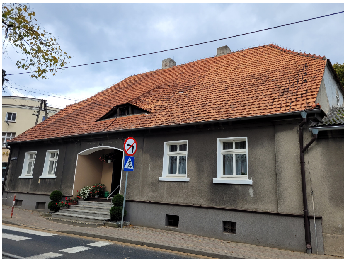
Fot. 1. Widok elewacji południowej plebani przy ul. Grabowskiej 1 w Mikstacie, widoczny, zapadnięty południowo-zachodni narożnik dachu, stan obecny.
