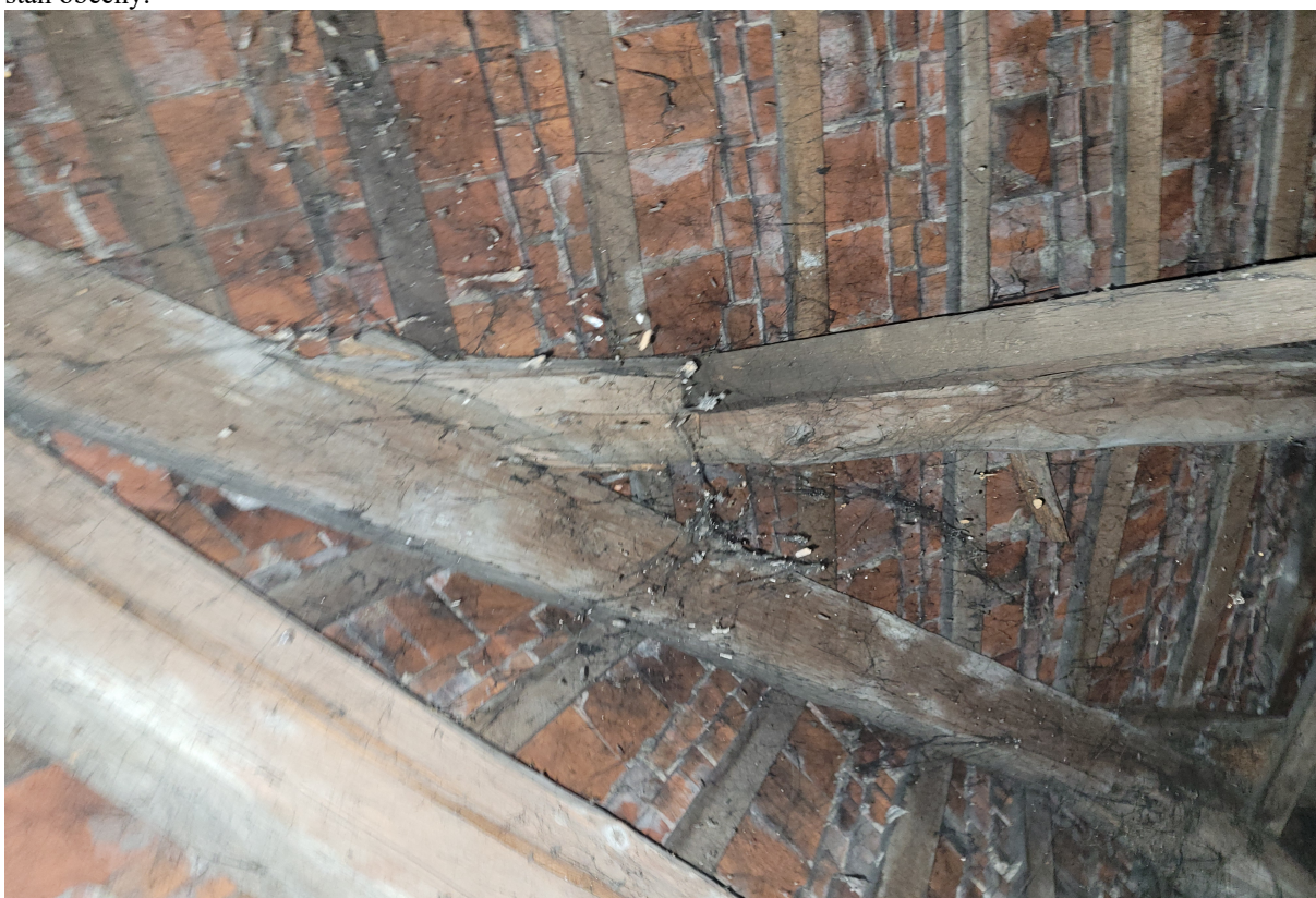
Fot. 8. Widok południowo-zachodniego fragmentu więźby dachowej plebani (część naczółkowa dachu, widoczne zniszczenia krokwi powstałe w wyniku oddziaływania wilgoci przez nieszczelności w poszyciu dachu, fragment), stan obecny.
