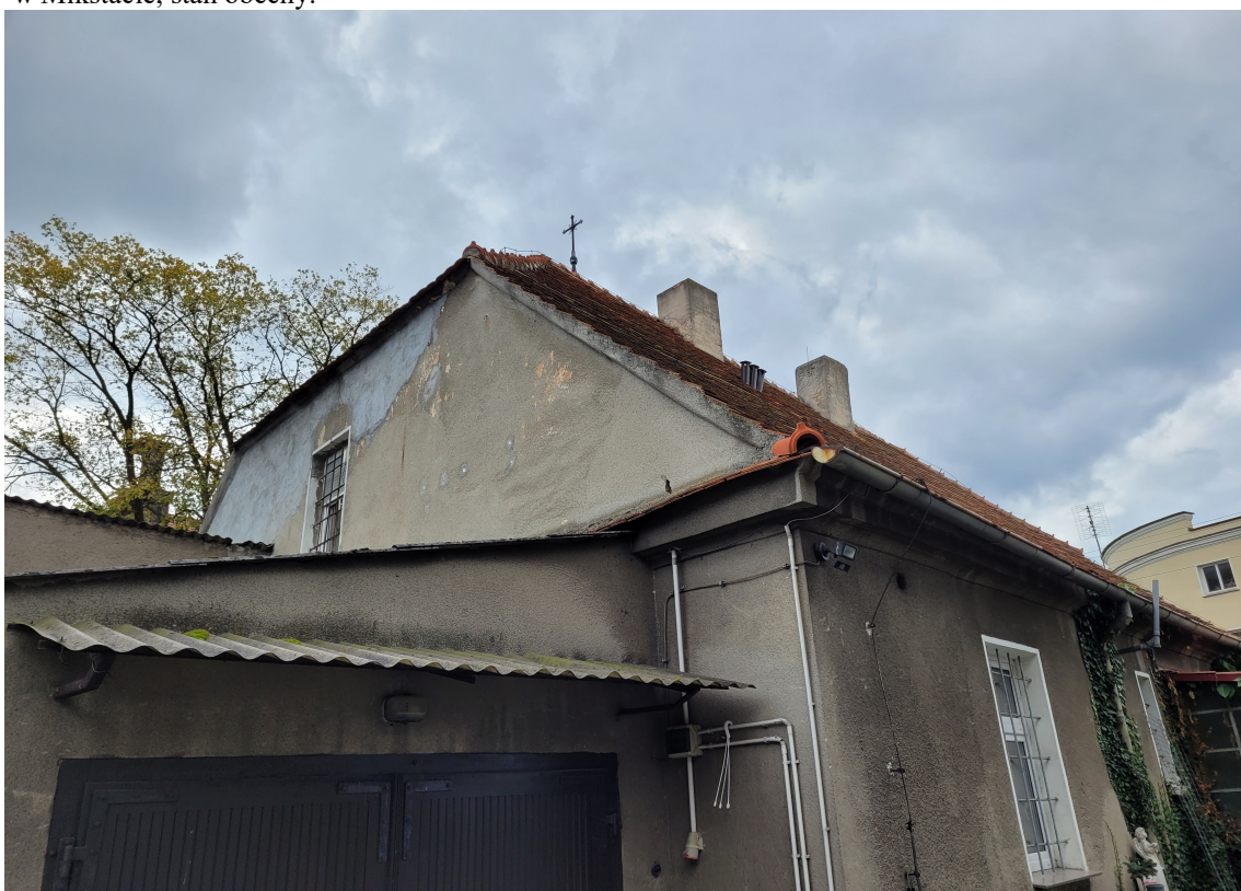
Fot. 6. Widok budynku plebani przy ul. Grabowskiej 1 w Mikstacie od strony północno-wschodniej, widoczne naprawy zniszczonego tynku w partii ściany szczytowej wskutek wadliwego systemu odprowadzania wody, stan obecny.
