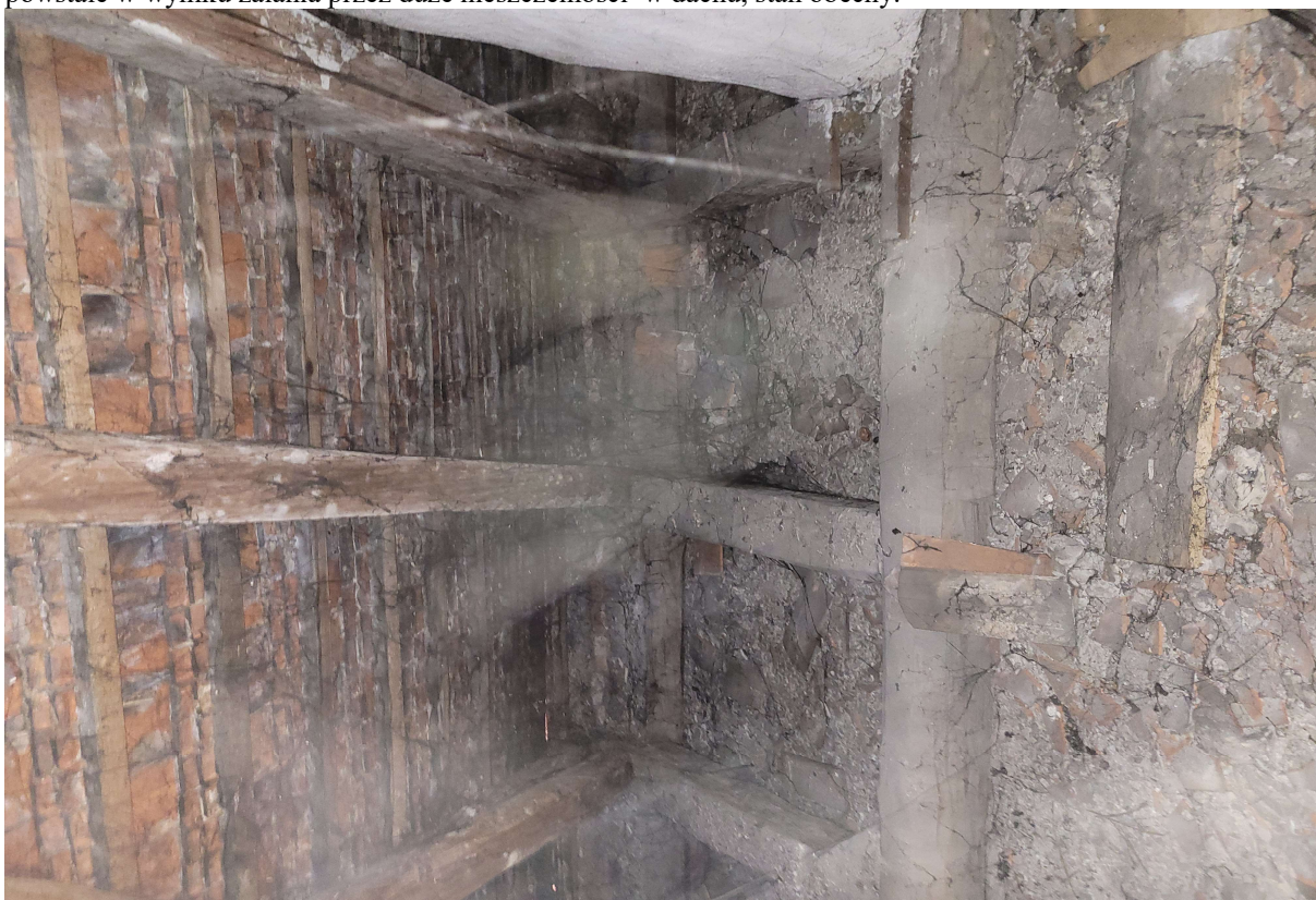
Fot. 10. Widok fragmentu więźby dachowej plebani, widoczne zabrudzenia i zniszczenia powstałe w wyniku oddziaływania wilgoci przez nieszczelności w poszyciu dachu, stan obecny.
