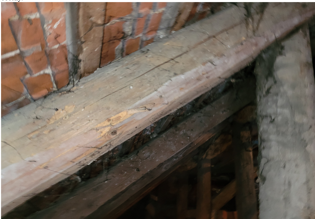
Fot. 12. Widok fragmentu więźby dachowej (krokwie), stan obecny.
