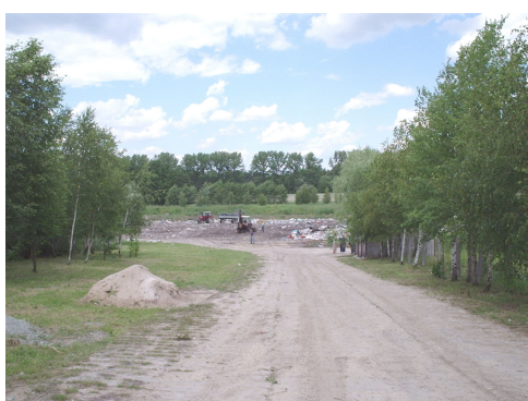
Wewnętrzna droga dojazdowa [Zdjęcia własne Expert s.c.]
