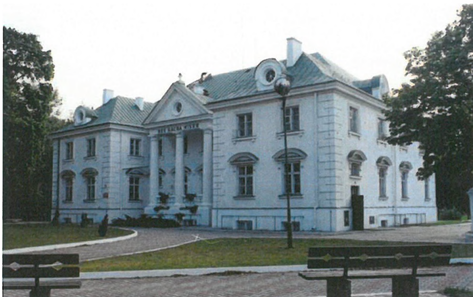
Fot. 1 Elewacja frontowa (wschodnia) pałacu w Gościeradowie
