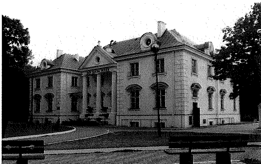
Fot. 1 Elewacja frontowa (wschodnia) pałacu w Gościeradowie
