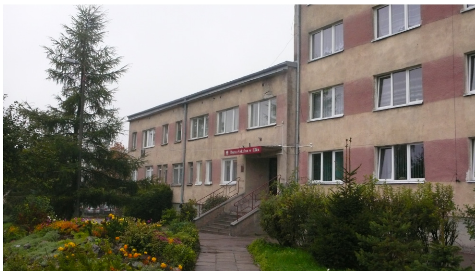
Rys. 16. Widok na wejście do bursy i budynek 2 kondygnacyjny (część mieszkalna nauczycieli)
