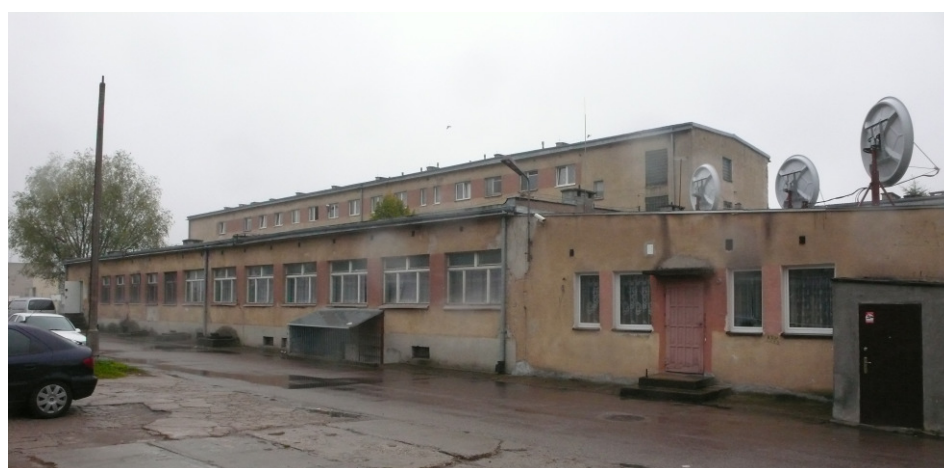
Rys. 19. Widok od strony północnej na budynek kuchni, stołówki i wynajmowanych pomieszczeń technicznych
