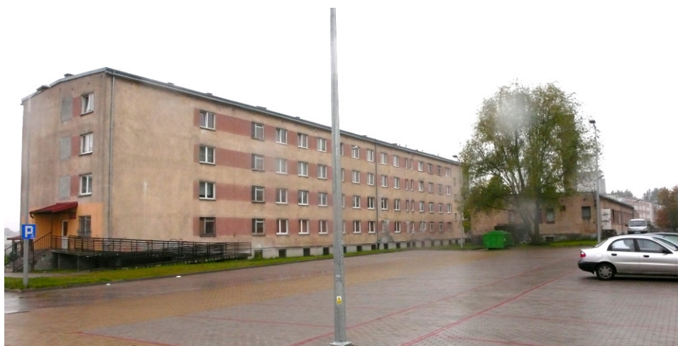
Rys. 18. Widok budynku mieszkalno - hotelowego 4 kondygnacyjnego
