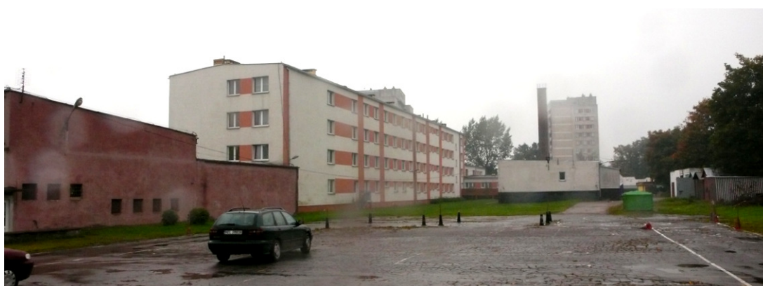
Rys. 11. Widok od strony wschodniej na budynki bursy nr II - 5A
