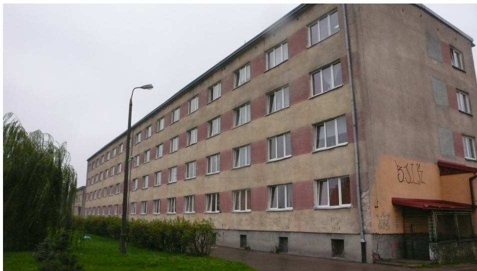
Rys. 17. Widok budynku bursy nr I z kierunku południowo – wschodniego
