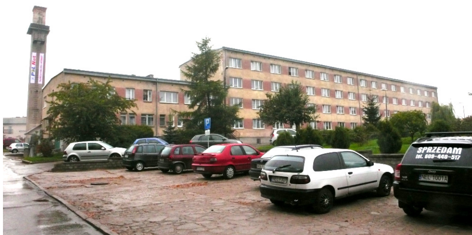
Rys. 15. Widok bursy nr I od strony wjazdu Sikorskiego 7A
