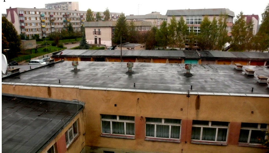
Rys. 29. Widok wywiewników na dachu stołówki i kuchni - budynek 7A
