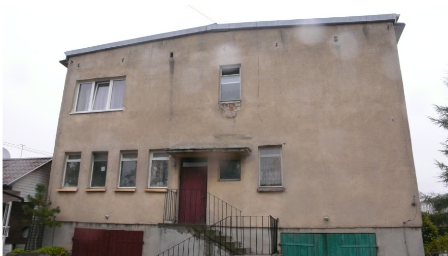
Rys. 20. Widok od strony zachodniej wejścia do budynku mieszkalnego 2 kondygnacyjnego - mieszkania nauczycieli
