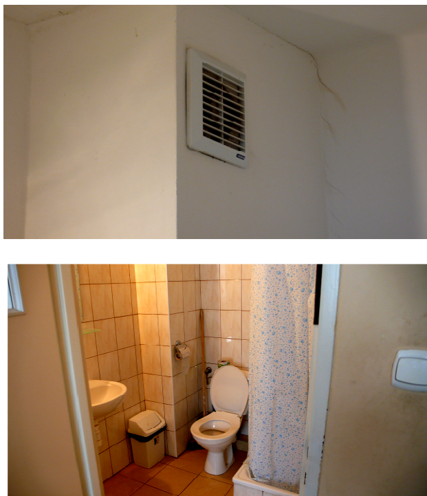
Rys. 26. Widok kratki wywiewnej i węzła sanitarnego.
