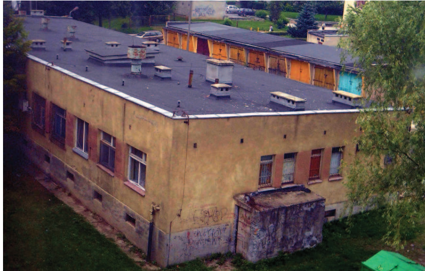
Rys. 2. Widok budynku kuchni od strony południowo-wschodniej
