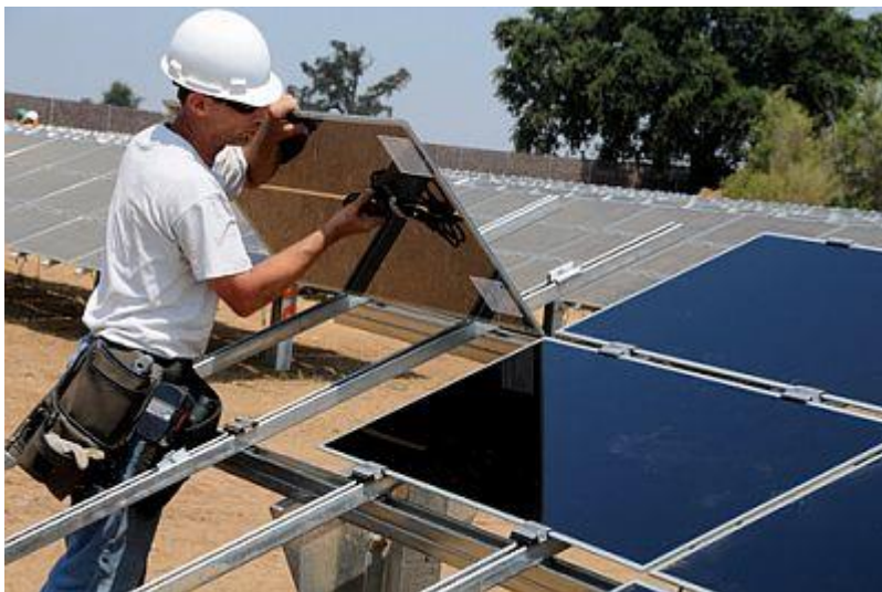
Ryc. 9. Montaż modułów na stelażach – przykład
