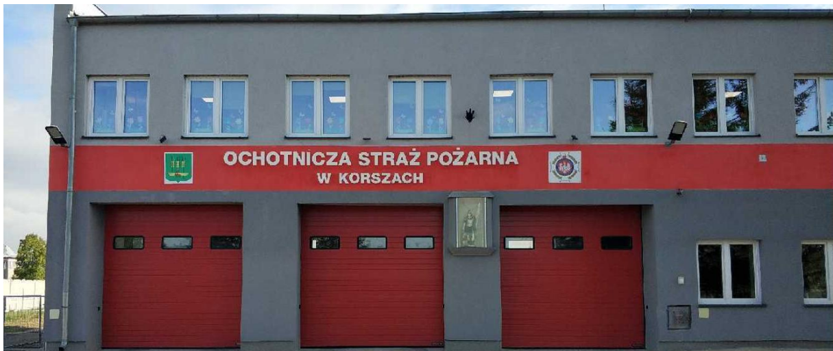
Budynek Remizy OSP w Korszach
