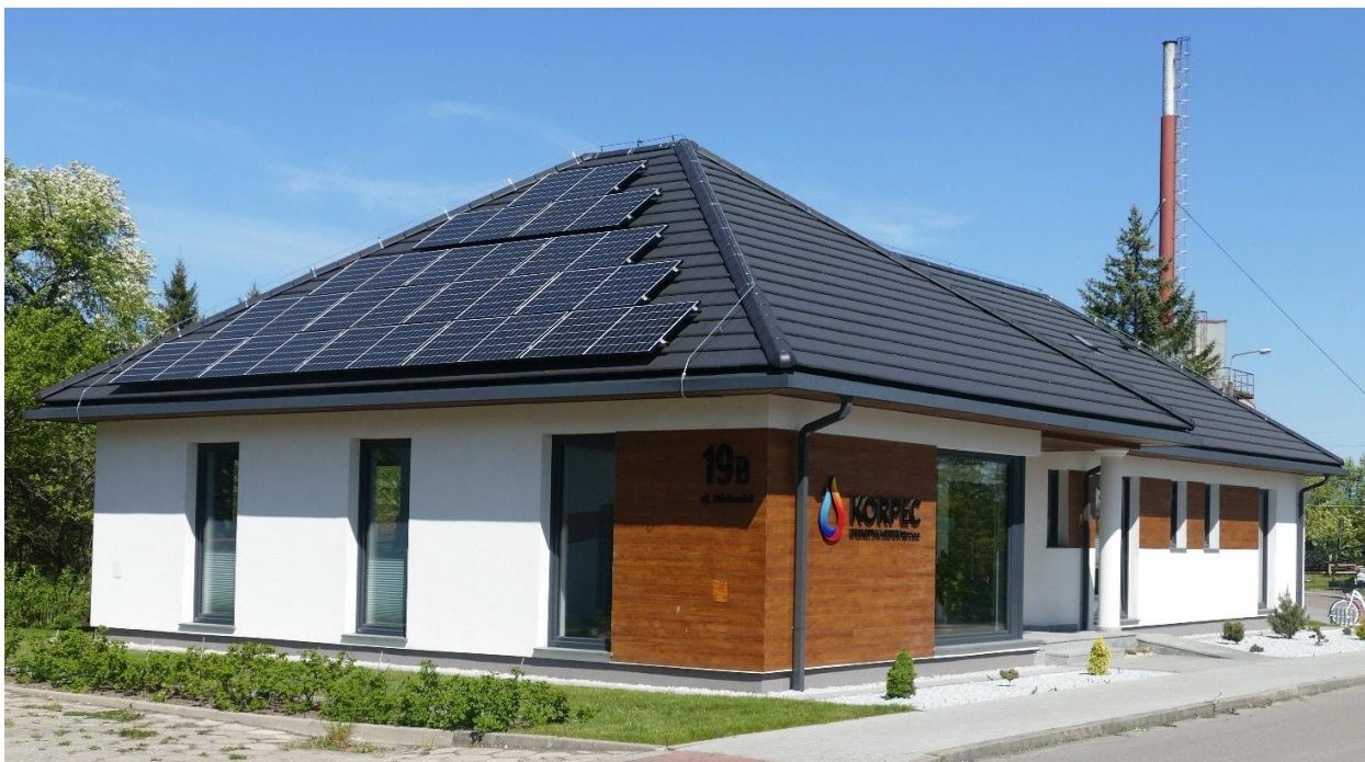
Budynek biurowo-administracyjny Spółki „Korpec” fot. własna
