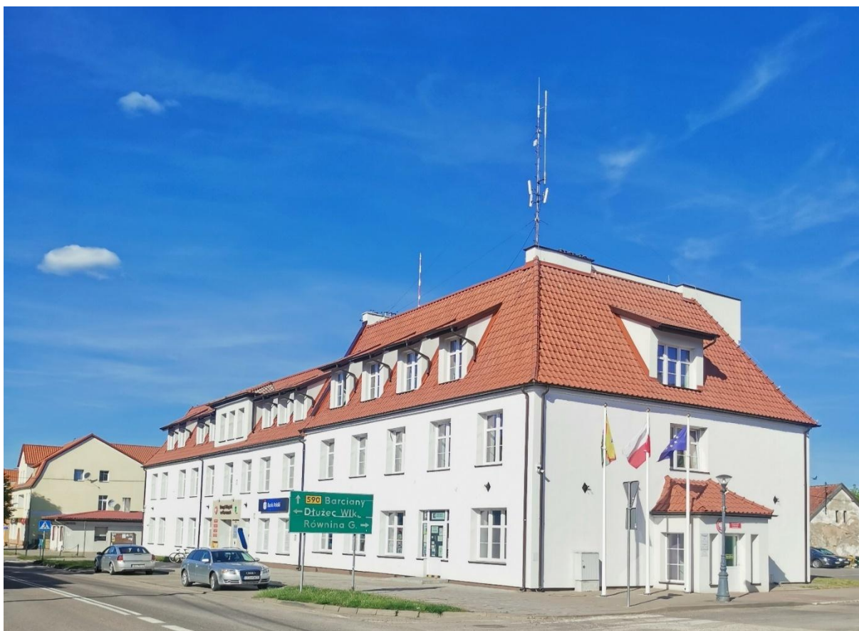
Budynek Urzędu Miejskiego
