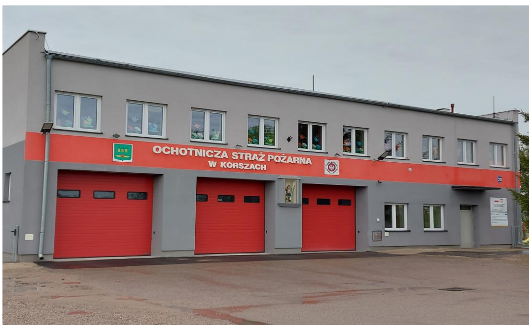
Budynek remizy OSP
