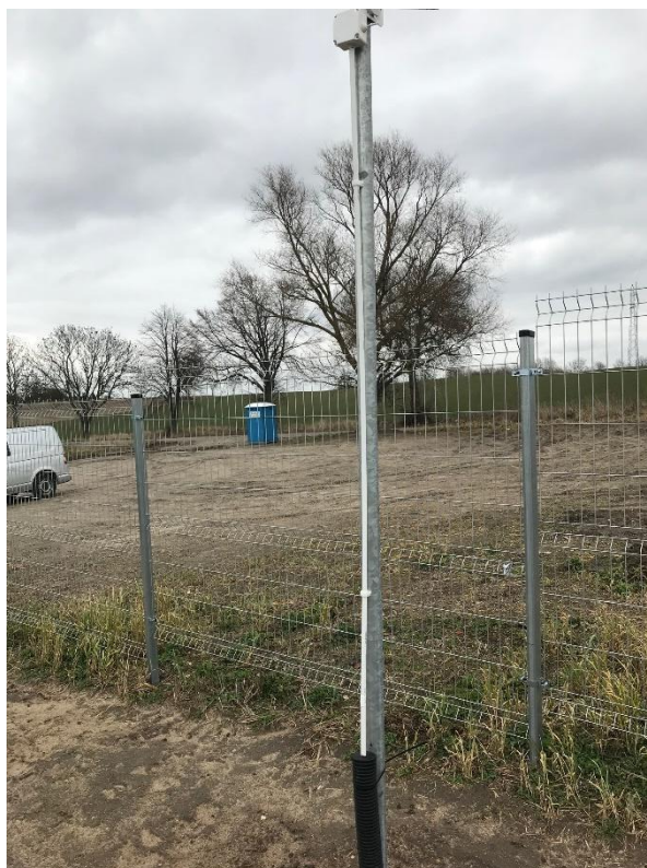
Ryc. nr 14 Przykładowe ogrodzenie farmy fotowoltaicznej
