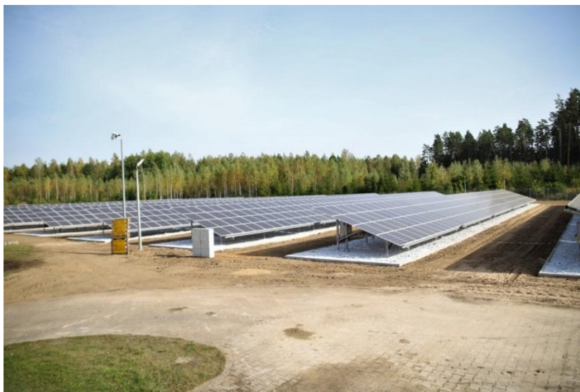
Ryc. nr 24 Przykładowe wyścielanie grysem powierzchni pod panelami bifacialnymi w miejscowości Przykopcze w gm. Ełk. Obszar pomiędzy obrzeżami grysowej wyściółki może zostać pokryty murawą. (źródło: https://investin.elk.pl/aktualnosci-wpis/4576/energia-sloneczna-zasila-stacje-uzdatniania-wody-dla-elku )
