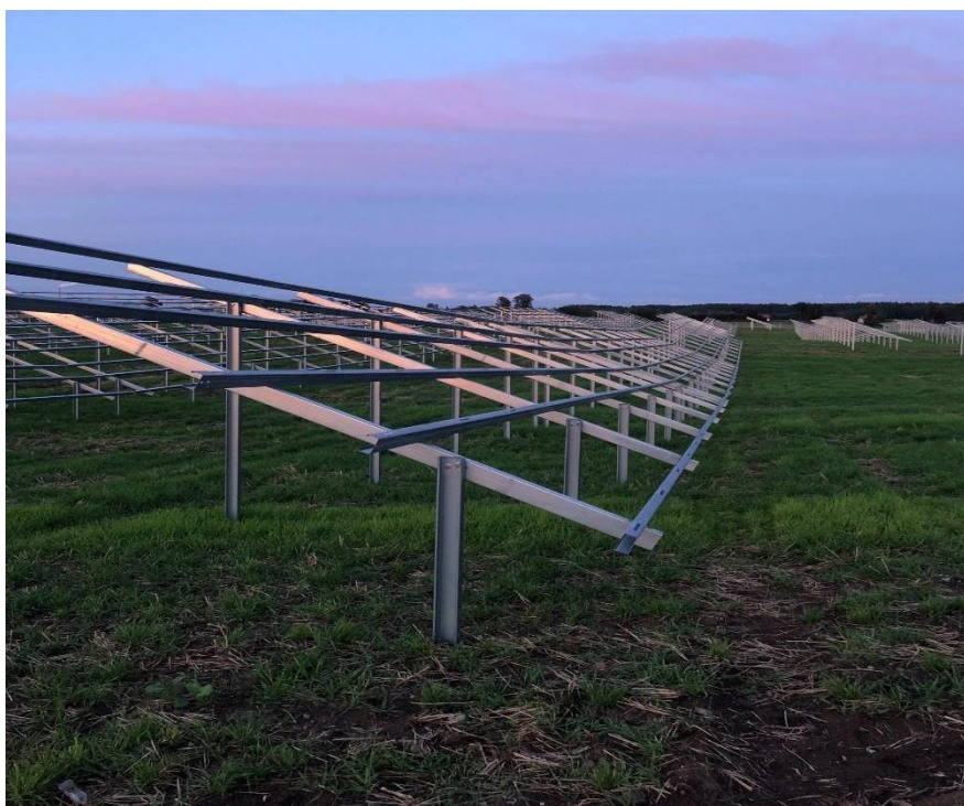
Ryc. nr 7 Przykładowe szkielety przed montażem paneli
