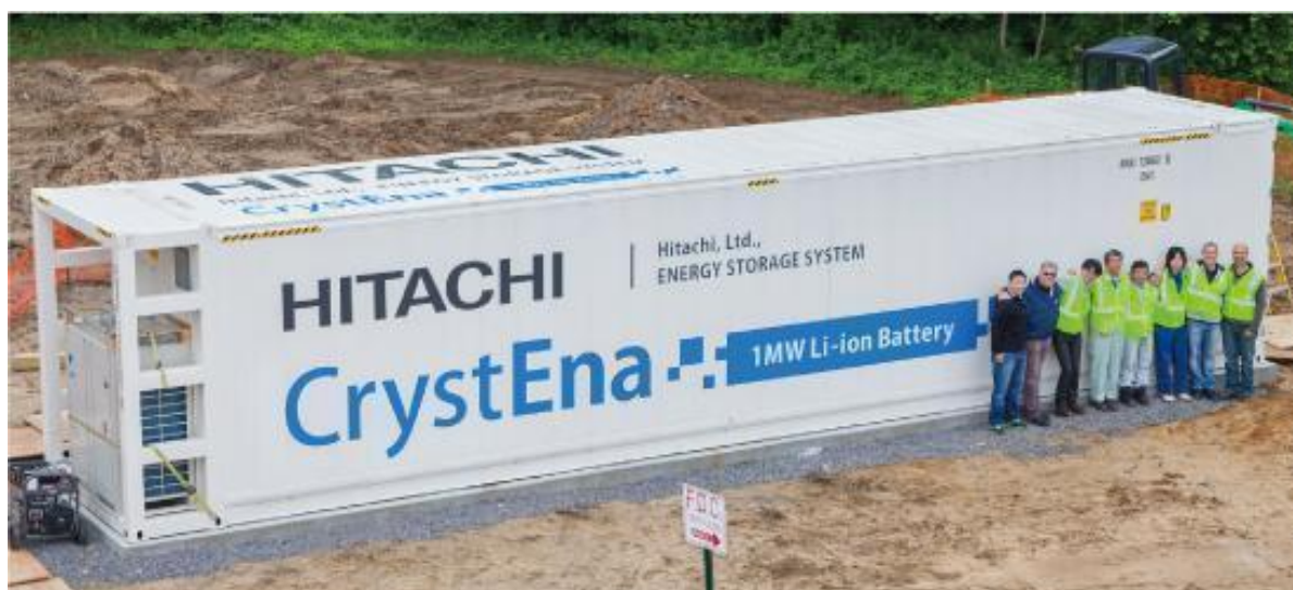
Ryc. nr 10 Przykładowy kontenerowy magazyn energii o pojemności 1 MW, Hitachi „CrystEna”. Inwestor planuje zastosowanie wtapiających się kolorów kontenera.
