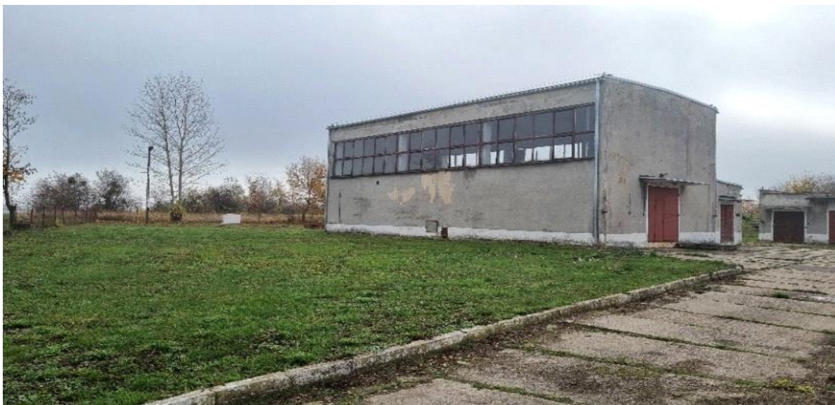
Budynek SUW Korsze
