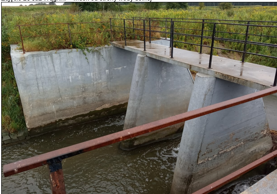
Zdjęcie 20 Jaz Wągniki – widok od strony wody dolnej
