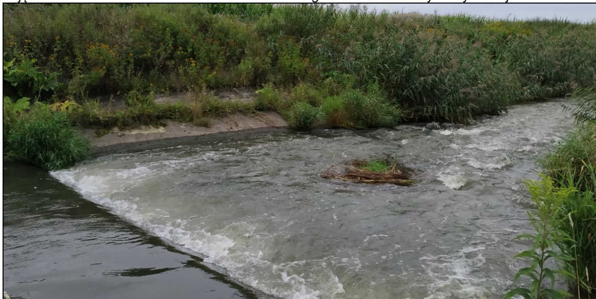
Zdjęcie 17 Jaz Warniki – widok na umocnienia brzegowe i denne strony wody dolnej
