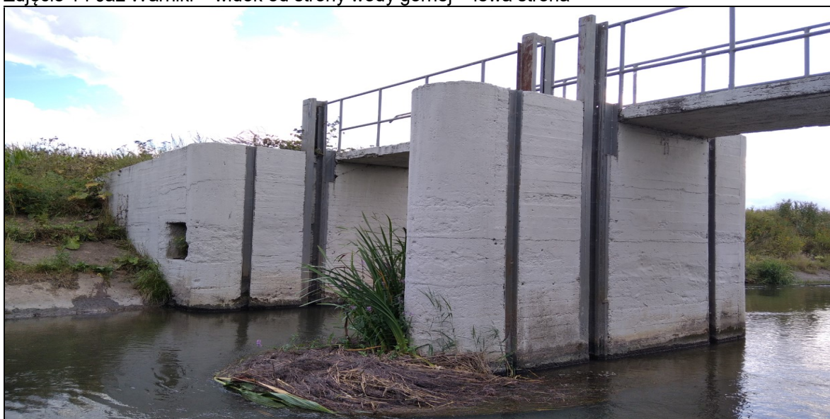
Zdjęcie 14 Jaz Warniki – widok od strony wody górnej – lewa strona
