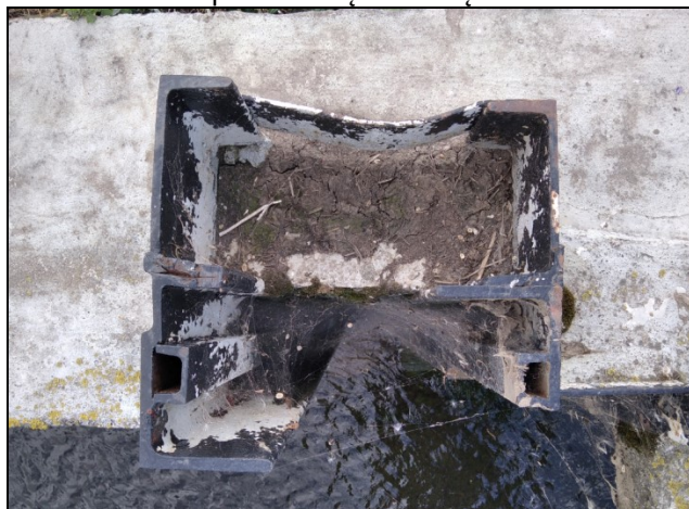
Zdjęcie 11 Jaz Dubliny – widok z góry na uciętą prowadnicę zamknięć
