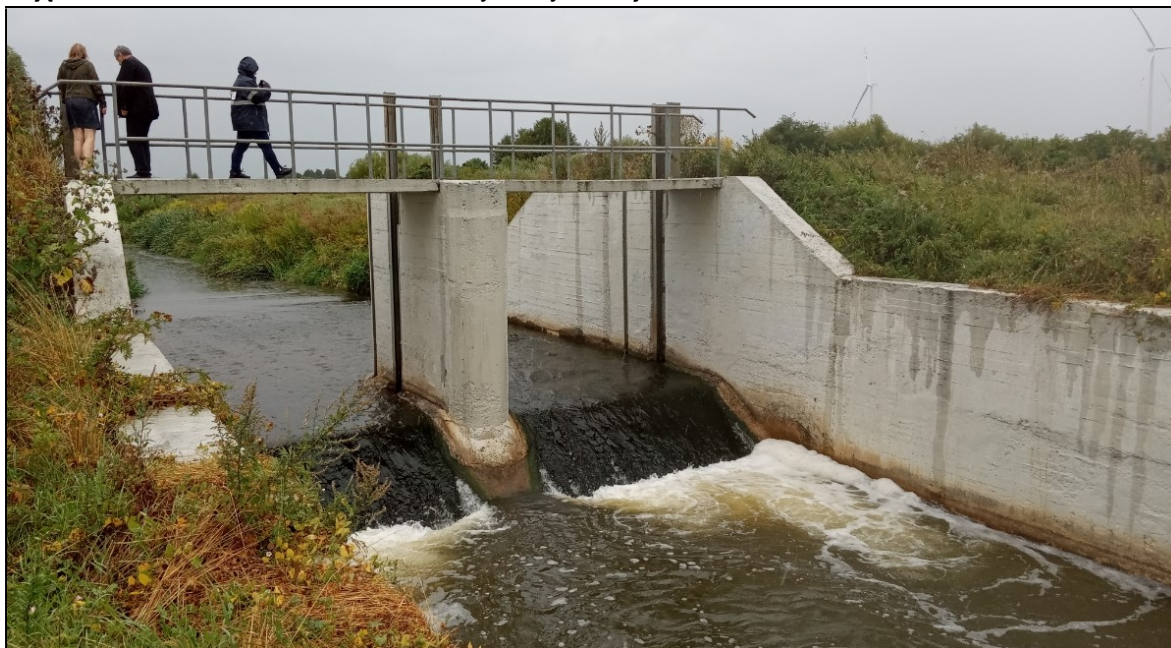
Zdjęcie 2 Jaz Banaszkowski – widok od strony wody dolnej
