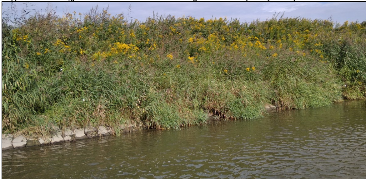
Zdjęcie 21 Jaz Wągniki – widok na umocnienia brzegowe od strony wody dolnej
