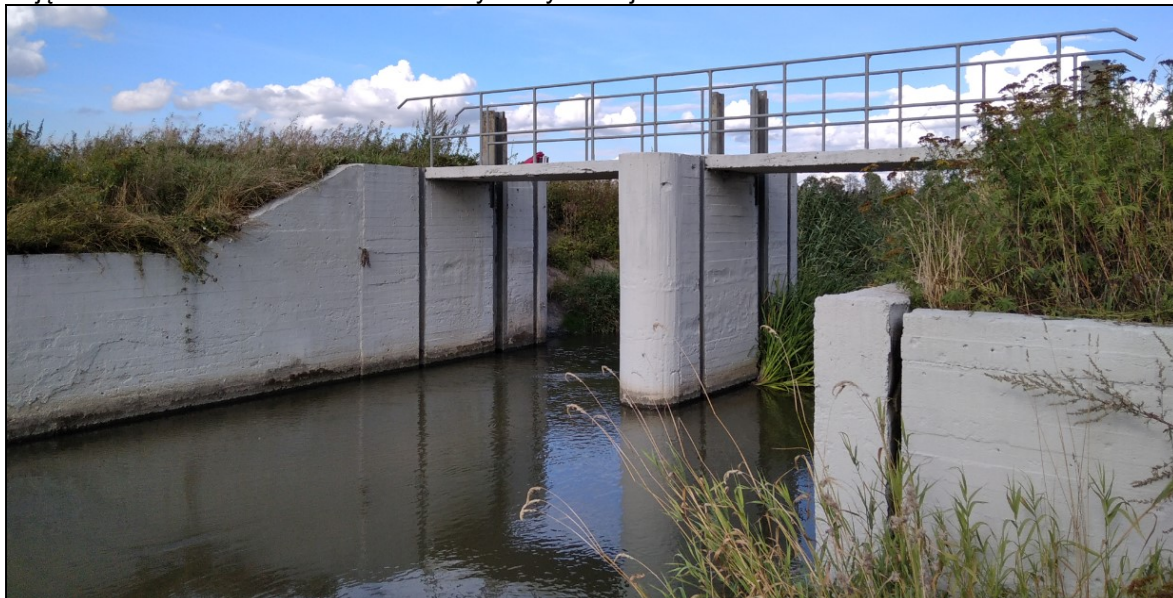
Zdjęcie 13 Jaz Warniki – widok od strony wody dolnej
