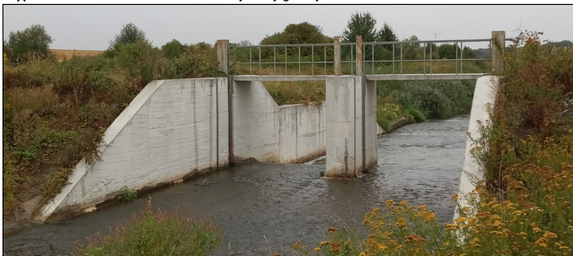
Zdjęcie 1 Jaz Banaszki – widok od strony wody górnej
