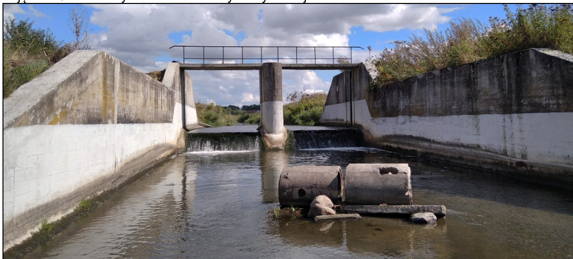
Zdjęcie 7 Jaz Dubliny – widok od strony wody dolnej
