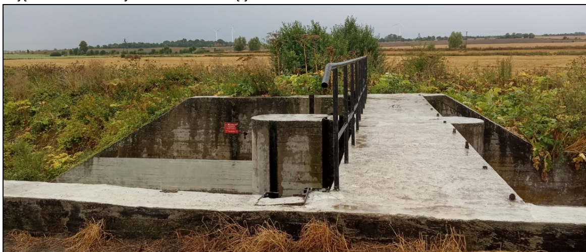
Zdjęcie 8 Jaz Dubliny – widok na kładkę jazu
