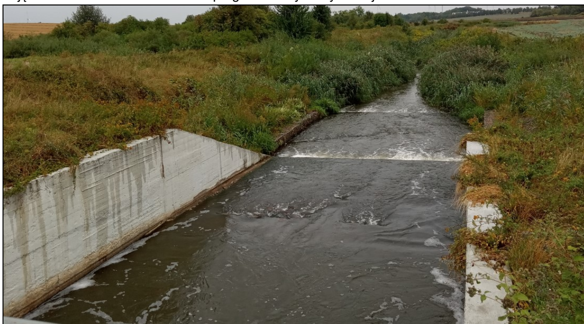
Zdjęcie 3 Jaz Banaszkowski – widok na progi od strony wody dolnej
