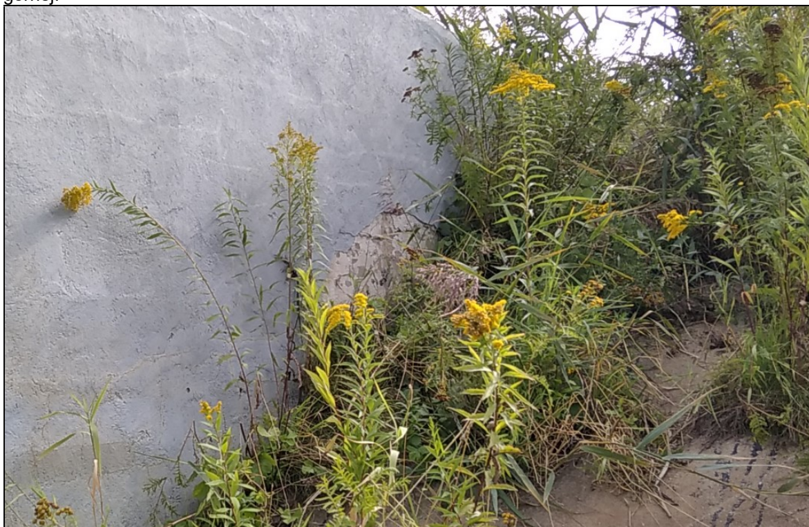
Zdjęcie 22 Jaz Wągniki – widok na lewe skrzydło jazu i umocnienia brzegowe od strony wody górnej.
