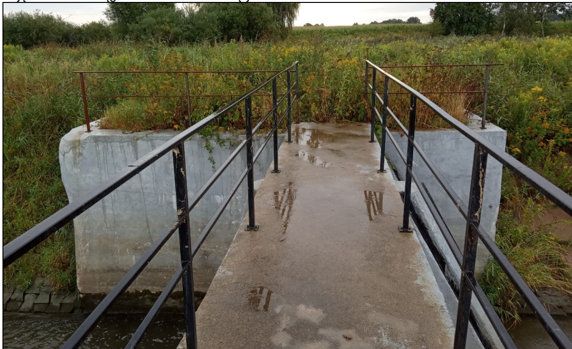
Zdjęcie 19 Jaz Wągniki – widok na kładkę jazu
