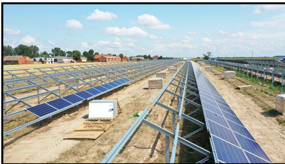
Zdjęcie 3 Konstrukcja wsporcza (farma słoneczna Ziemlin, gm. Krobia)
