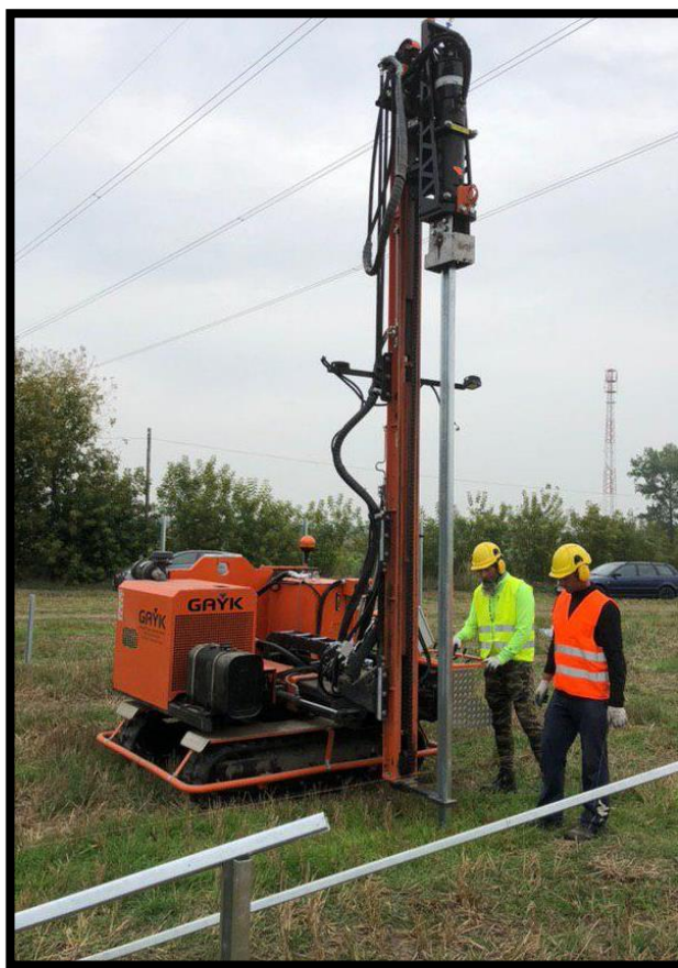
Zdjęcie 4 Montaż konstrukcji wsporczej (kafar)
