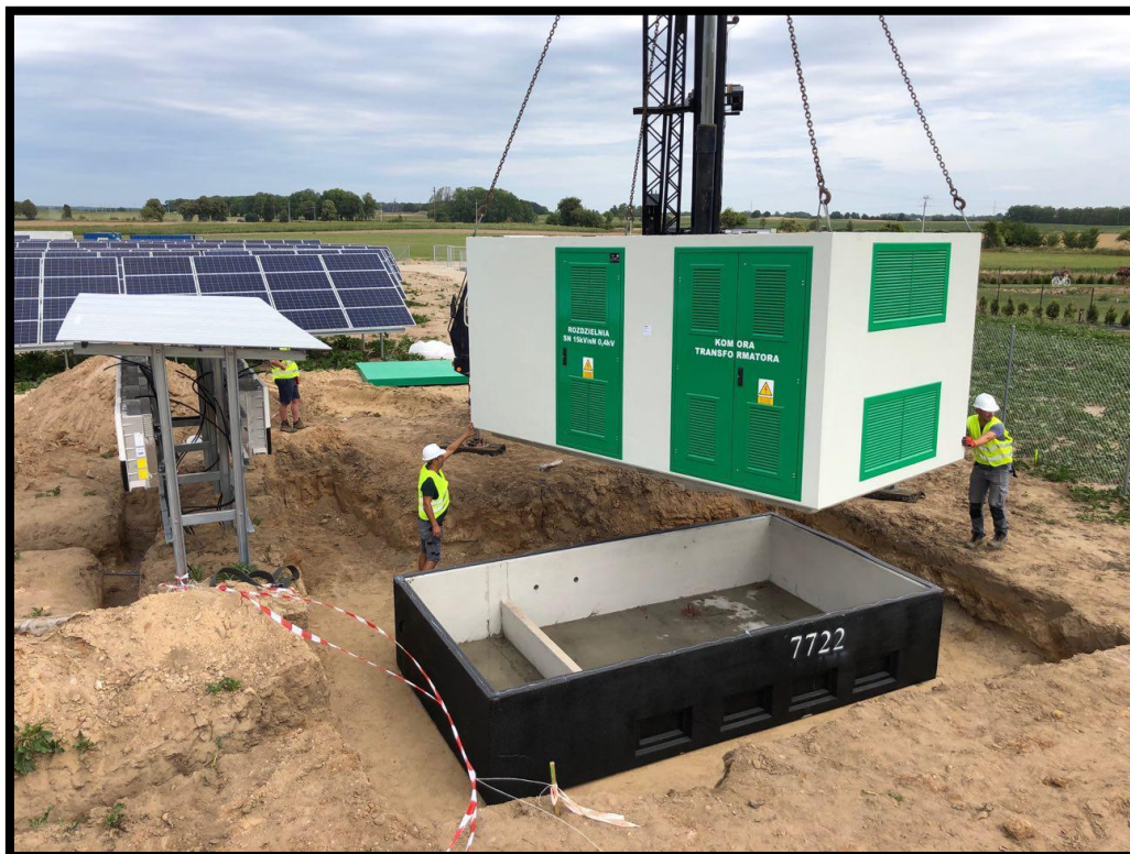
Zdjęcie 5 Posadowienie stacji transformatorowej
