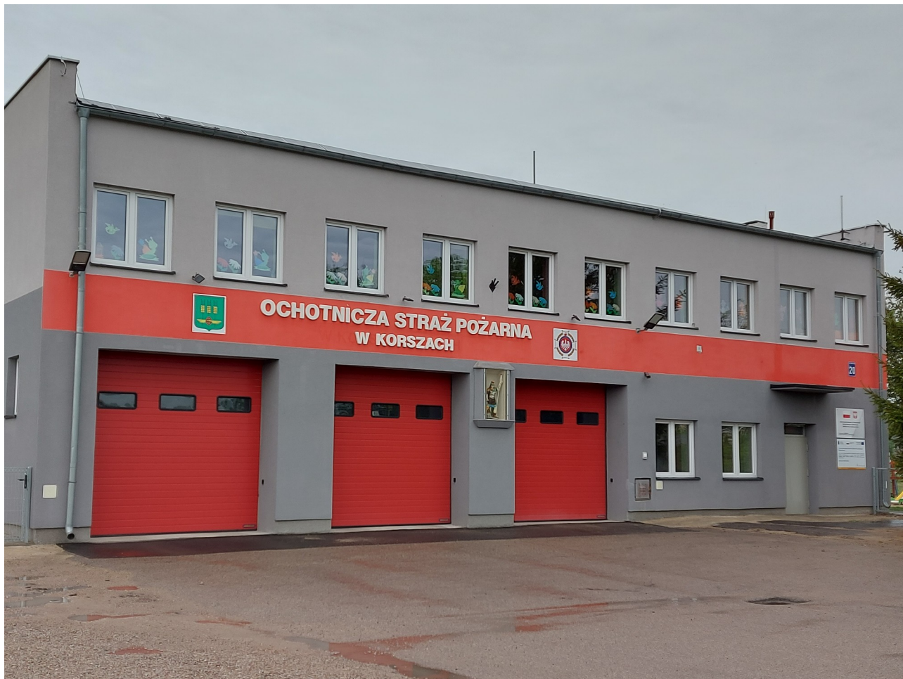
Budynek remizy w Korszach po termomodernizacji
