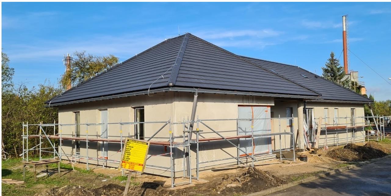
Nowo budowany obiekt administracyjno – biurowy.
