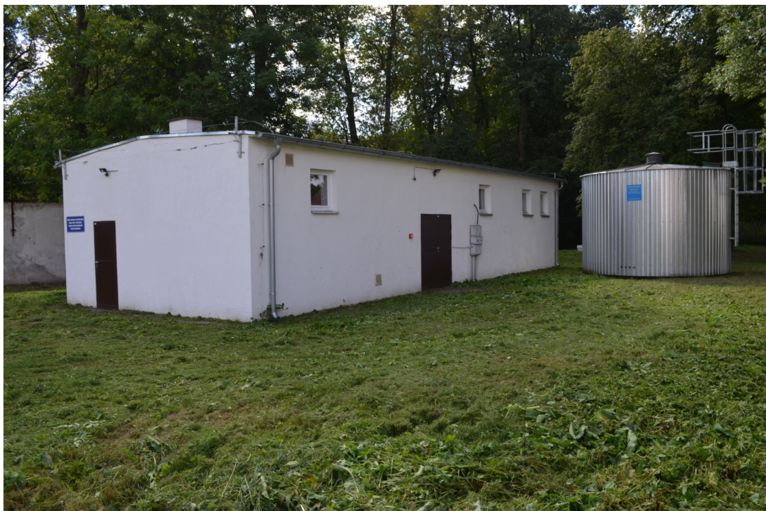
Zmodernizowany obiekt Stacji Uzdatniania Wody w Tołkinach.
