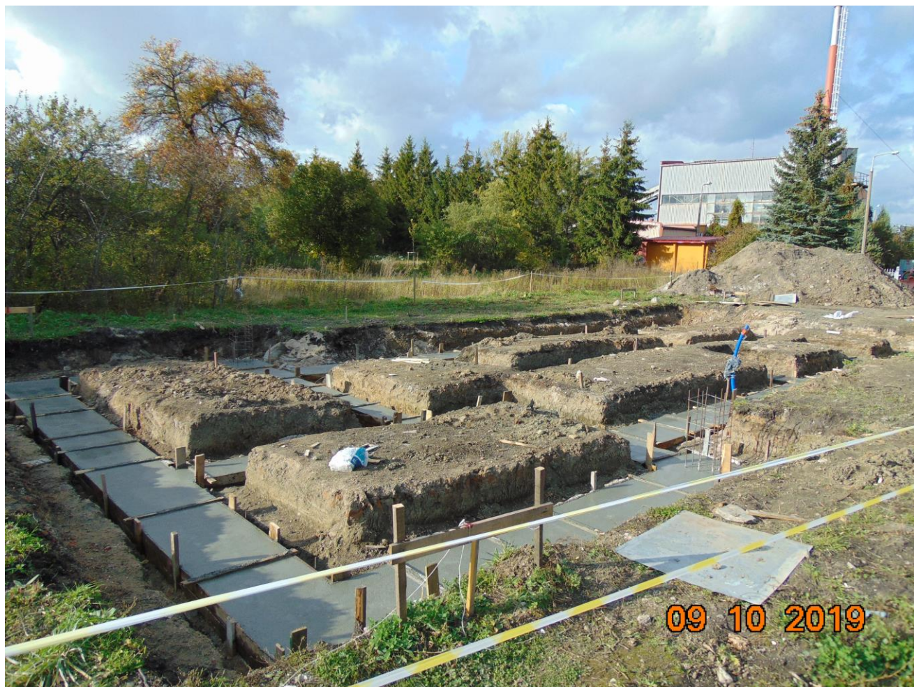
Początki budowy nowego budynku administracyjno-biurowego
