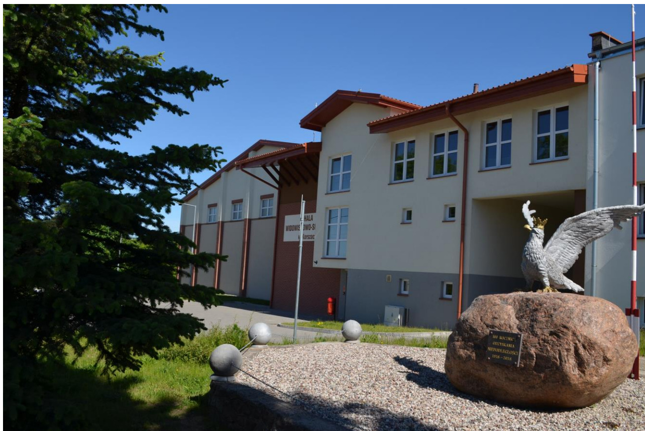
Budynek hali widowiskowo-sportowej w Korszach
