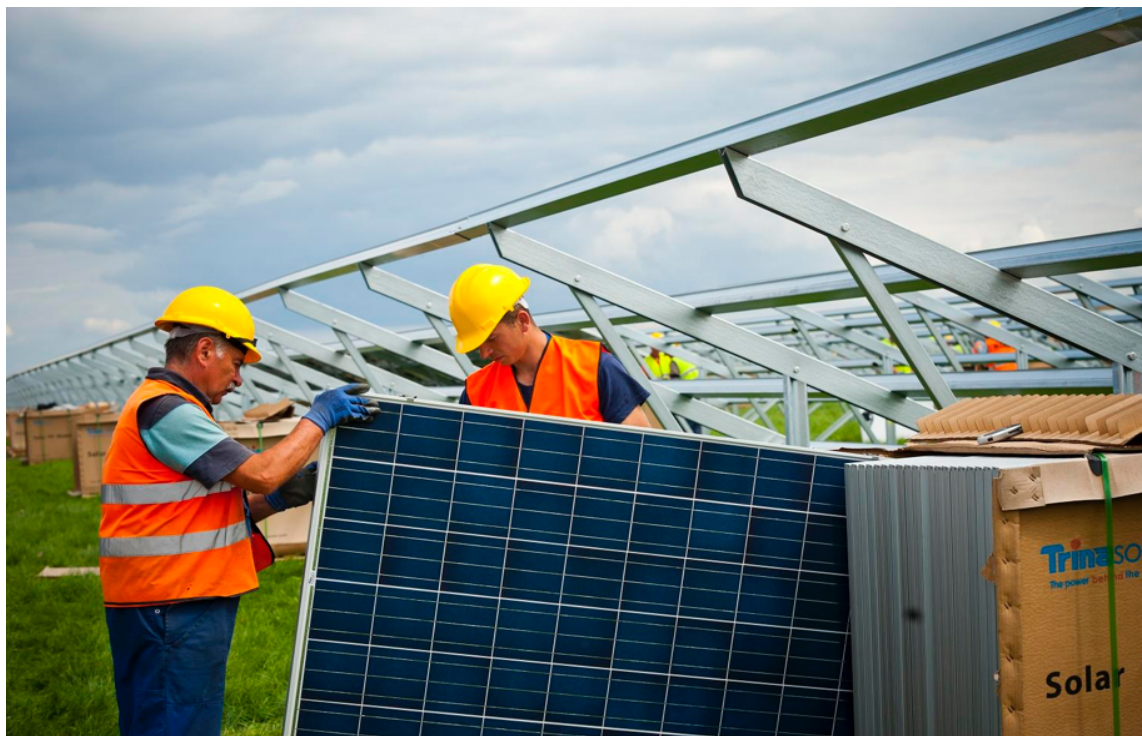
Fot. 3. Montaż konstrukcji stalowych i paneli fotowoltaicznych. Fotografia za Remor Solar.
