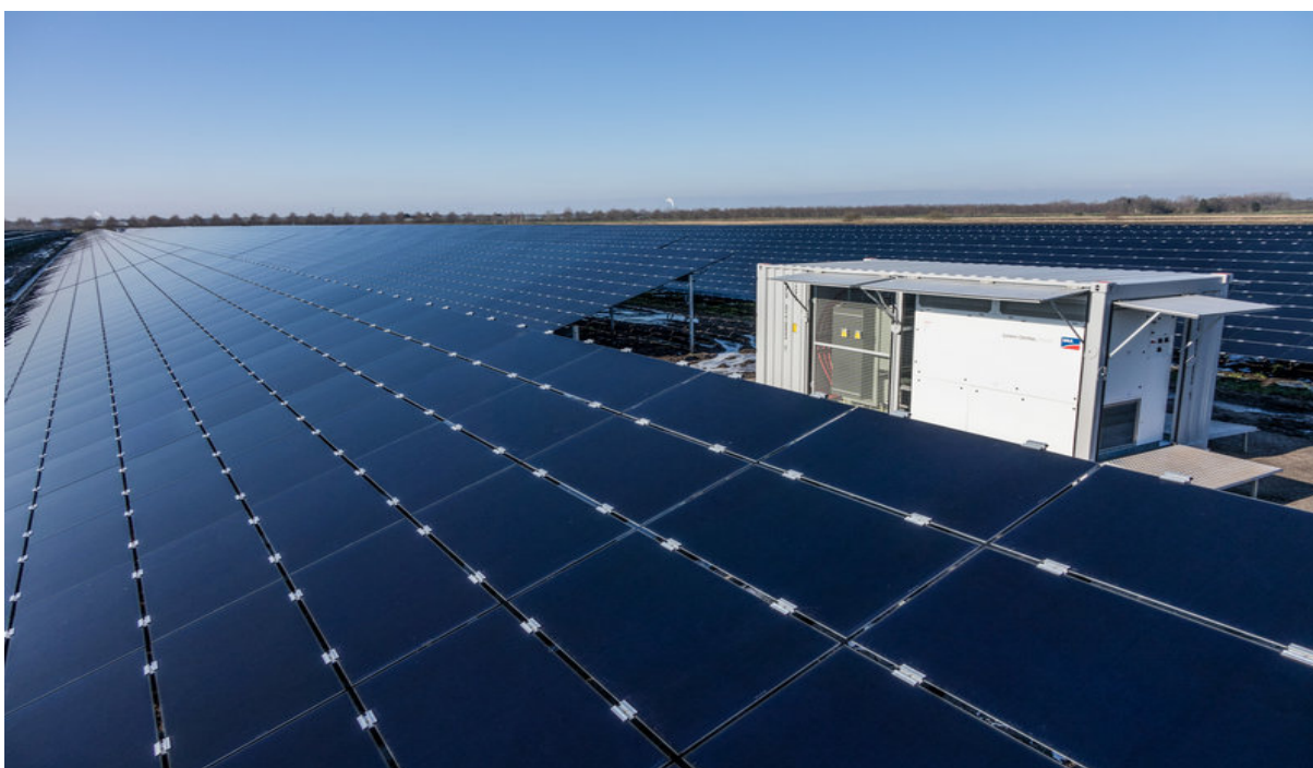
Fot. 8. Kontenerowa stacja wraz z automatyką. Zdjęcie www.belectric.com .
