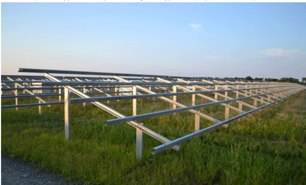
Fot. 2. Stalowa konstrukcja gotowa do montażu paneli fotowoltaicznych. Zdjęcie www.projekt-solartechnik.pl .
