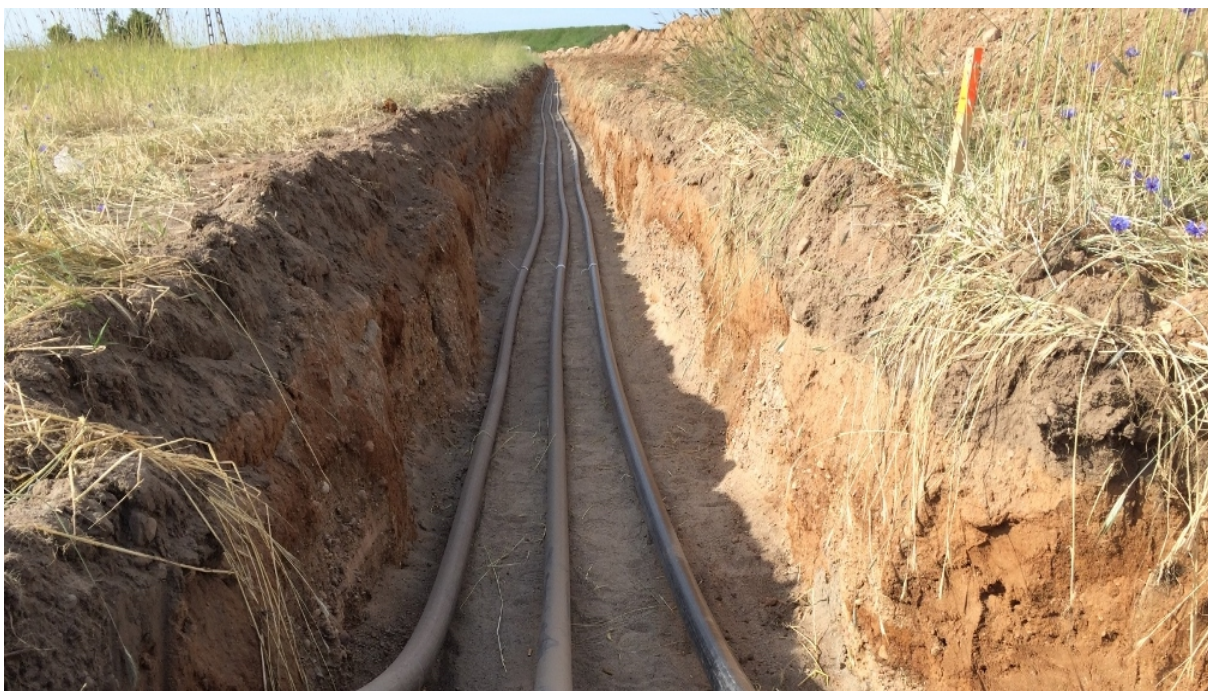
Fot. 4. Rów kablowy z ułożonymi przewodami. Zdjęcie www.elektromontazwschod.pl .
