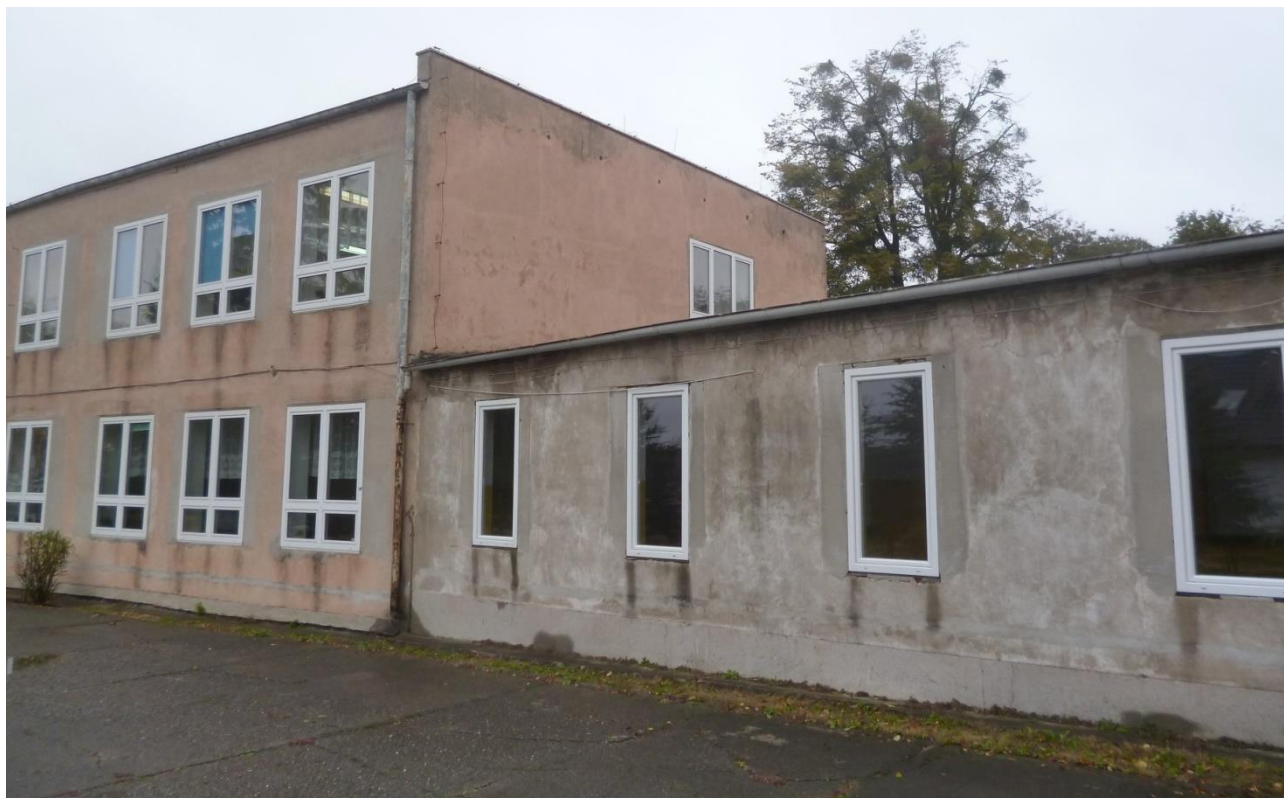
Foto: Szkoła Podstawowa w Korszach przed termomodernizacją.
