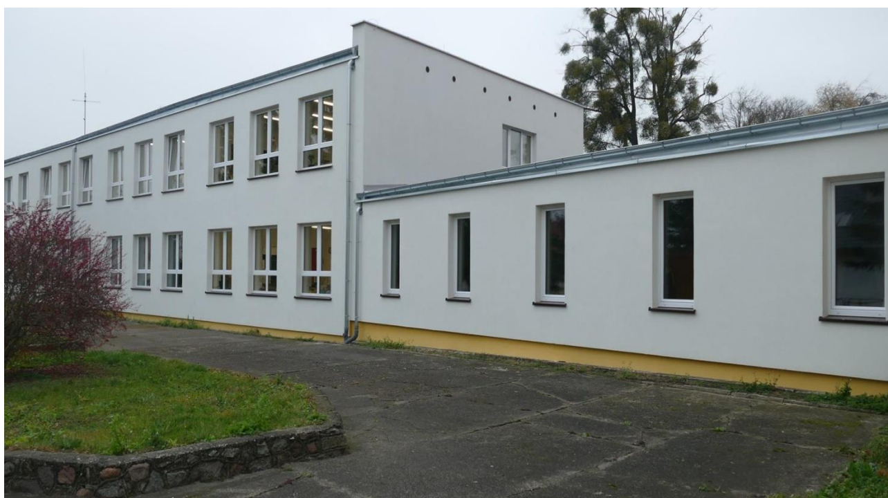
Foto: Szkoła Podstawowa w Korszach po termomodernizacji.
