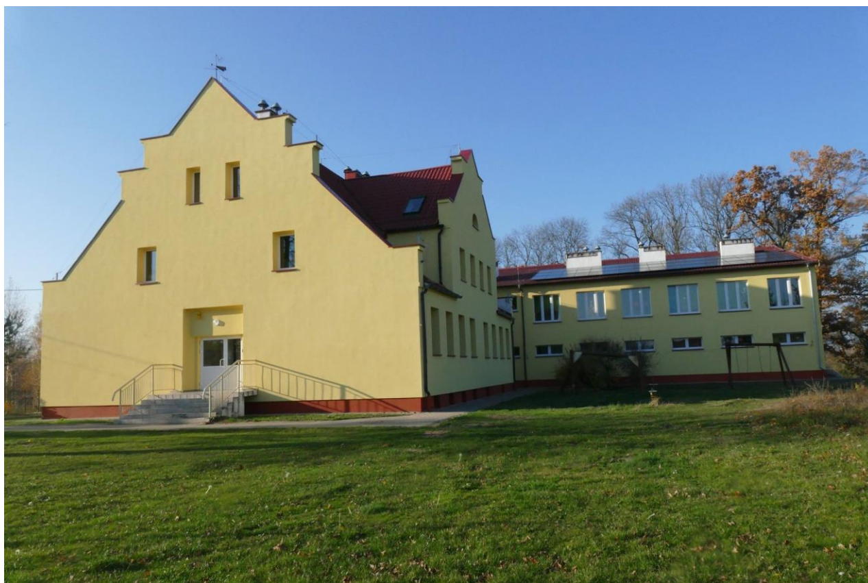
Foto: Szkoła Podstawowa w Łankiejmach po termomodernizacji.
