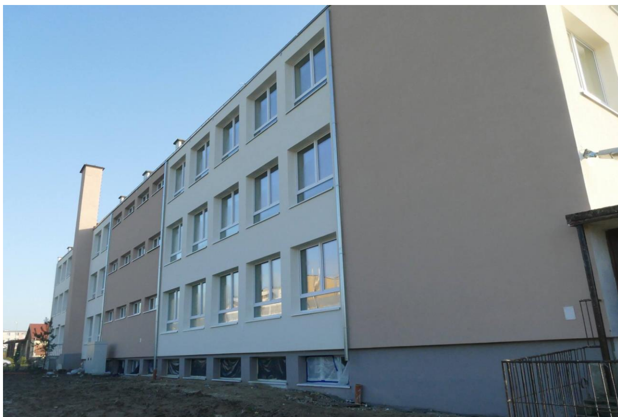
Foto: Szkoła Podstawowa w Garbnie po termomodernizacji.
