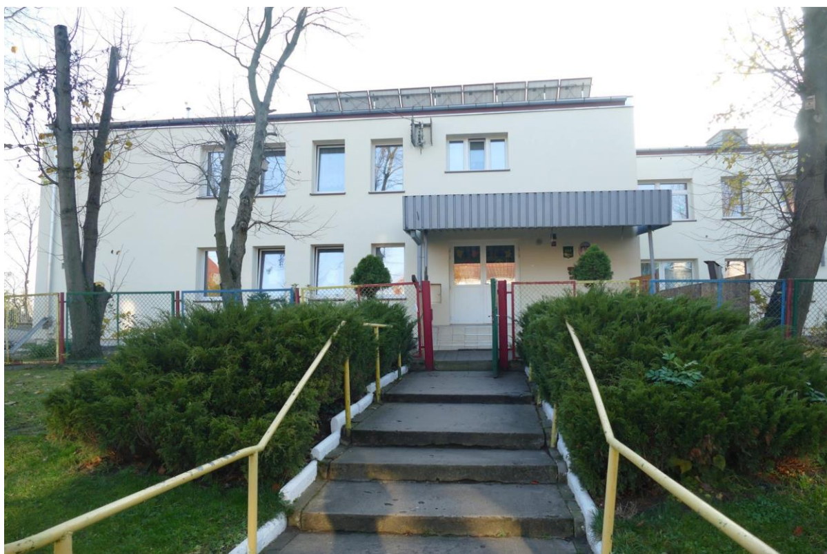
Foto: Przedszkole w Korszach po termomodernizacji.
