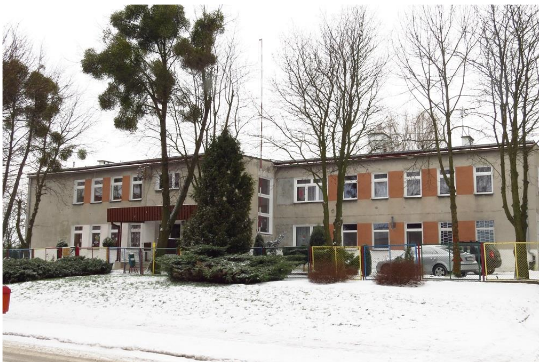
Fot. 1. Budynek przedszkola, widok od frontu (elewacja północna)
