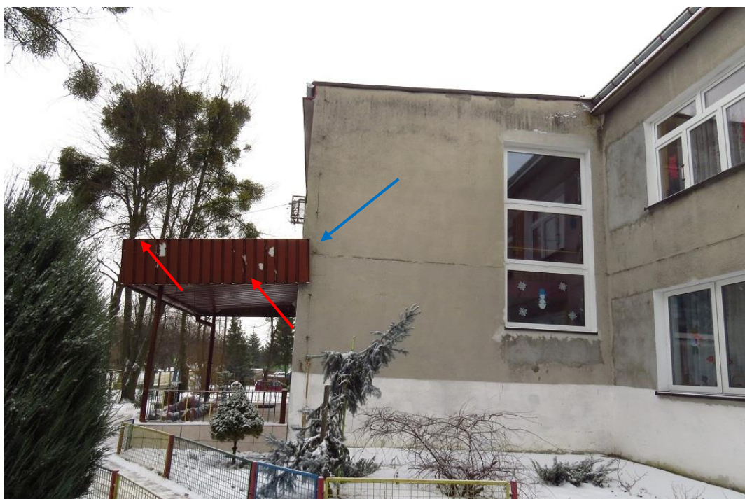
Fot. 5. Potencjalne kryjówki nietoperzy w obrębie zadaszenia nad wejściem.
