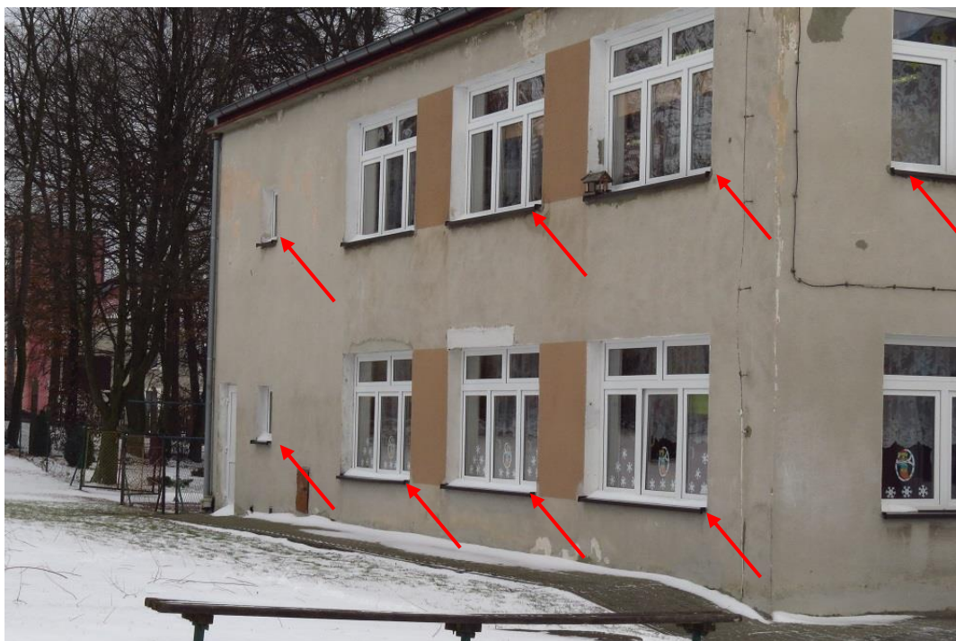
Fot. 8 Potencjalne kryjówki pod parapetami. Elewacja wschodnia.
