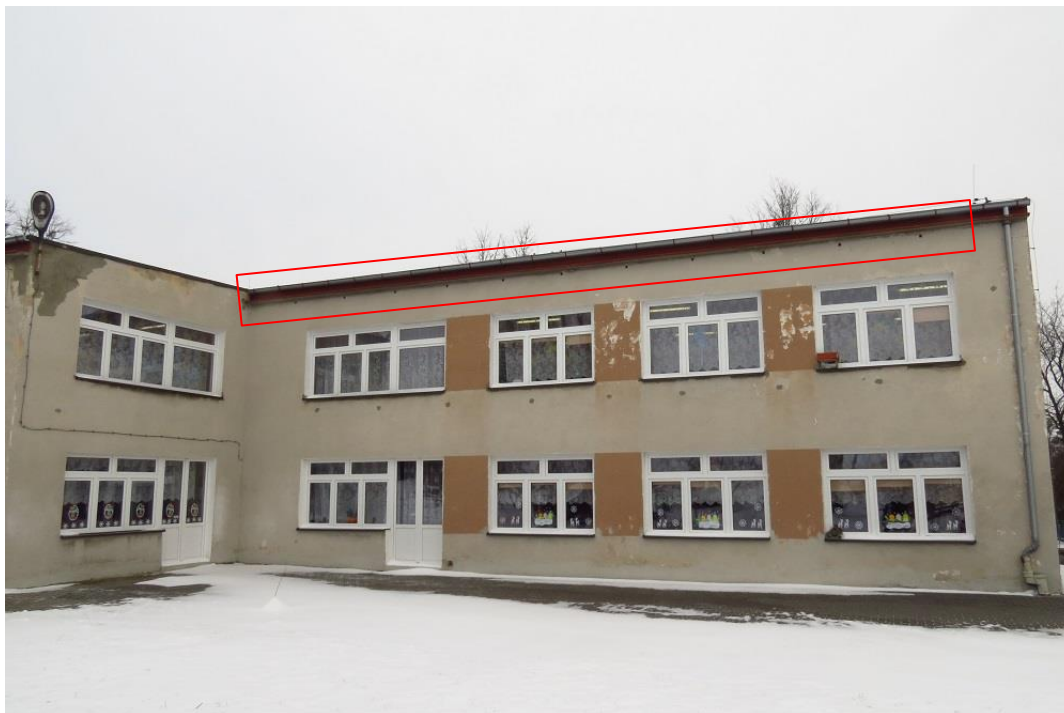
Fot. 2. Fragment elewacji południowej. Czerwonym prostokątem zaznaczono rząd nie zabezpieczonych wywietrzników prowadzących do stropodachu.
