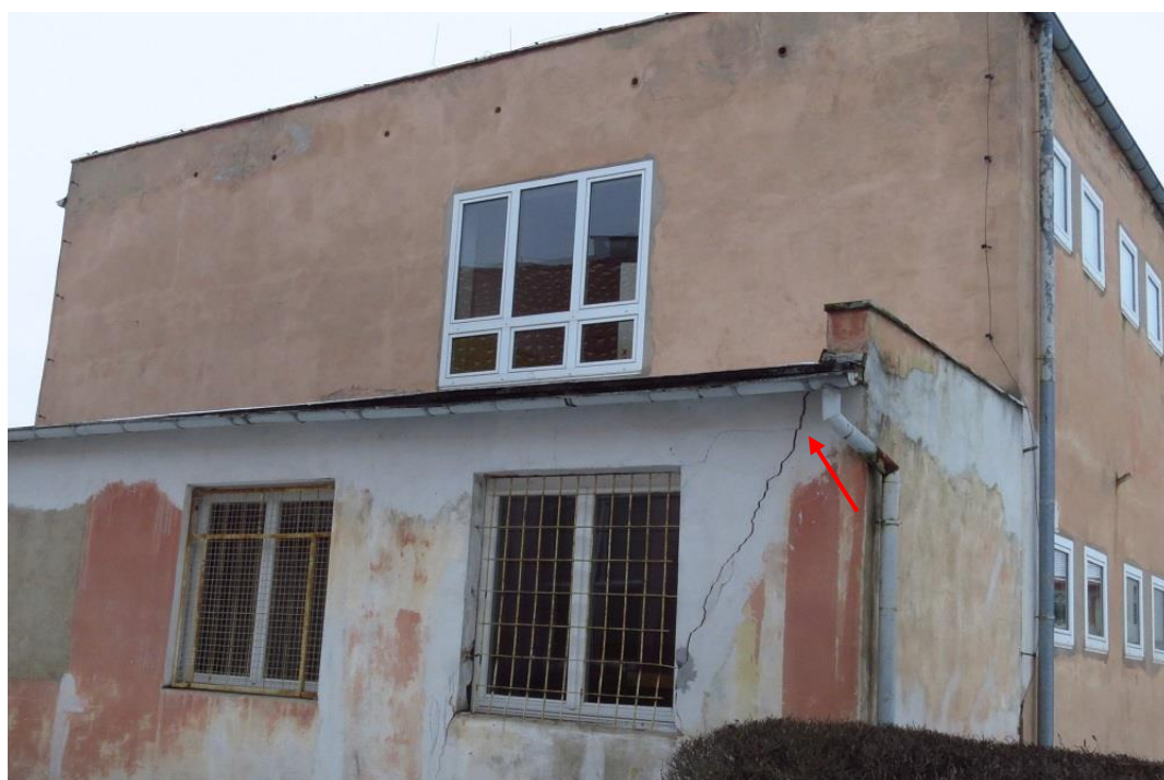
Fot. 8 Wschodnia elewacja szkoły podstawowej z zaznaczoną szczeliną stanowiącą potencjalną kryjówkę nietoperzy.
