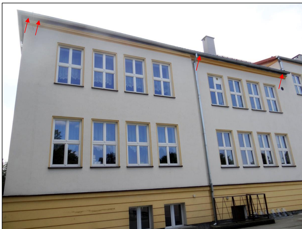
Fot. 6. Zespół Szkół – elewacja wschodnia (od dziedzińca) – część lewa. Lokalizacja gniazd jaskółek.
