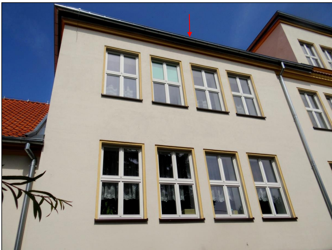
Fot. 1. Korsze – budynek Zespołu Szkół – elewacja główna (wejściowa) – strona lewa. Gniazdowanie wróbla.
