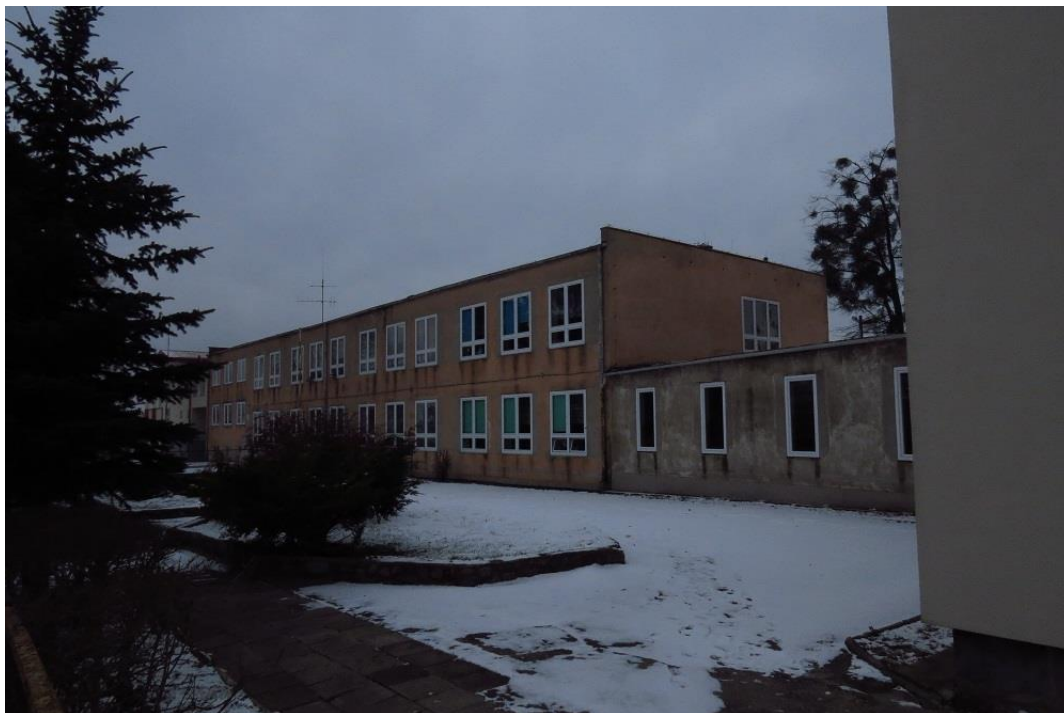
Fot. 5. Szkoła podstawowa i prowadzący do niej łącznik, widok od str. południowej
