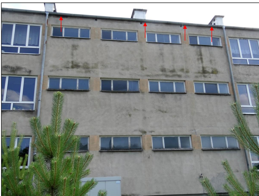
Fot. 18. SP w Garbnie – elewacja północna, cz. B. Lokalizacje miejsc gniazdowania jerzyków.
