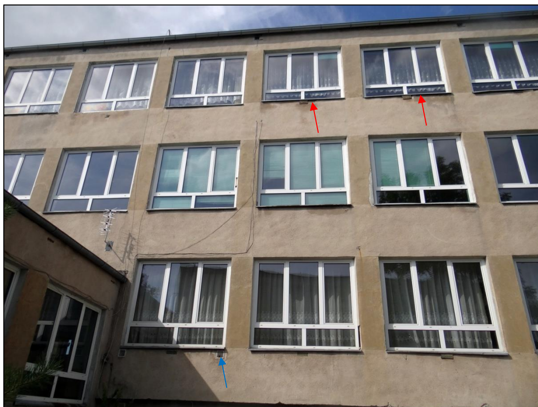
Fot. 14. Szkoła Podstawowa w Garbnie – elewacja wejściowa (część prawa). Lokalizacja miejsc łęgowych jerzyków (strzałki czerwone) i bogatki (strzałka niebieska).
