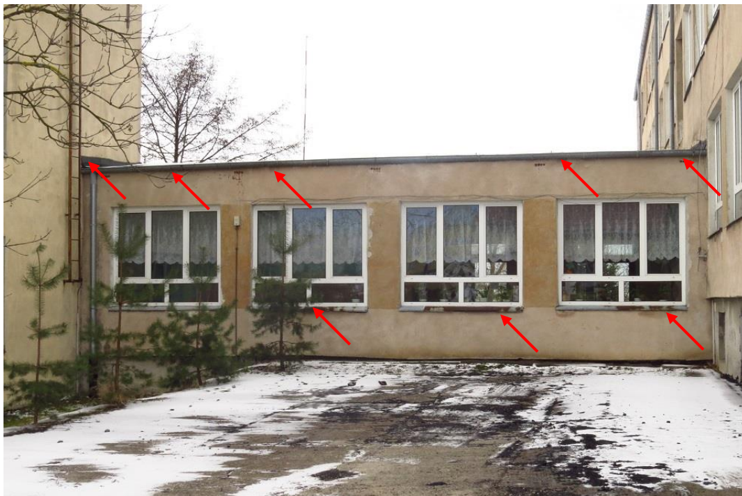
Fot. 7 Łącznik pomiędzy głównym budynkami szkoły. Strzałkami zaznaczono potencjalne schronienia nietoperzy.
