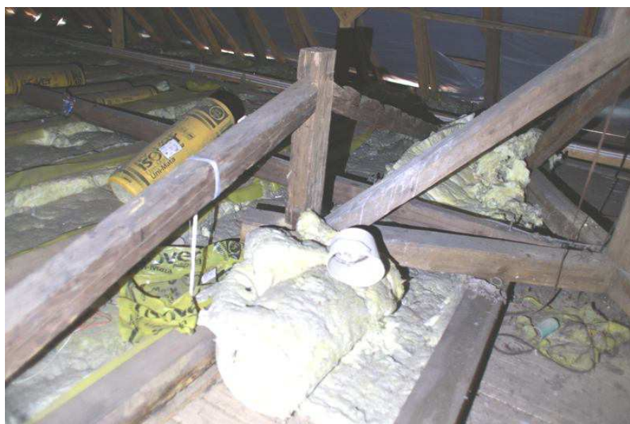
fot.16. Widok jednowieszakowego wieszarowego podpierającego podwalinę wieżyczki – ze względu na rozluźnienia wiaźar przewidziany do rozbiórki
