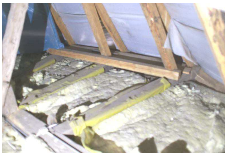
fot.12. Widok belkowania stropu nad trójbocznym zamknięciem prezbiterium.
