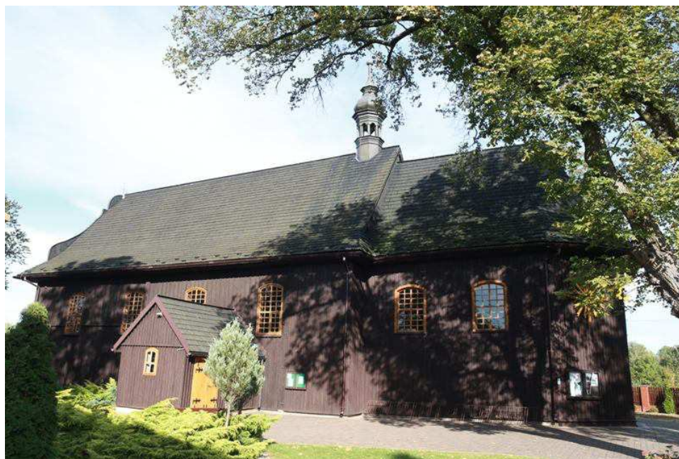
fot.1. Widok kościoła od strony południowo-wschodniej
