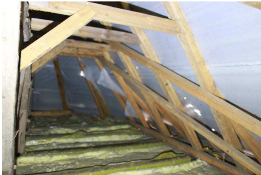
fot.14. Widok krokwi od strony południowej prezbiterium z niepoprawnym, nowoczesnym usztywnieniem podłużnym dachu w postaci wiatrownic. Dodatkowo widoczne tymczasowe zabezpieczenie folią przed przeciekami przez pokrycie dachowe
