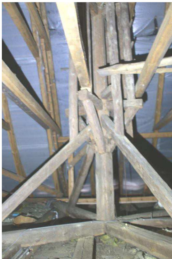
fot.17. Widok wtórnej? podstawy wieżyczki – przewidzianej do demontażu
