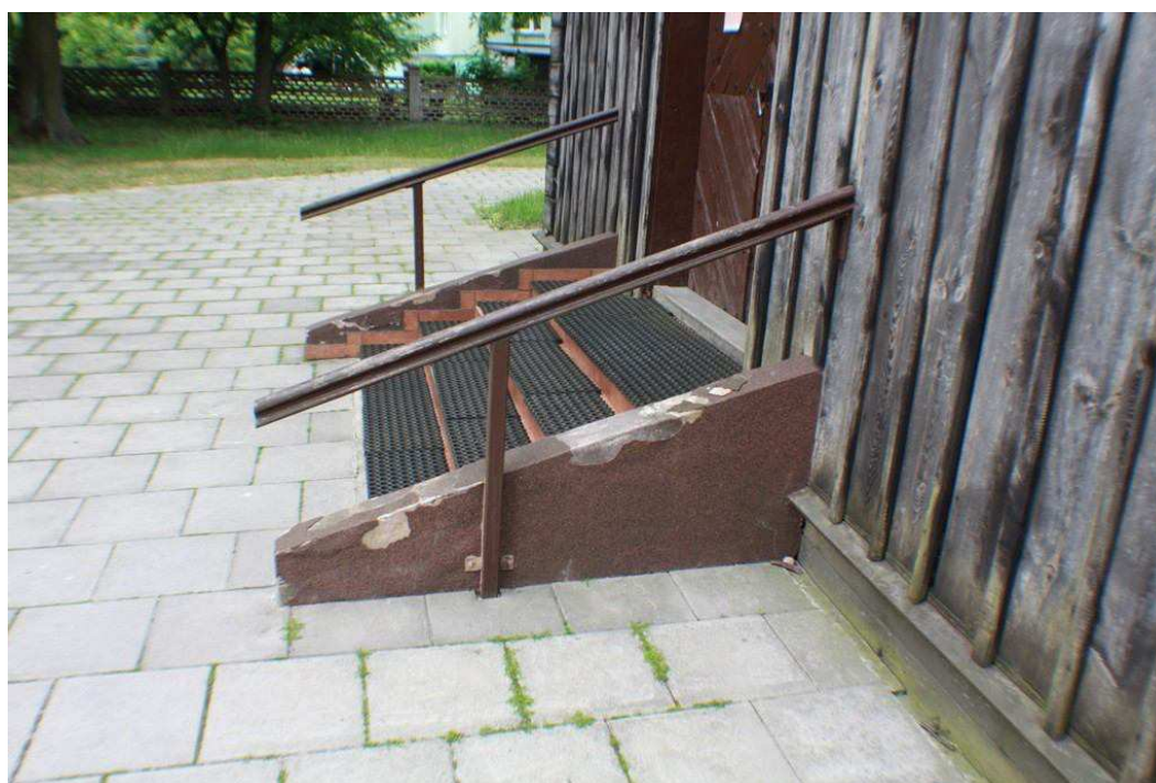
fot.20. Widok uszkodzeń szalunku zewnętrznego – elewacja zachodnia
