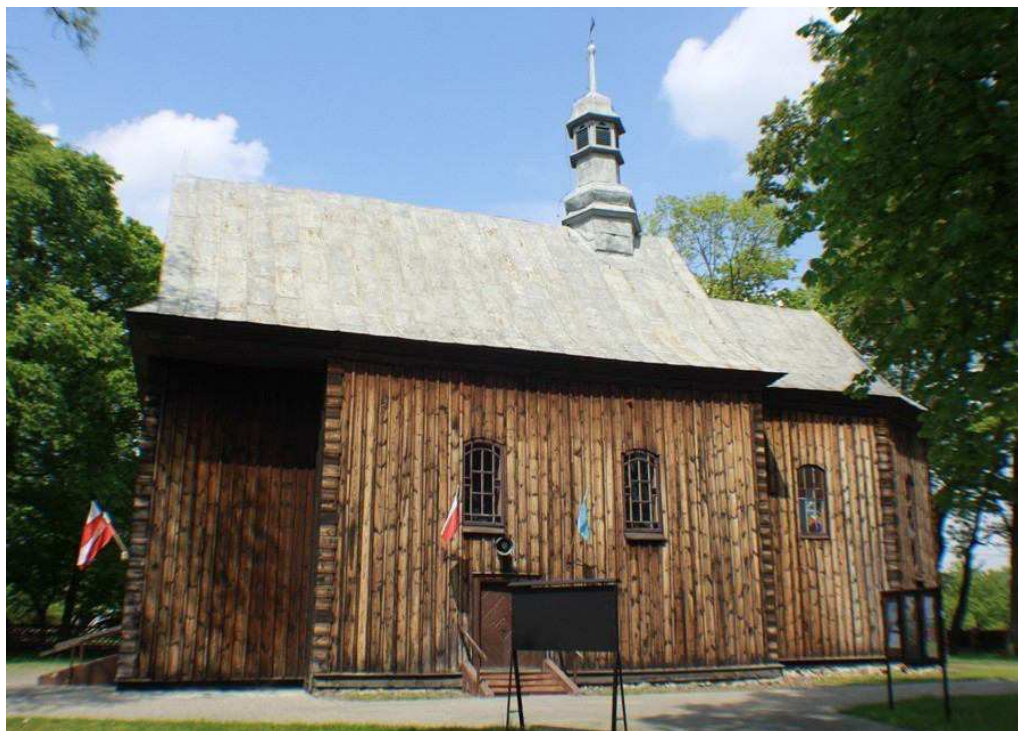
fot.1. Widok kościoła od strony południowej
