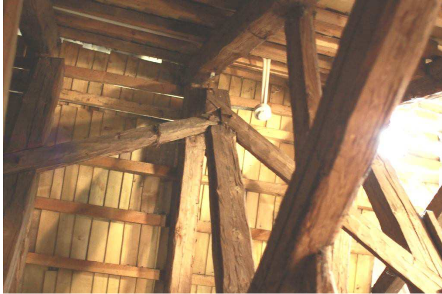
fot.12. Widok stężenia podłużnego nad nawą – osie 4-6
