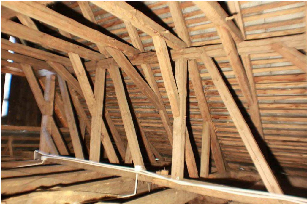
fot.11. Widok zastrzałów bocznych nad nawą – strona północna
