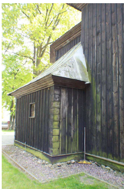
fot.4. Widok zakrystii dostawionej do prezbiterium od strony północnej
