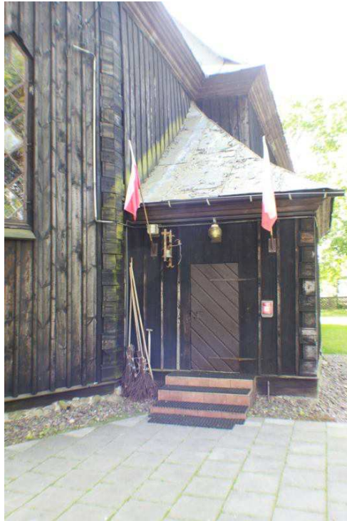
fot.18. Widok posadowienia z betonowym (żelbetowym) cokołem w północno-wschodnim narożniku prezbiterium
