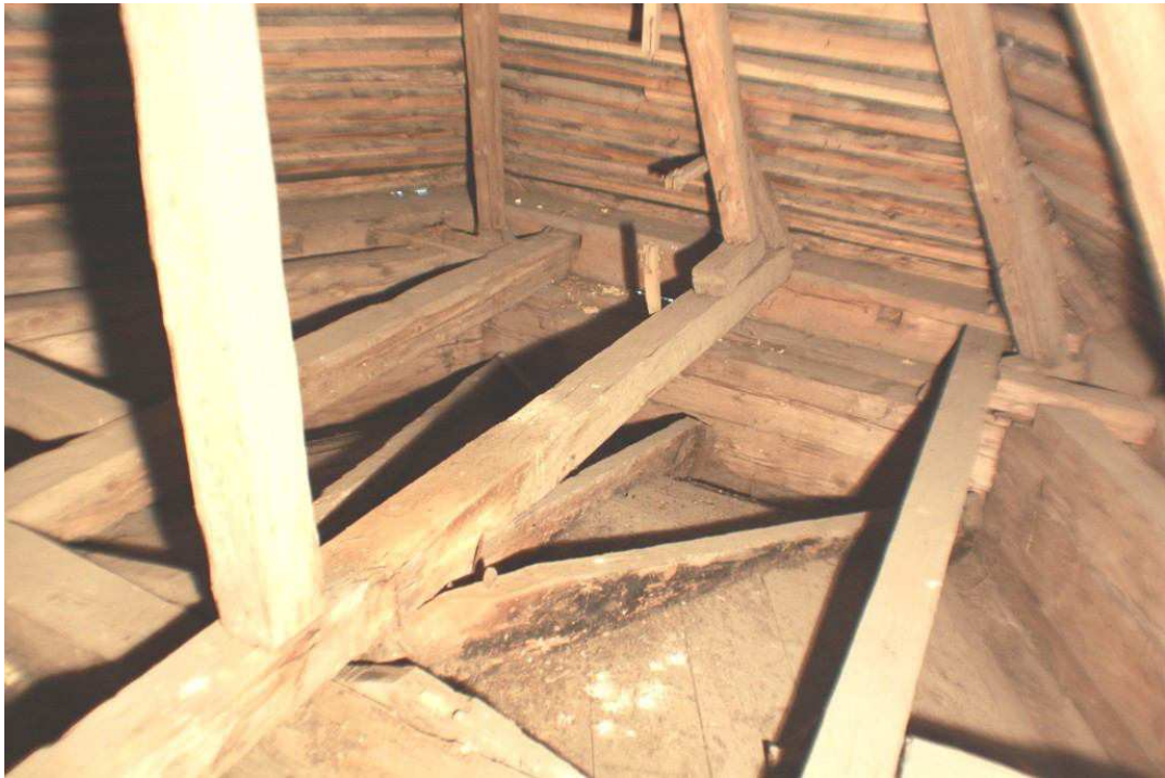
fot.16. Widok konchowego zamknięcia sklepienia nad prezbiterium Pod okapami dachowymi zamontowano drewniane profilowane gzymsy belkowe.
