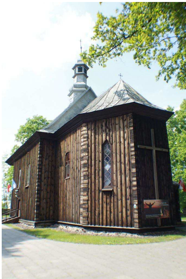
fot.3. Widok kościoła od strony południowo-wschodniej
