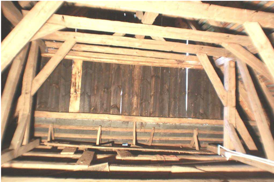
fot.10. Widok dźwigarów nad nawą w kierunku wschodnim
