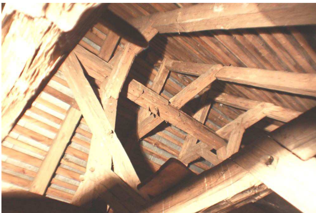
fot.15. Widok stężenia podłużnego w kalenicy nad nawą
