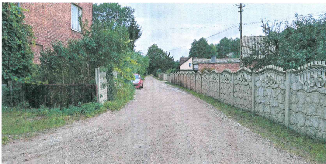
Droga przed remontem
