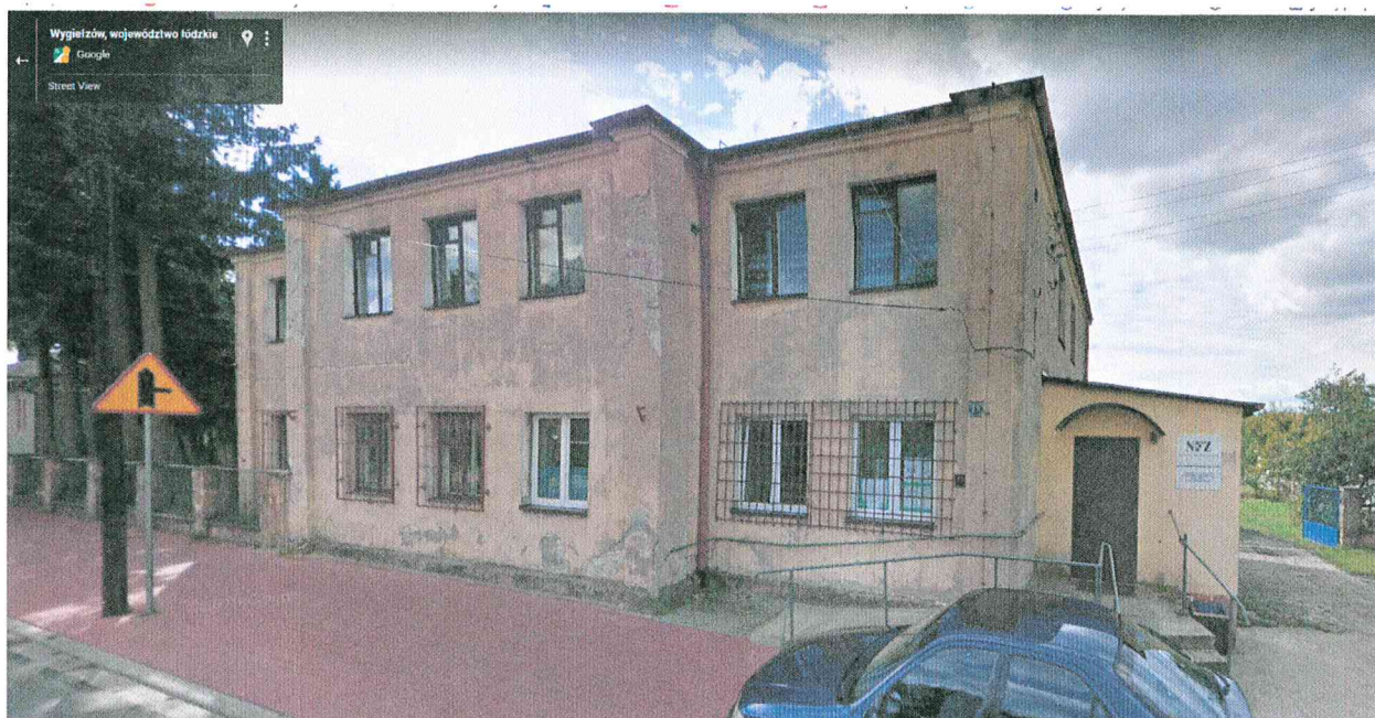
Budynek przed przeprowadzeniem termomodernizacji -SPZOZ w Wygierzowie
