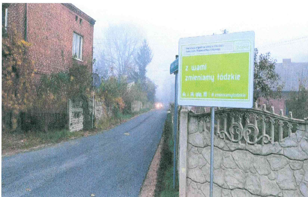
Droga po remoncie
