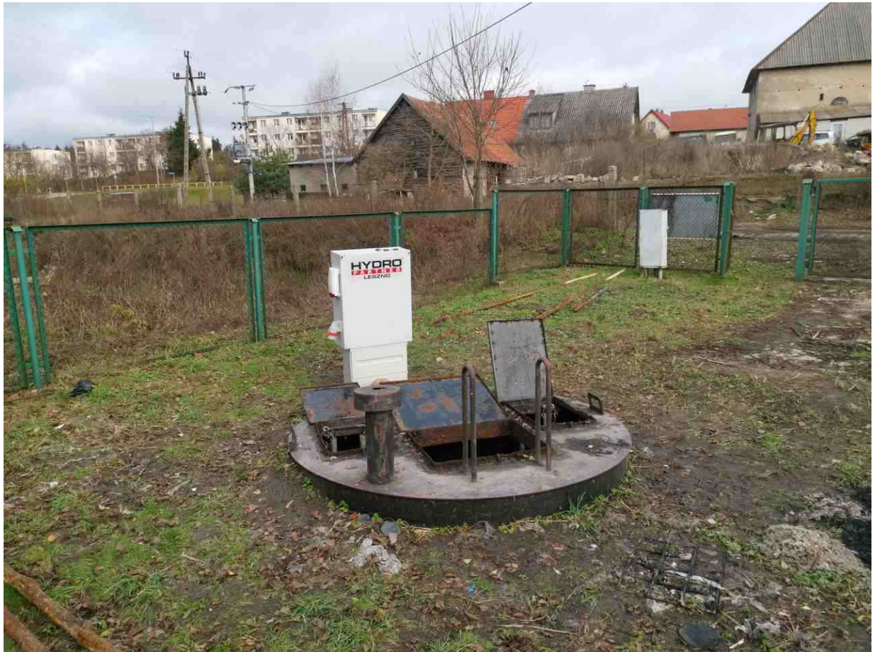
Zdjęcie 5 Widok na wejście na teren przepompowni ścieków
