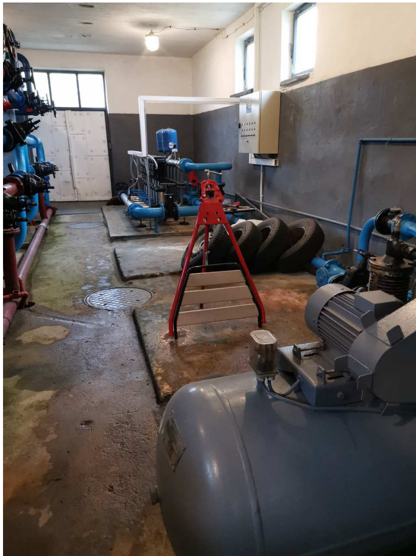
Zdjęcie 3 Budynek SUW – widok na zestaw pompowy i sprężarkę
