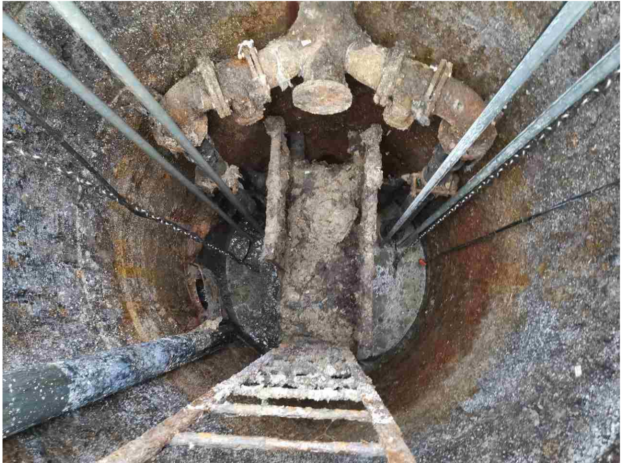
Zdjęcie 3 Istniejąca przepompownia ścieków – środek
