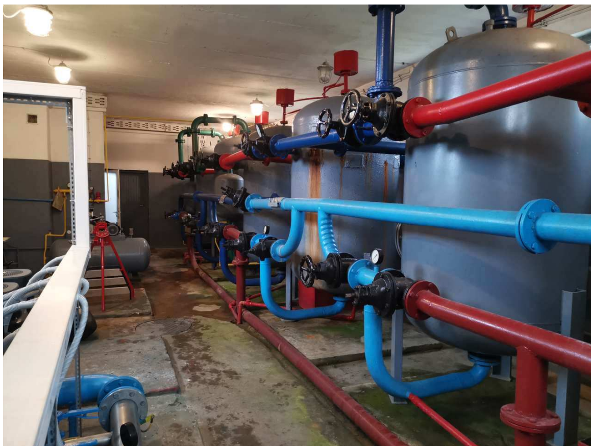
Zdjęcie 2 Budynek SUW – hala filtrów
