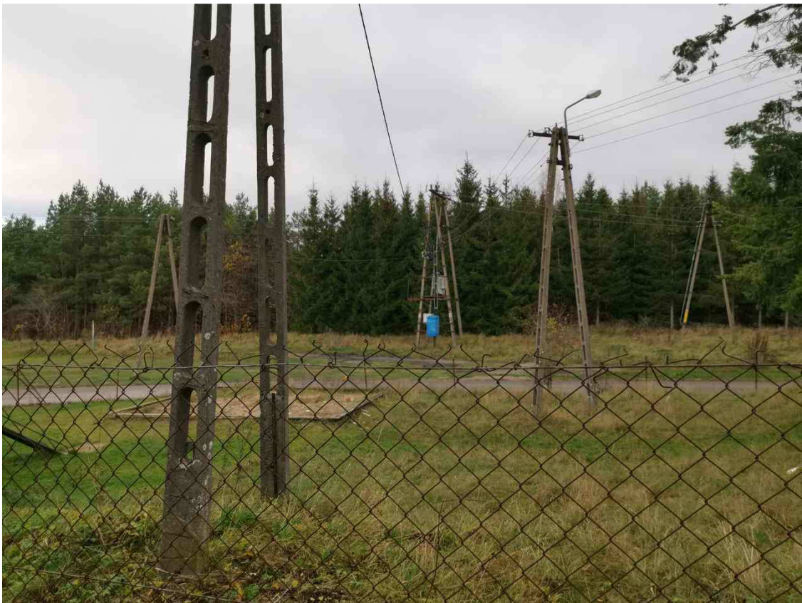
Zdjęcie 8 Widok na stację transformatorową
