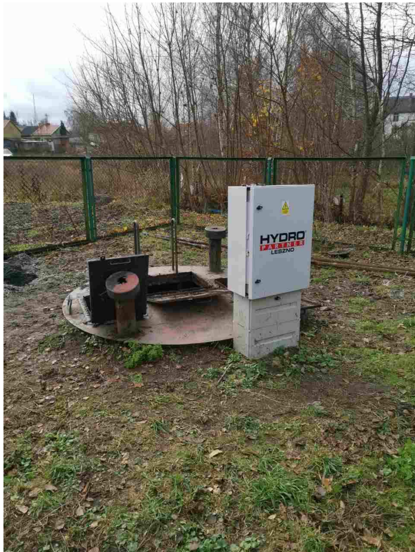
Zdjęcie 2 Istniejące przepompownia ścieków – teren
