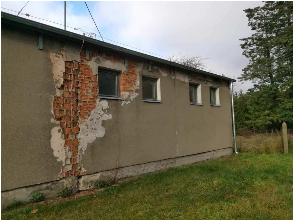
Zdjęcie 7 Budynek SUW – elewacja boczna
