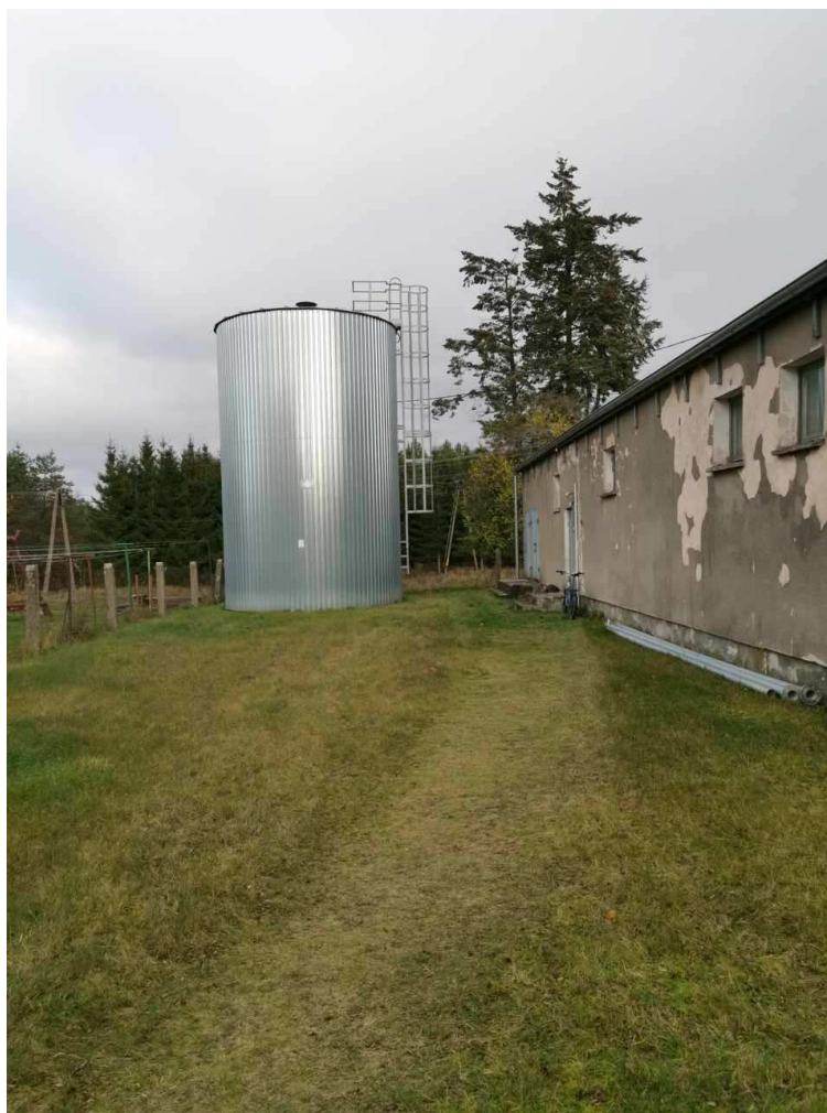
Zdjęcie 5 Budynek SUW – elewacja boczna
