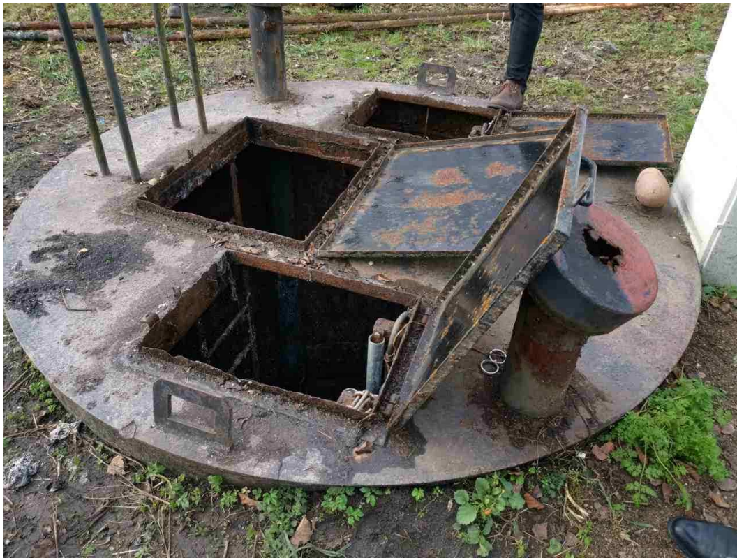
Zdjęcie 1 Istniejące przepompownia ścieków – pokrywa
