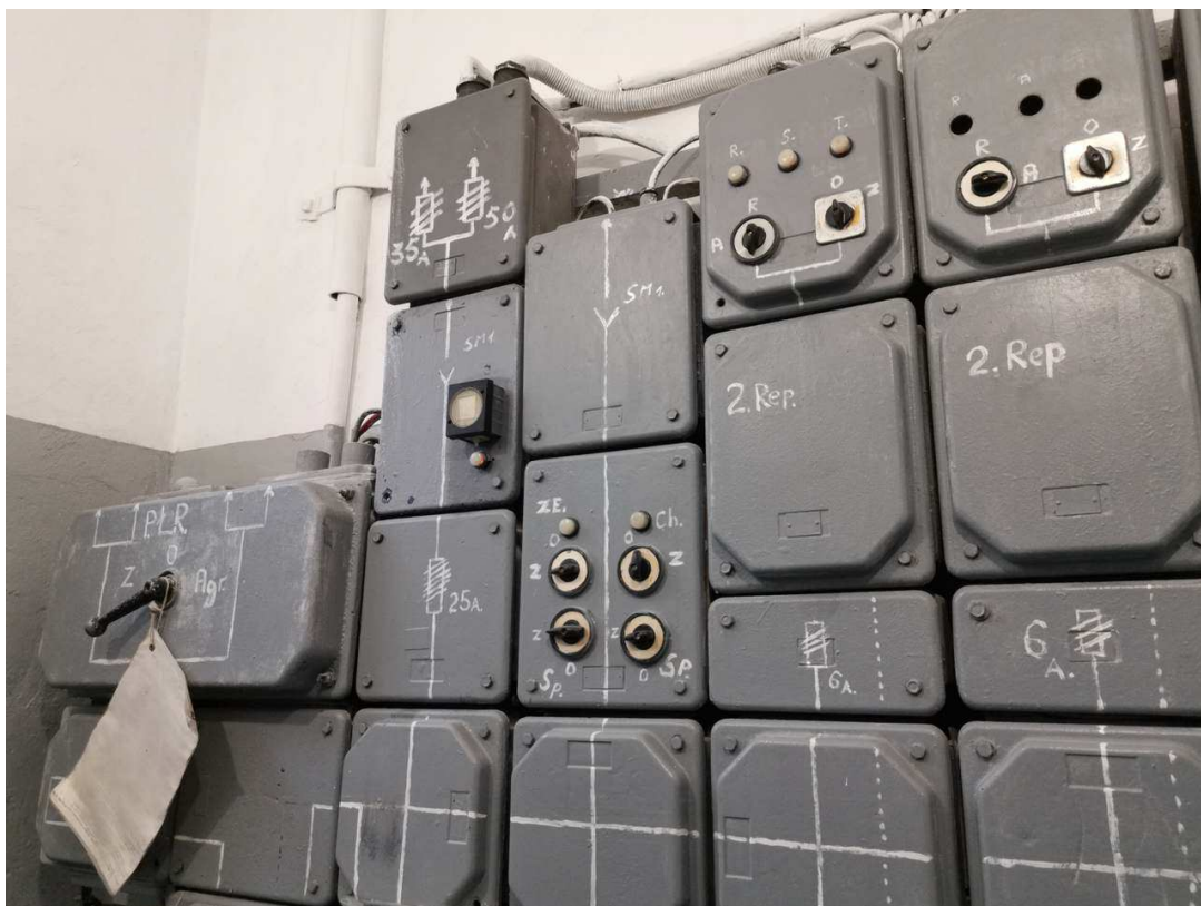
Zdjęcie 4 Budynek SUW – sterownia
