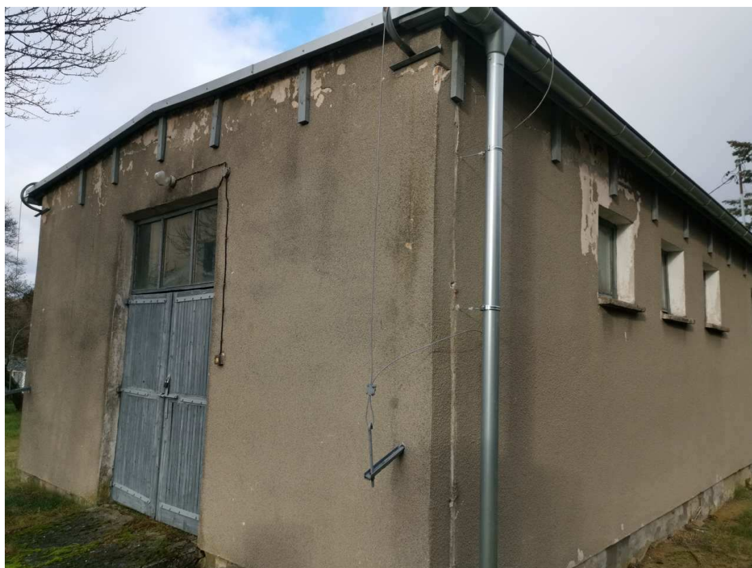
Zdjęcie 6 Budynek SUW – elewacja frontowa i boczna
