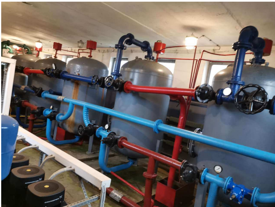
Zdjęcie 1 Budynek SUW – widok filtrów
