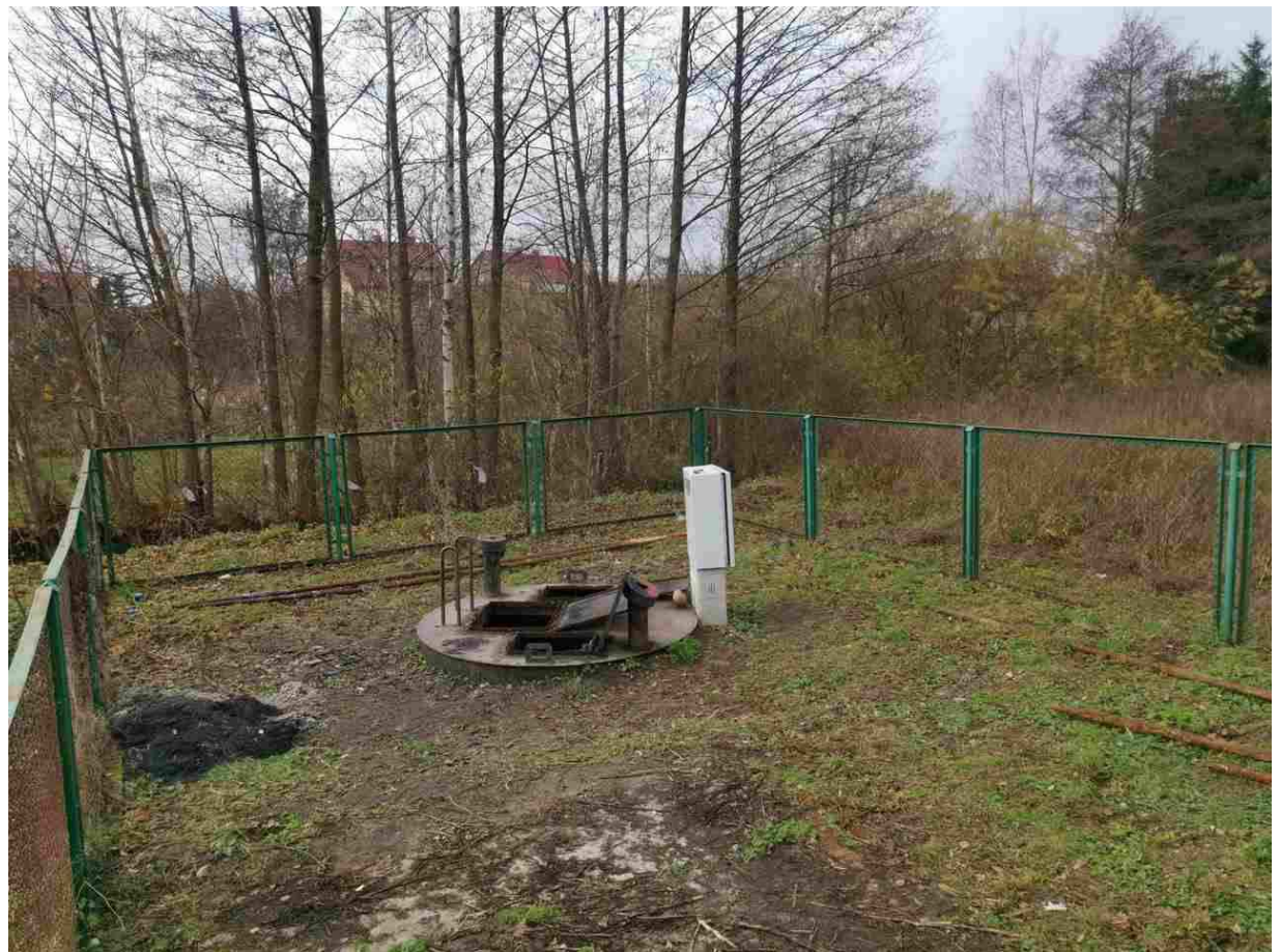
Zdjęcie 4 Teren przepompowni ścieków
