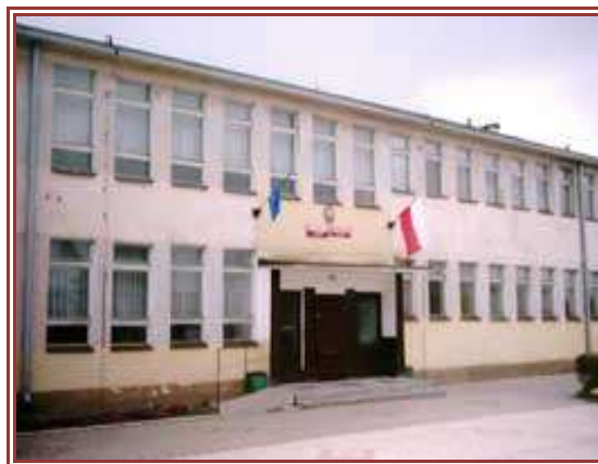
Budynek Zespołu Szkół w Pozezdrzu
