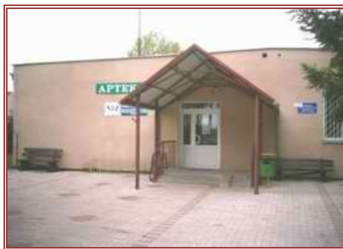
Budynek Ośrodka Zdrowia
