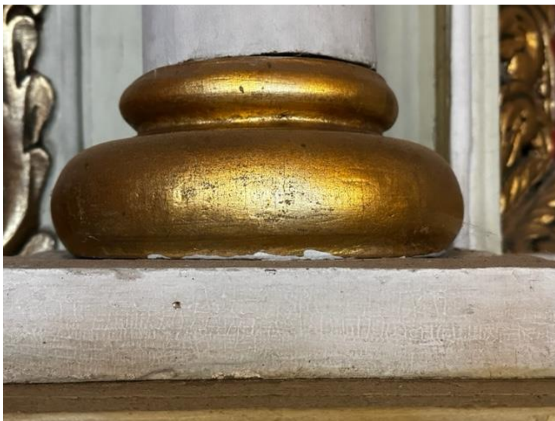
5. Stan zachowania – detal.
