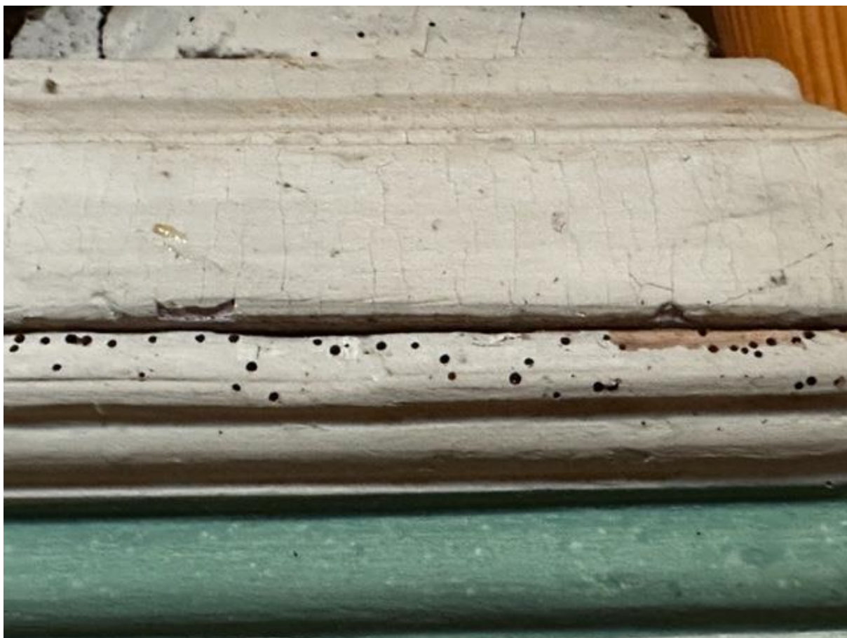
3. Stan zachowania obiektu – ślady po drewno jadach.
