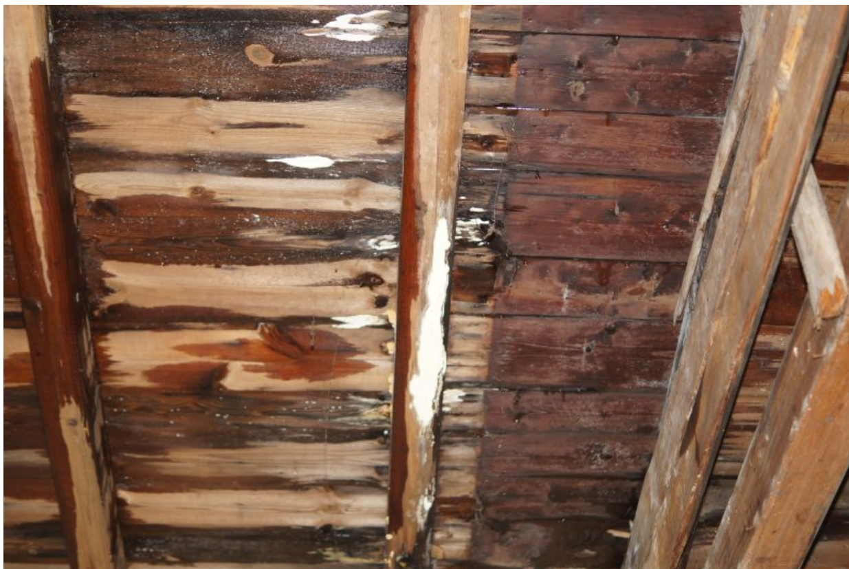
Fot.5 Uszkodzona biologicznie krokiew oraz widoczne zawilgocenia krokwi sąsiedniej.
