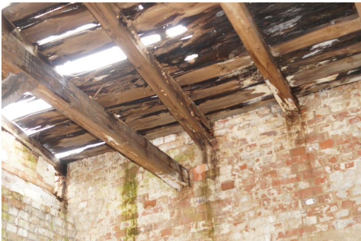
Fot. 3. Północno-wschodni narożnik budynku. Widok uszkodzonego pokrycia i więźby.
