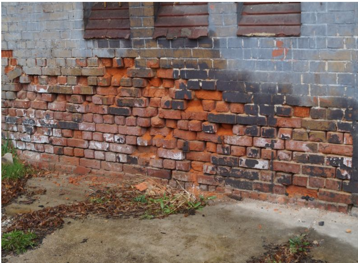
Fot. 9. Elewacja zachodnia budynku. Widok uszkodzonych spoin.
