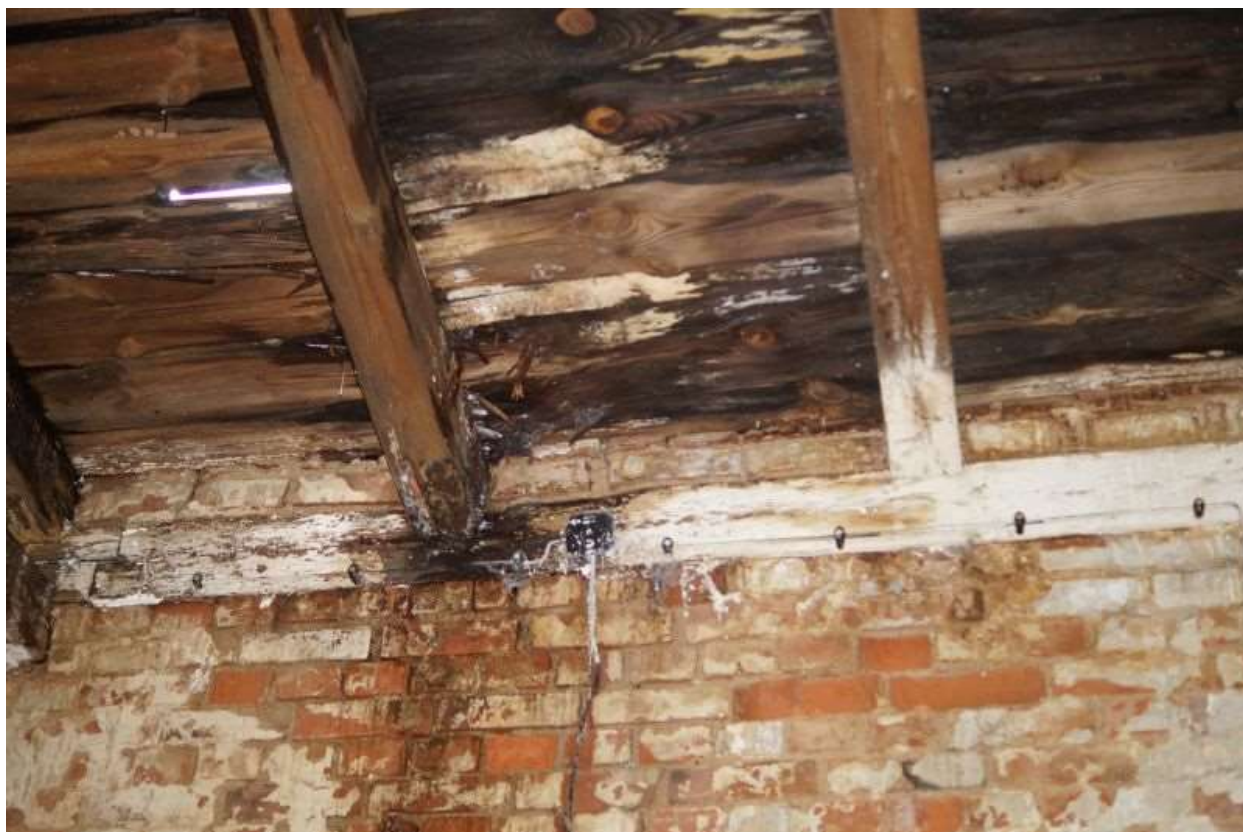
Fot.4. Oparcie więźby na elewacji zachodniej. Uszkodzone pokrycie dachowe, krokiew oraz murlata.
