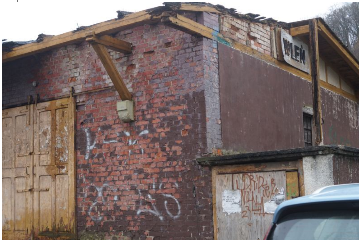
Fot.6 Elewacja zachodnia. Usunięte wsporniki krokwi, oraz lokalne zarwanie okapu.
