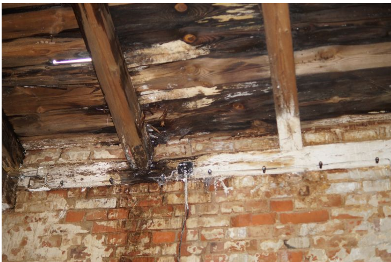
Fot.4. Oparcie więźby na elewacji zachodniej. Uszkodzone pokrycie dachowe, krokiew oraz
