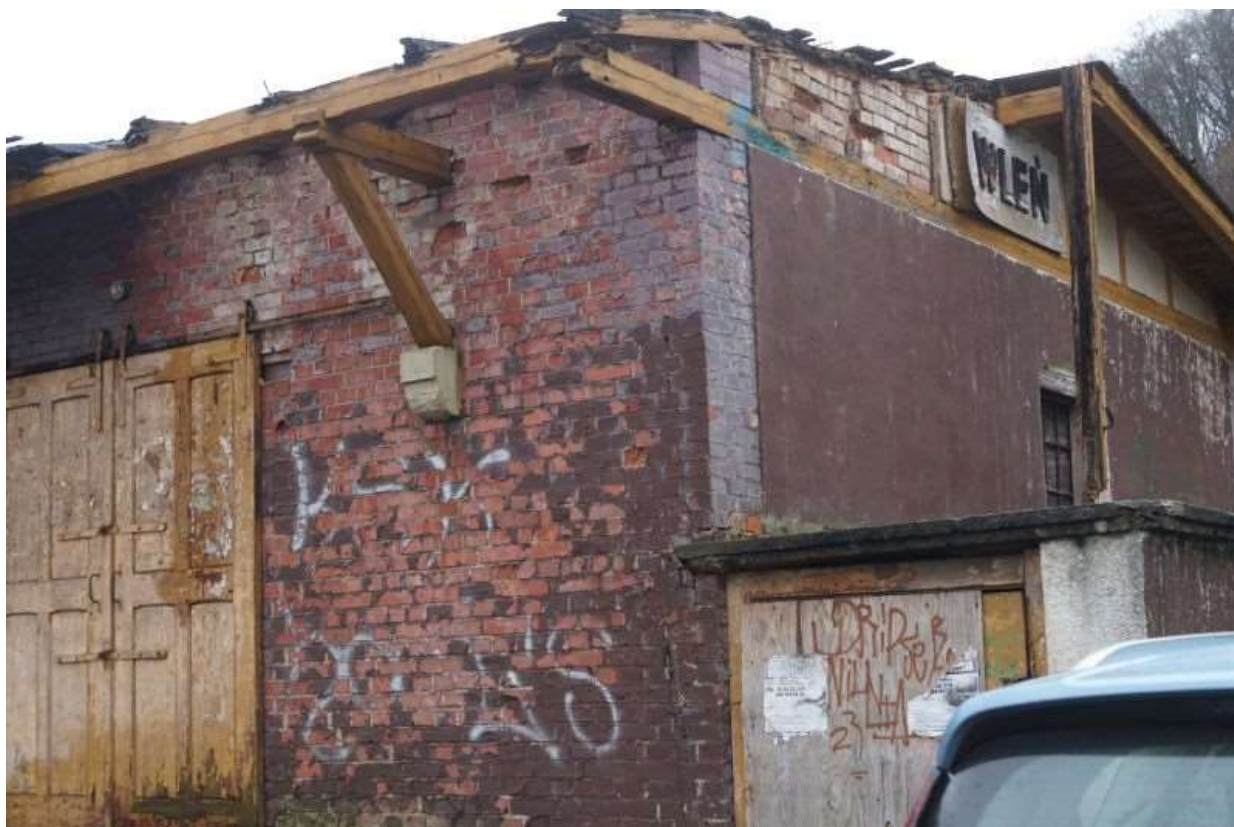
Fot. 7. Północno-wschodni narożnik budynku. Widok uszkodzonego pokrycia i więźby.
