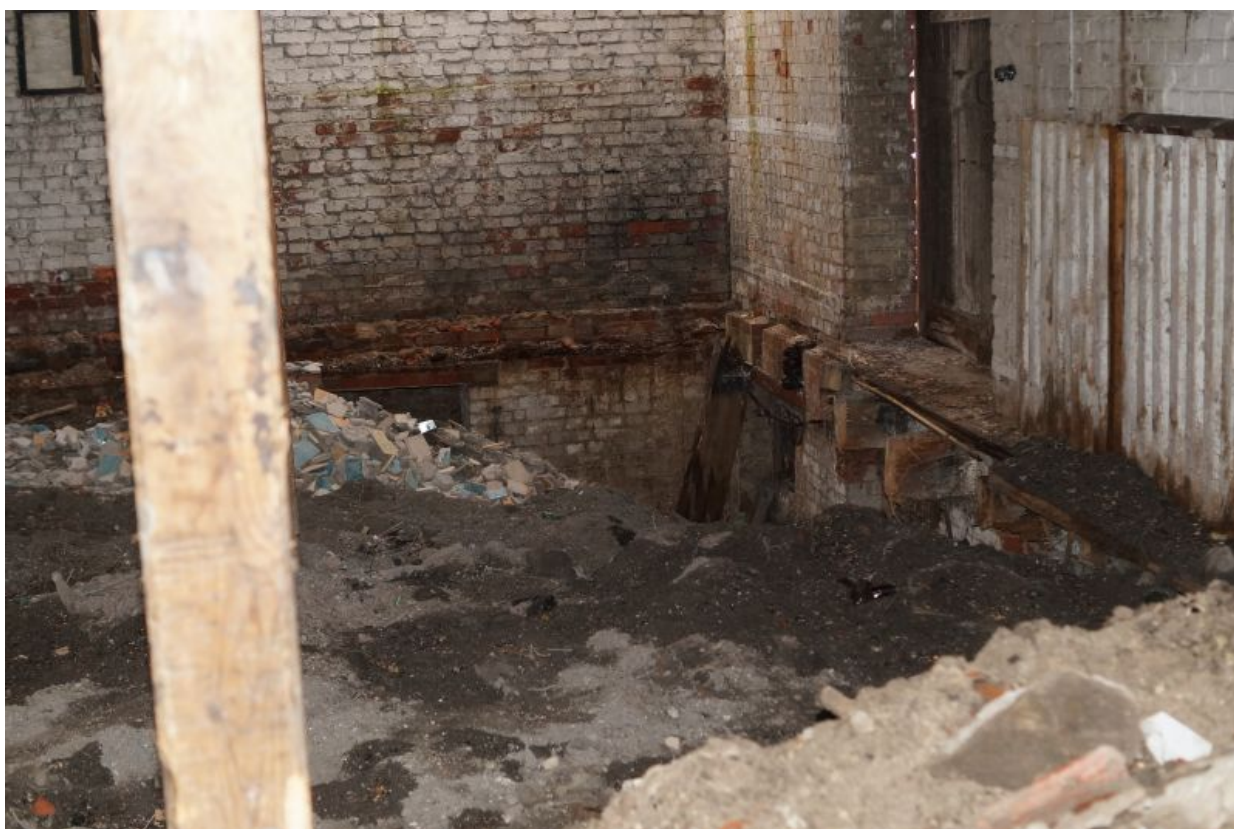
Fot. 2 Wnętrze magazynu. Widok na usunięty drewniany strop w nad piwnicą.
