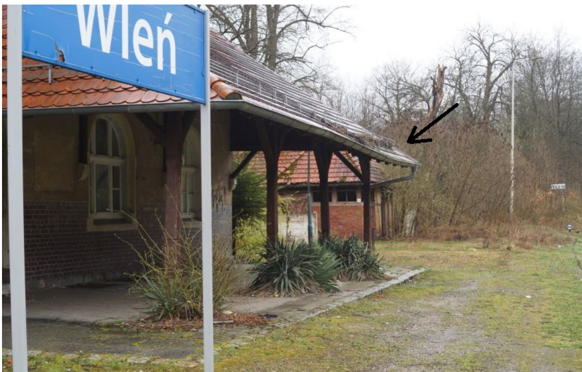
Fot. 10. Elewacja zachodnia budynku dworca PKP. Uszkodzone pokrycie dachu.
