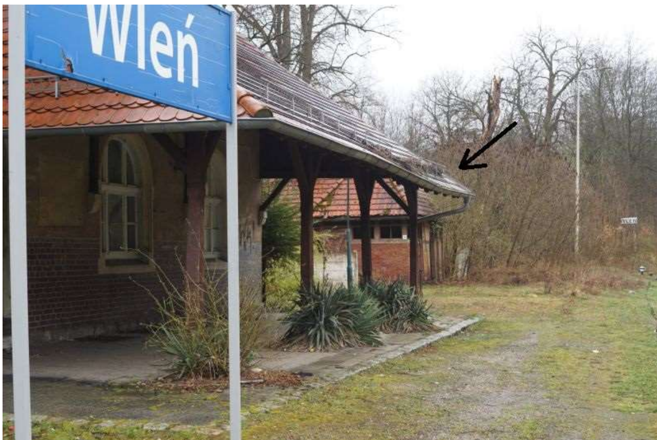
Fot. 10. Elewacja zachodnia budynku dworca PKP. Uszkodzone pokrycie dachu.
