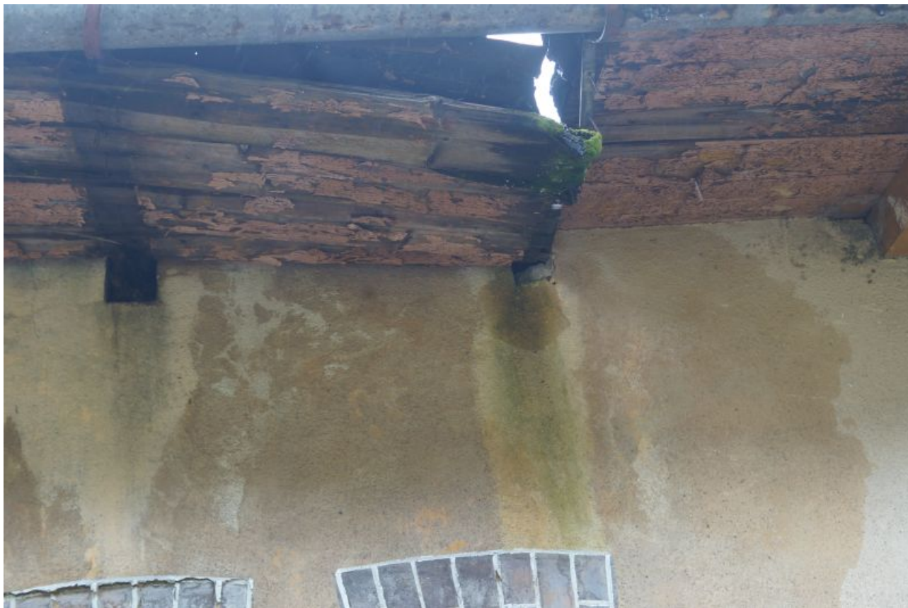
Fot.6 Elewacja zachodnia. Usunięte wsporniki krokwi, oraz lokalne zarwanie okapu.
