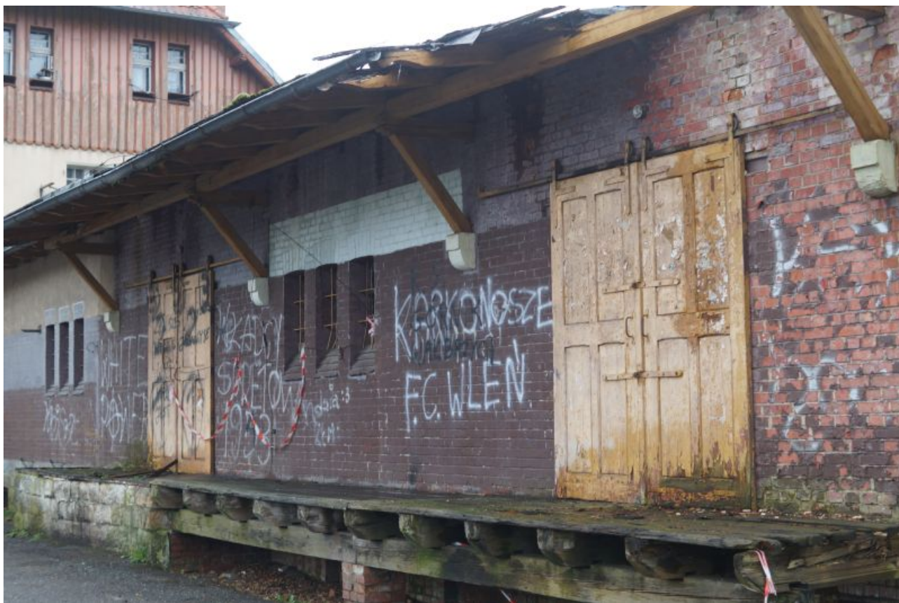
Fot. 8. Elewacja wschodnia budynku. Widok uszkodzonego pokrycia i więźby.
