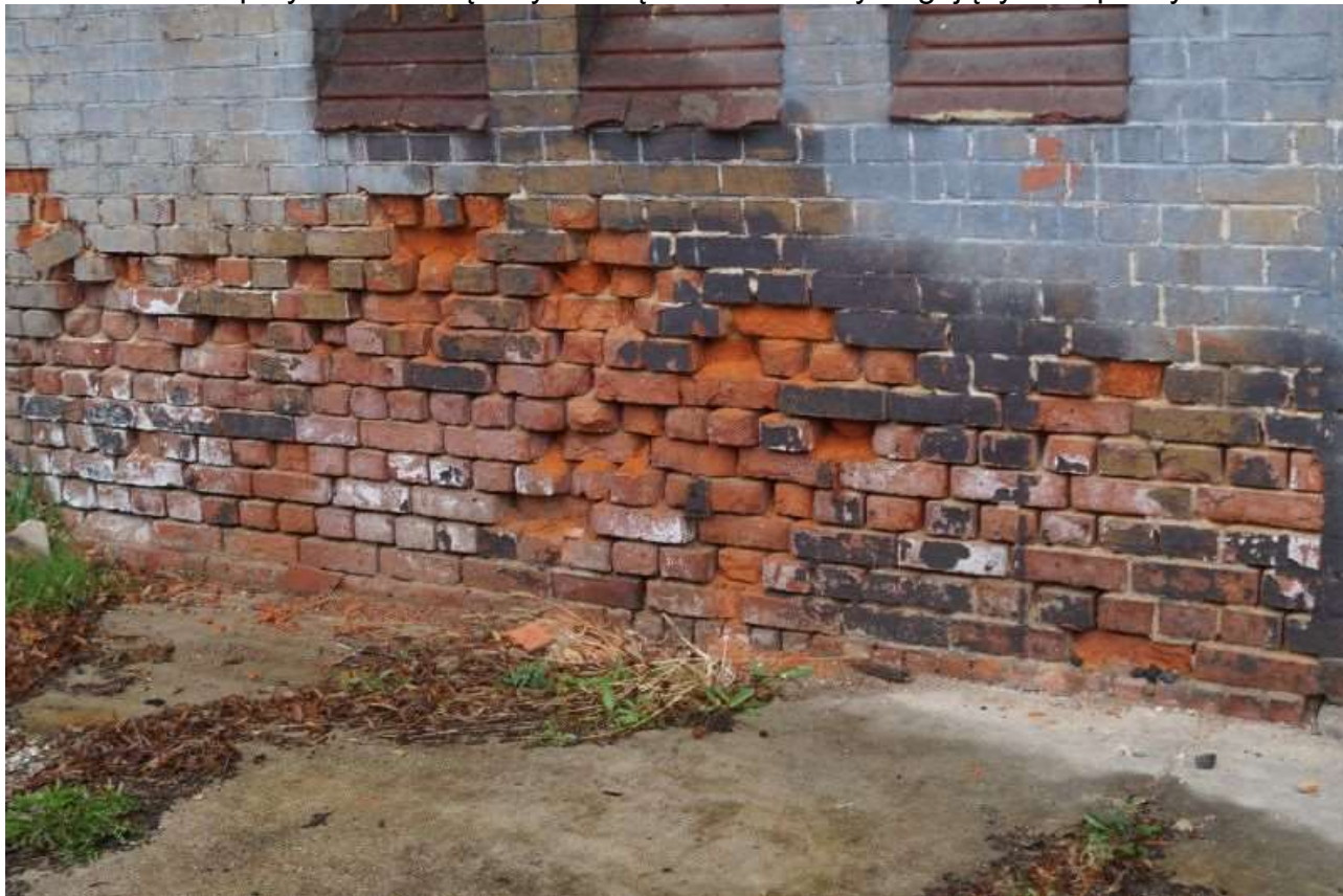
Fot. 9. Elewacja zachodnia budynku. Widok uszkodzonych spoin.
