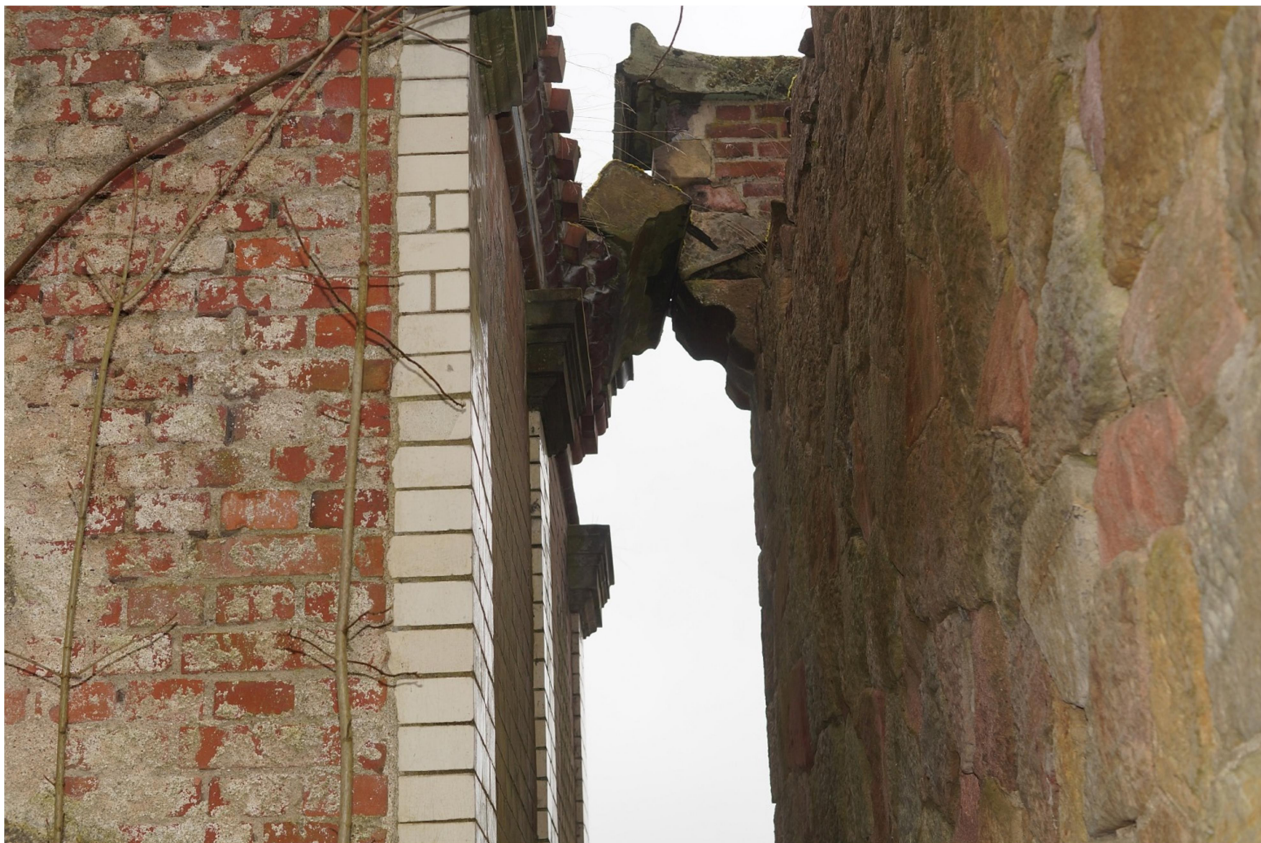
Fot.5. Kaplice K1 i K2. Widok na przestrzeń pomiędzy kaplicami. Widoczne uszkodzenie gzymsu kamiennego kaplicy K1.
