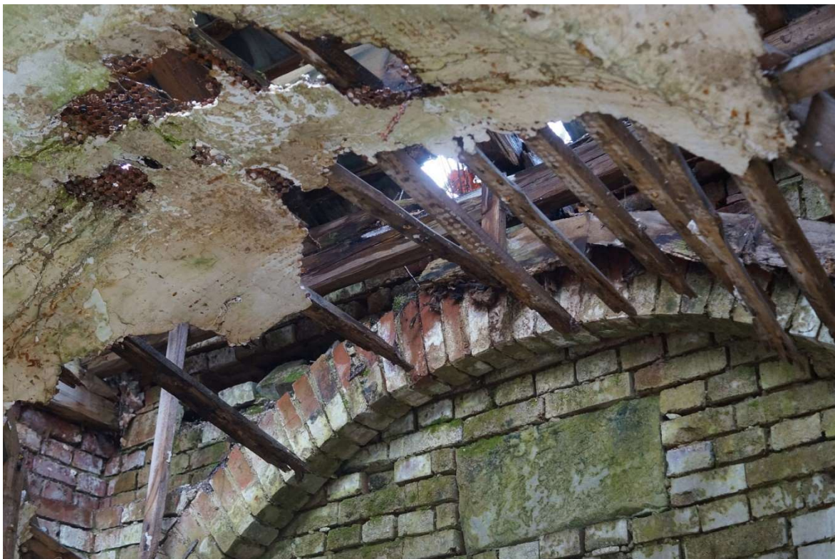
Fot.2. Kaplica K2. Widok na fragment sklepienia krzyżowego wykonanego na podkonstrukcji z rusztu drewnianego jako powłoka z tynku mineralnego na osnowie z siatki Rabbita. Widoczne znaczne uszkodzenia sklepienia oraz zadaszienia kaplicy.
