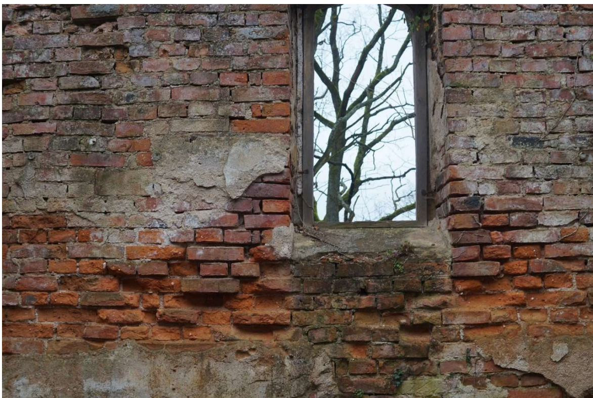
Fot.3. Kaplica K1. Widok na fragment ściany tylnej. Widoczne liczne uszkodzenia materii ściennej.
