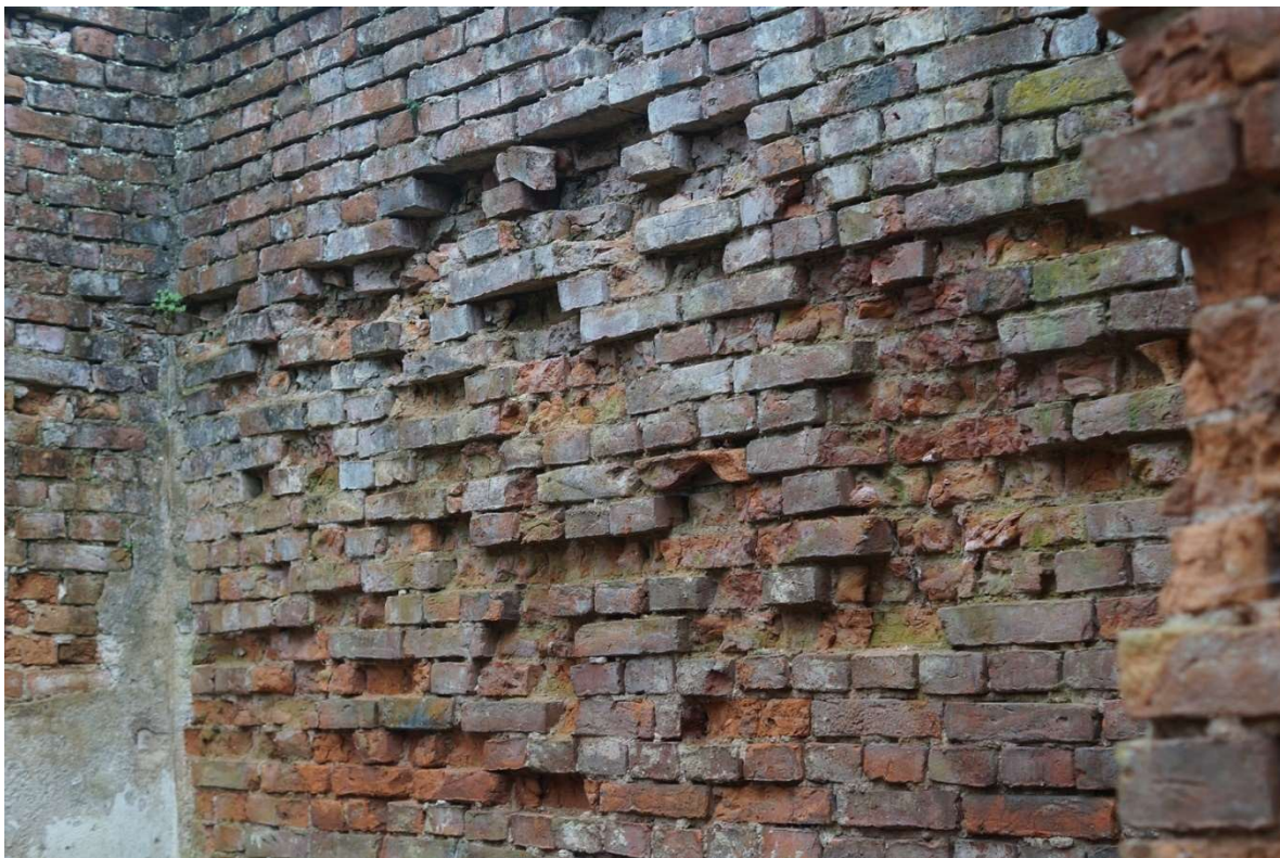
Fot.4. Kaplica K1. Widok na fragment ściany tylnej oraz bocznej. Widoczne liczne uszkodzenia materii ściennej.
