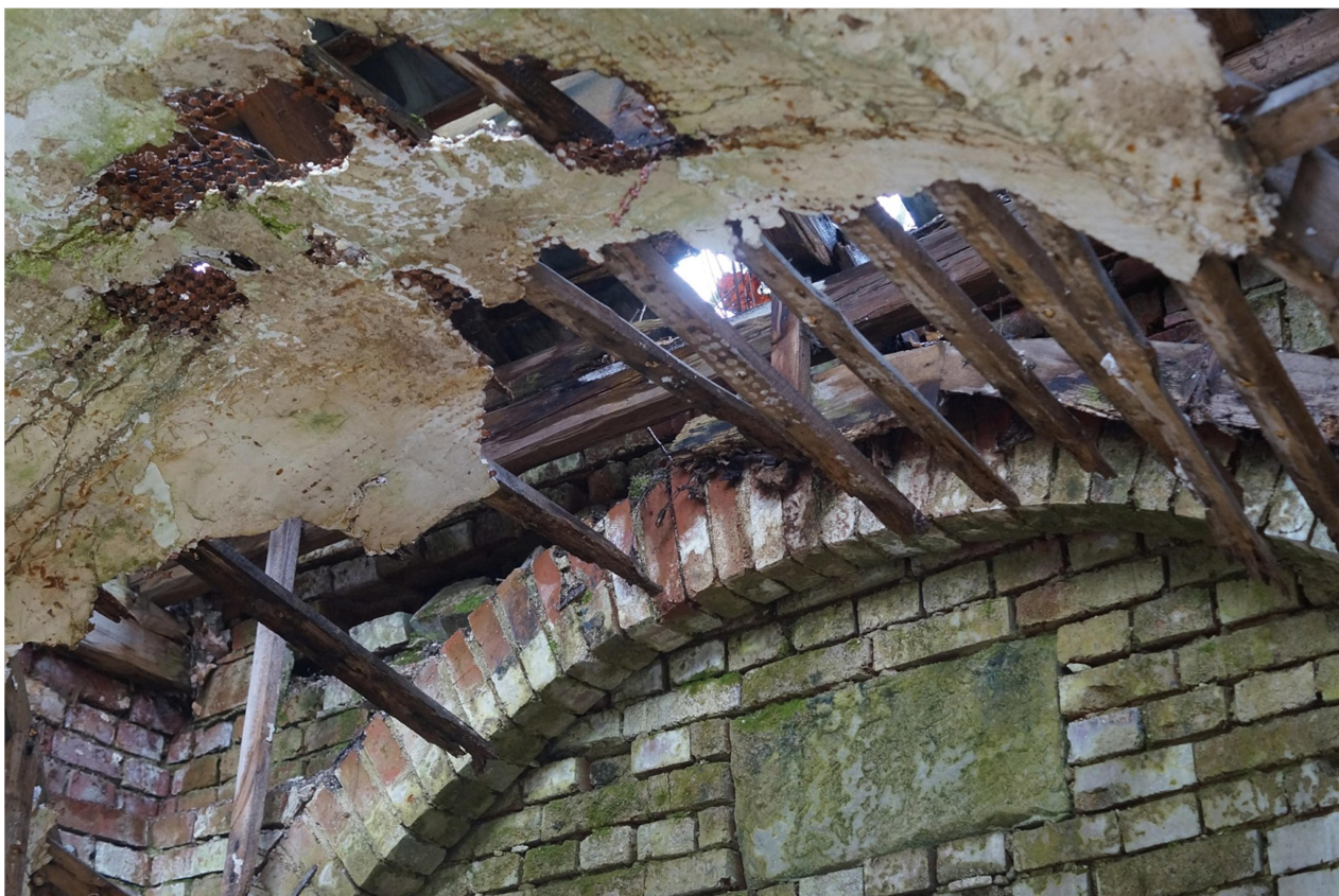
Fot.2. Kaplica K2. Widok na fragment sklepienia krzyżowego wykonanego na podkonstrukcji z rusztu drewnianego jako powłoka z tynku mineralnego na osnowie z siatki Rabbita. Widoczne znaczne uszkodzenia sklepienia oraz zadaszenia kaplicy.
