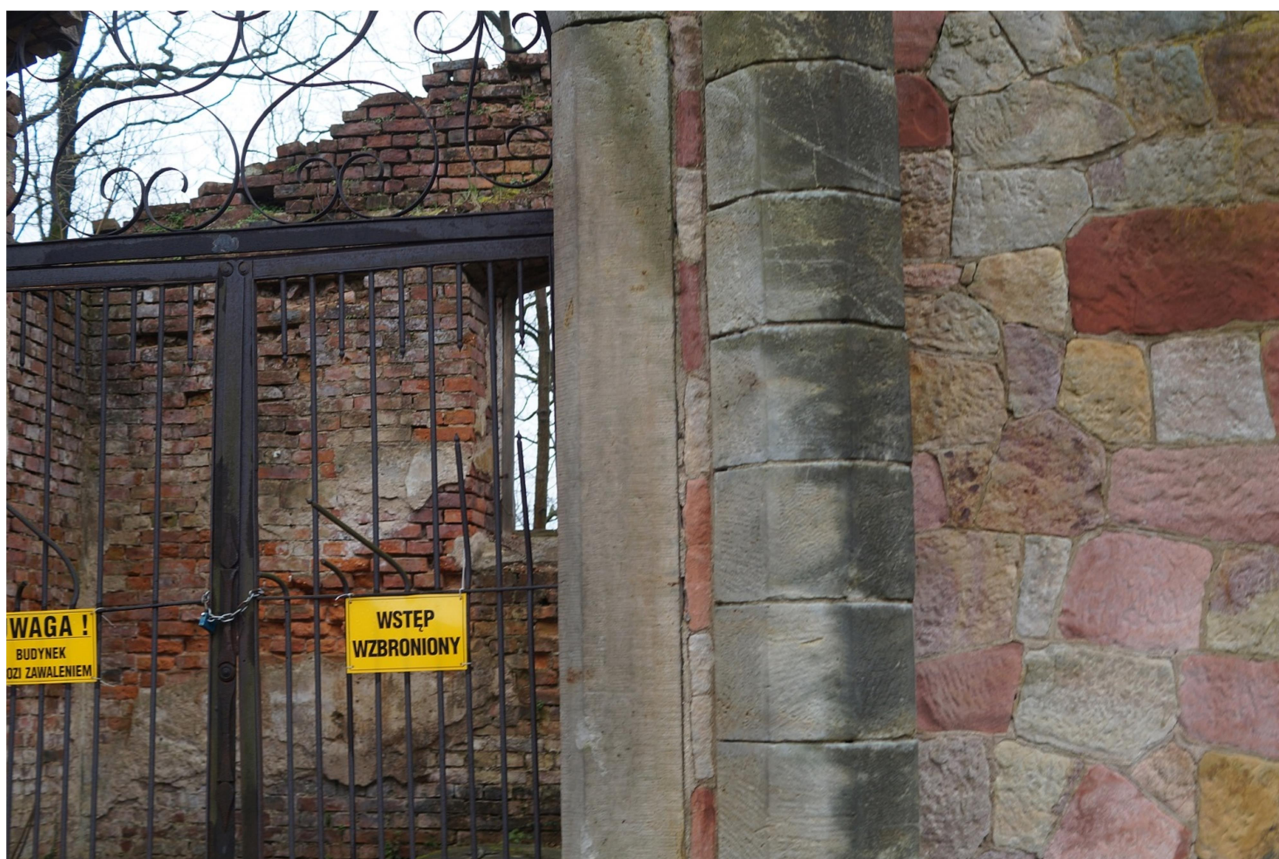
Fot.1. Kaplica K1. Widok na fragment ściany frontowej oraz tylnej. Widoczny brak dachu oraz liczne uszkodzenia materii ściennej.
