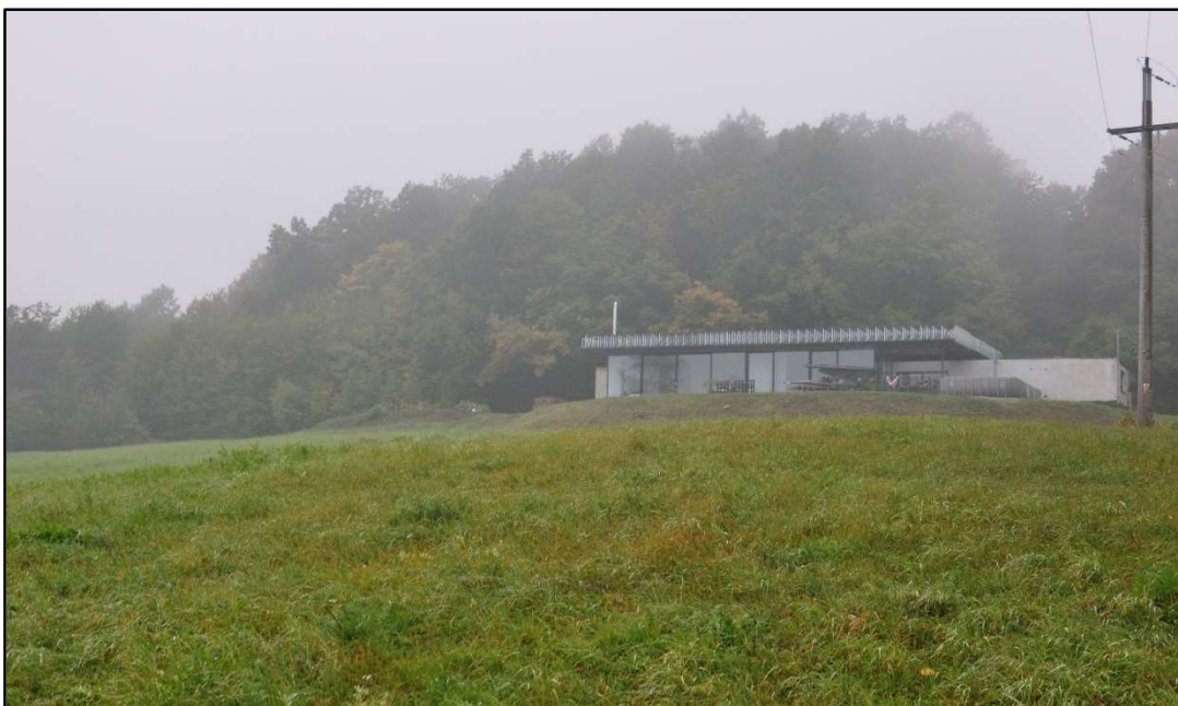
Fot. 12. Działka nr 238/2 widoczna od południowego- wschodu (z dołu) w kierunku budynku mieszkalnego w budowie (Fot. własna z dnia 16 X 2020 r.)
