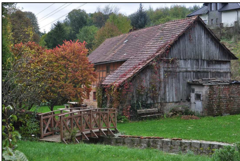
Fot. 15. Budynek mieszkalno-gospodarczy nr 63 na potoku Ośna, za nim droga i wysoka skarpa, na której stoi budynek nr 62A (Fot. własna z dnia 21 X 2020 r.)
