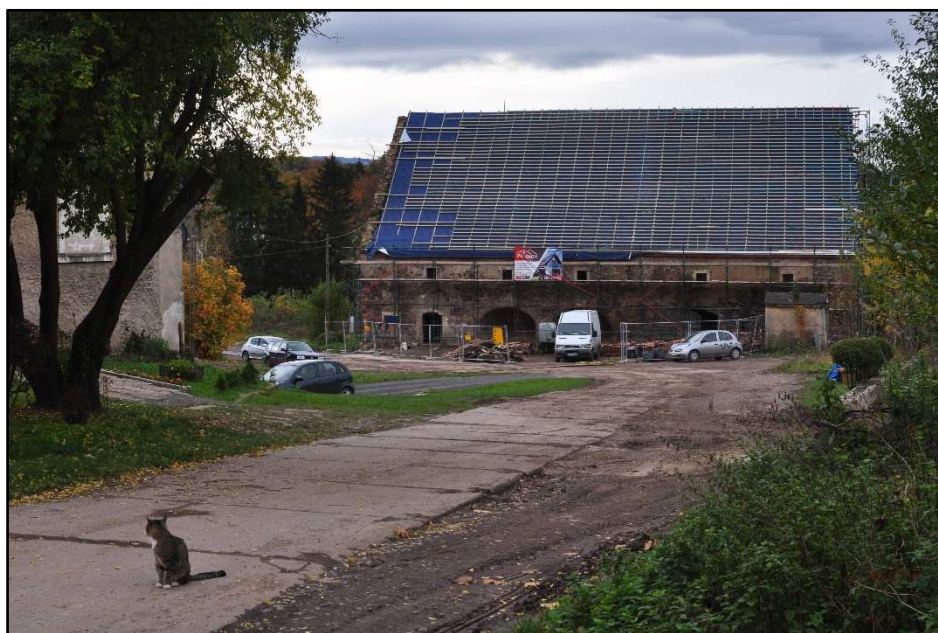
Fot. 5. W centralnej części wydzielenia znajduje się zabytkowy, remontowany spichlerz – wgląd od strony zachodniej (Fot. własna z dnia 28 X 2020 r.)
