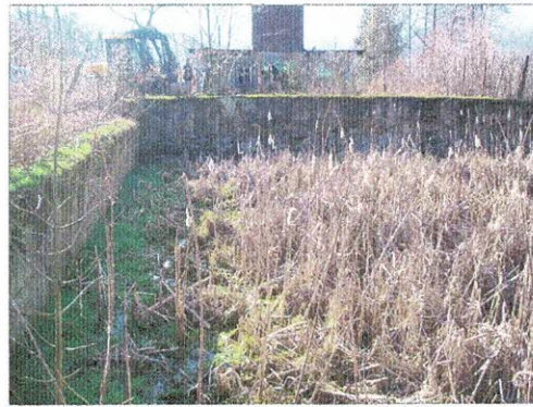
Foto nr 4. Widok zbiornika od strony wschodniej
