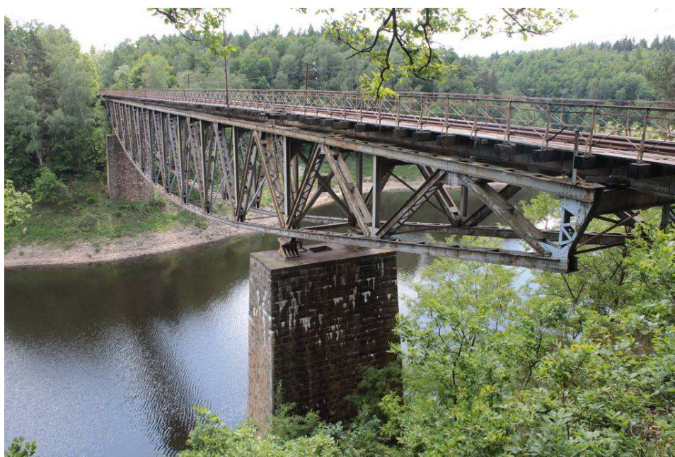
Most kolejowy nad zalewem Pilchowice
