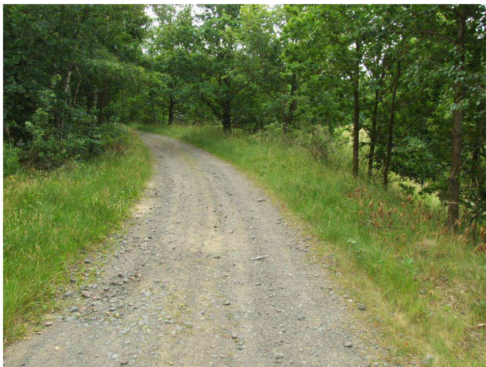
Droga powiatowa z zapory Pilchowice do Pasiecznika
