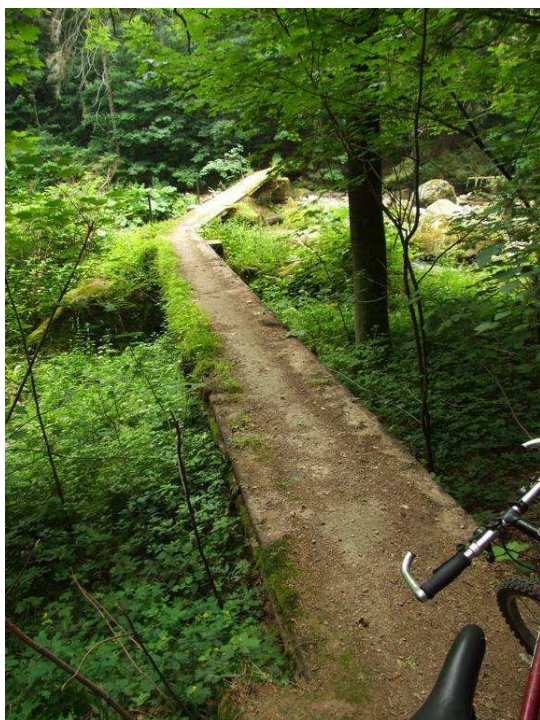
Kładka na rzece Kamienica
