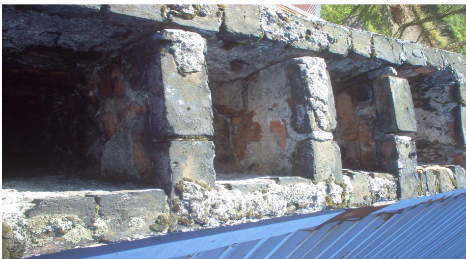
fot. 11. Widok kanałów w kominie wentylacyjno - dymowym w budynku A; autor: A.Langer
