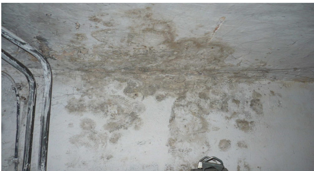
fot. 5. Zawilgocone ściany i strop nad piwnicą budynku A
