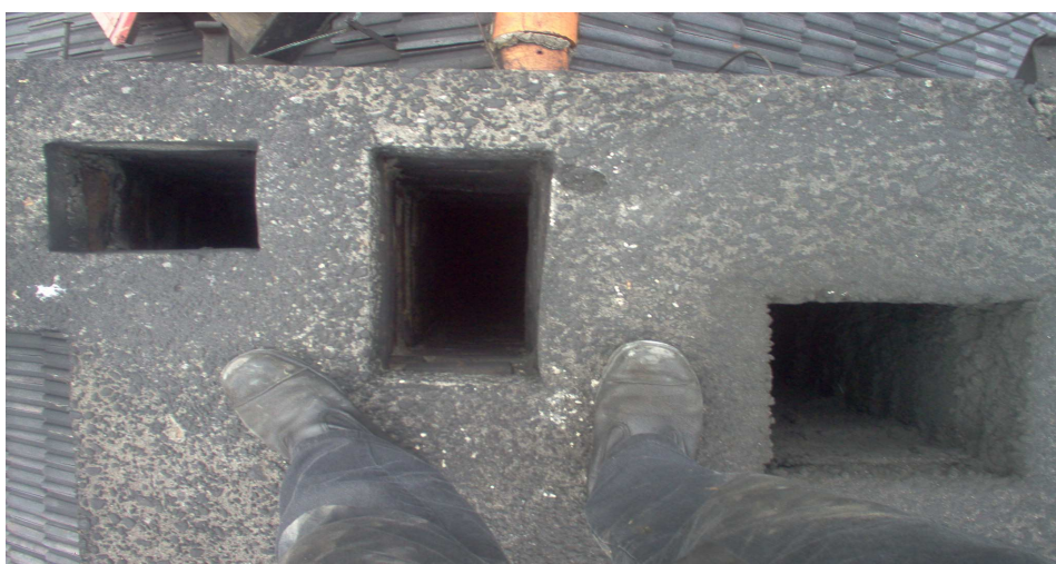
fot. 10. Widok kanałów w kominie wentylacyjno - dymowym w budynku B; autor: A.Langer
