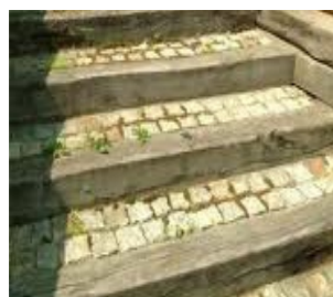
SCHODY Z PODKŁADÓW KOLEJOWYCH WYPEŁNIENIE KOSTKĄ
