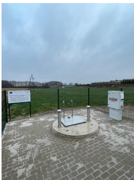
Zdjęcie 11. Budowa kanalizacji sanitarnej w miejscowości Czechel – etap II
