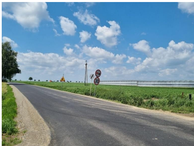
Zdjęcie 9 i 10. Przebudowa drogi powiatowej nr 4327P w m. Popówek
