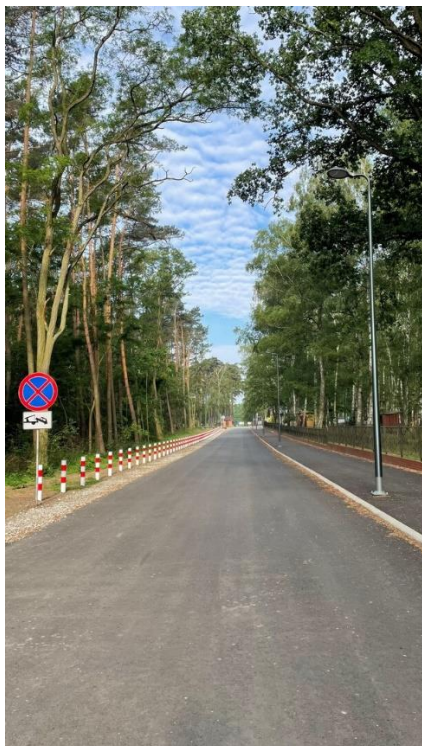
Zdjęcie 5 i 6. Budowa ul. Leśnej w Gołuchowie
