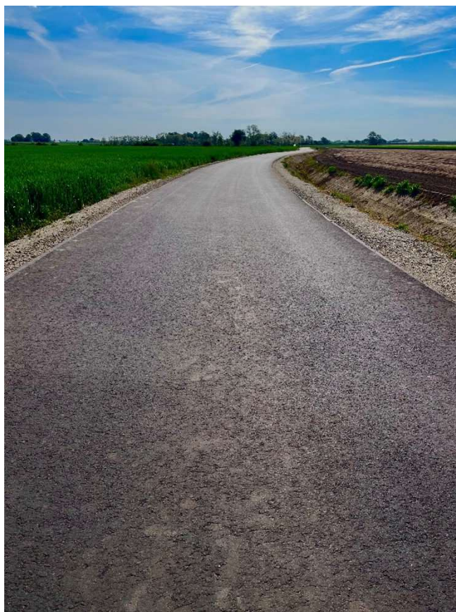
Zdjęcie 5. BUDOWA DROGI GMINNEJ CZECHEL-BORCZYSKO – ETAP II
