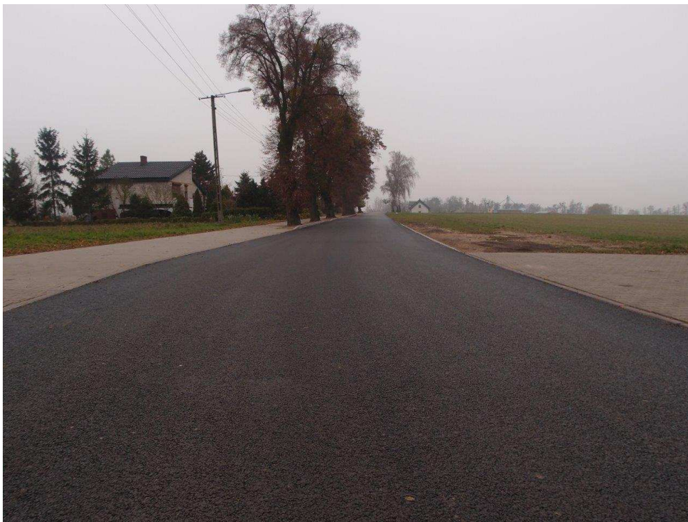
Zdjęcie 3. Remont drogi gminnej Czechel – Kucharki
